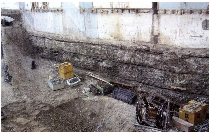
**Abb. 23** Dufourstrasse 36, 2005/14. Die südliche Brandmauer, eine Betonmauer des 20. Jahrhunderts, zeigt die Spuren einer in Etappen durchgeführten Unterfangung, die bei der Anlage des Kellers des Nachbarhauses Dufourstrasse 38 nötig wurde. – Foto: Christoph Matt.
