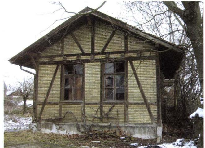
**Abb. 7** Äussere Baselstrasse 387, Riehen – Bäumlhof (2005/87). Südliche Giebelfassade des Ökonomiebaus. Fachwerkteilung und Befensterung sind streng symmetrisch angeordnet. – Foto: Basler Denkmalpflege.
