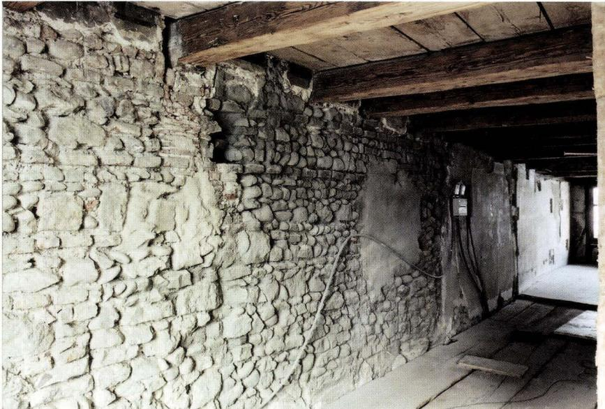
**Abb. 3** Spalenberg 29 (2004/478). Die Westbrandmauer im 3. Obergeschoss. Blick von Süden in Richtung Spalenberg. Die Brandmauer zum Nachbarhaus Nr. 31 ist vor Untersuchungsbeginn mit einer Schicht Zementmörtel zugedeckt worden. Das Mauerbild ist zwar erkennbar, doch der Zustand ist für die Dokumentation ungeeignet. Im Hintergrund sind belassene Verputzflächen. Dort wurden nur punktuell Sondierungen vorgenommen. – Foto: Basler Denkmalpflege.
