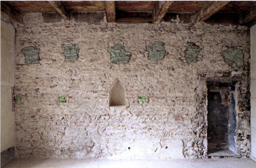
**Abb. 13** Lindenbergs 12 (2004/339). 1. OG, lindenbergsseitiger Gebäudeabschnitt. Die lindenbergsseitige Mauer des früheren Hauses C. Die dem Gebäudeinnern zugewandte Mauernische ist im Mauerwerk original angelegt. Auf gleicher Höhe liegt eine Reihe von Bälkchennegativen des Baugerüsts (grün). Die Deckenbalken lagen ursprünglich weiter unten; die frühere Deckenhöhe ist an den vermauerten Balkenkopfausbrüchen ablesbar. – Foto Basler Denkmalpflege.
