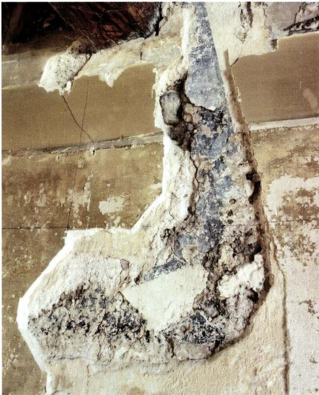
sich vom Mörtel des mittelalterlichen Mauerwerks der übrigen Brandmauern deutlich. Das 3. Obergeschoss ist also jünger als die unteren Geschosse. Die Spitzgiebelnische wurde in der Westbrandmauer als Auflager für einen der Deckenbalken verwendet (Abb. 12). Ein Vergleich der Deckenbalken mit den Bodenbalken verdeutlicht zusätzlich, dass es sich um Balkenreihen handelt, die zu zwei verschiedenen Bauphasen gehören. Der Querschnitt der Bodenbalken ist auffallend schlanker (siehe Abb. 4).
