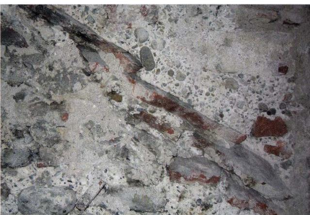
**Abb. 12** Lindenberg 12 (2004/339). 2. OG, rheinseitiger Gebäudeabschnitt. Unterhalb der Dachlinie von Haus A ist eine Reihe von Dachziegeln ins Mauerwerk eingebunden. Die Ziegelplatten sind abgeschlagen. Der Befund zeigt, dass beim Bau von Haus A rheinseitig ein Gebäude anschloss, welches bereits bestand oder mit Haus A zusammen errichtet wurde. – Foto: Basler Denkmalpflege.
