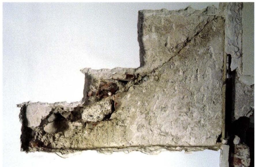
**Abb. 6** *Lindenberg 12 (2004/339). 2. OG, lindenbergseitiger Gebäudeabschnitt. Erkennbar ist die Dachlinie der lindenbergseitigen Giebelmauer von Haus A (Aussenseite). Die Mauer schliesst oben mit einer zur hinteren Gebäudeseite hin geneigten Fläche ab. – Foto: Basler Denkmalpflege.*
