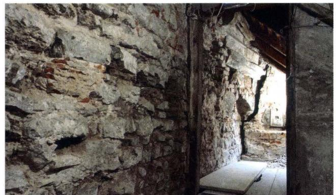
**Abb. 7** Rheinsprung 8 und 10, Stützmauer der Martinskirche (2003/346 und 2003/443). Dachgeschoss von Rheinsprung 10. Blick von Osten auf die 1995 freigelegte Stützmauer. Im Hintergrund einer der beiden Blendbogen mit Gurtgesims und Brüstungsplatten. Der 2005 abgebrochene Kamin verdeckt den zweiten Bogen. Die Stützmauer ist nicht in gutem Zustand. – Foto: Basler Denkmalpflege (1995).
