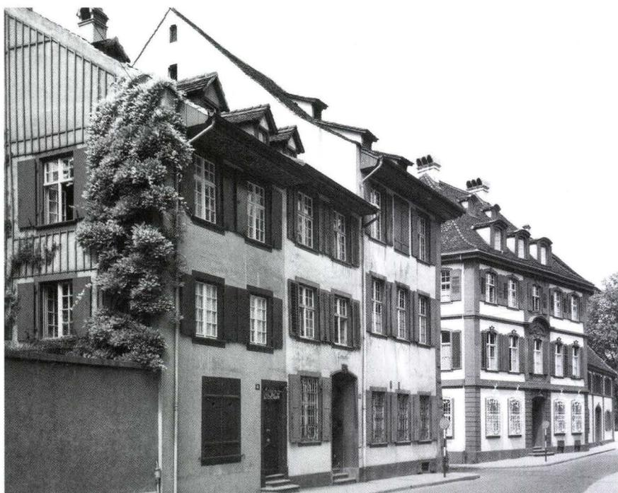
**Abb. 1** Rittergasse 12 (2003/27). Die Dreiergruppe der Häuser ist seit 1916 wegen Brandmauerdurchbrüchen faktisch zu einem einzigen Gebäude verschmolzen. Die Fenster in der Giebelwand des Eckgebäudes links (Nr. 16) sind nach dem Abbruch des Torhauses zur Domprobstei entstanden. – Foto: Peter Heman, 1952.
