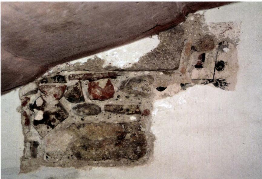
**Abb. 22** Lindenberg 12 (2004/339). EG, Treppenturm, hintere Turmmauer. Die Blockstufen der Spindelstiege sind ins Mauerwerk des Vorgängerbaus eingeflickt. Die Fassung mit Rotband, Bollenband und Pfauenaugen, welche in die Turmmauern eingebundene Blockstufen begleitete, bezieht sich möglicherweise auf eine erste, hölzerne Stufenkonstruktion. Die bestehenden Stufen aus Stein wurden später an der Unterseite überarbeitet. – Foto: Basler Denkmalpflege.
