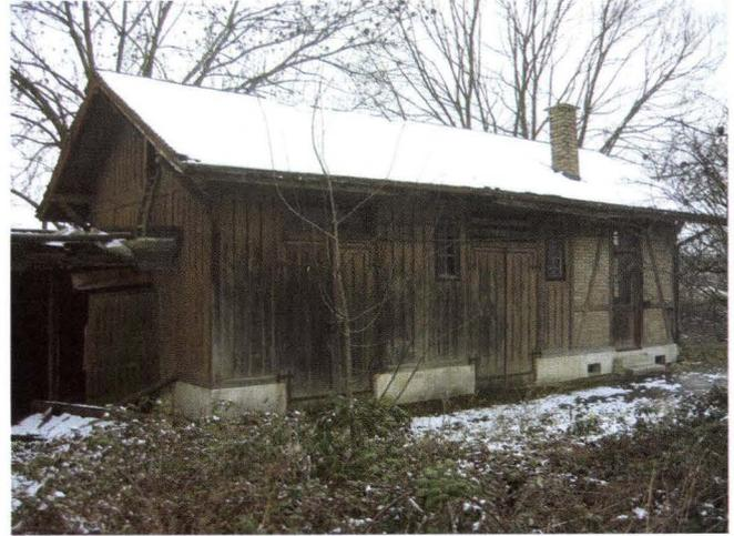
**Abb. 6** Äussere Baselstrasse 387, Riehen – Bäumlhof (2005/87). Der Ökonomiebau mit verbrettertem Scheunenteil und davon abgetrenntem Eckraum. Dieser wird von mit Backstein gefülltem Fachwerk umschlossen. Dieses schön gestaltete Gärtnergebäude soll als einziges auf dem Areal erhalten werden. – Foto: Basler Denkmalpflege.
