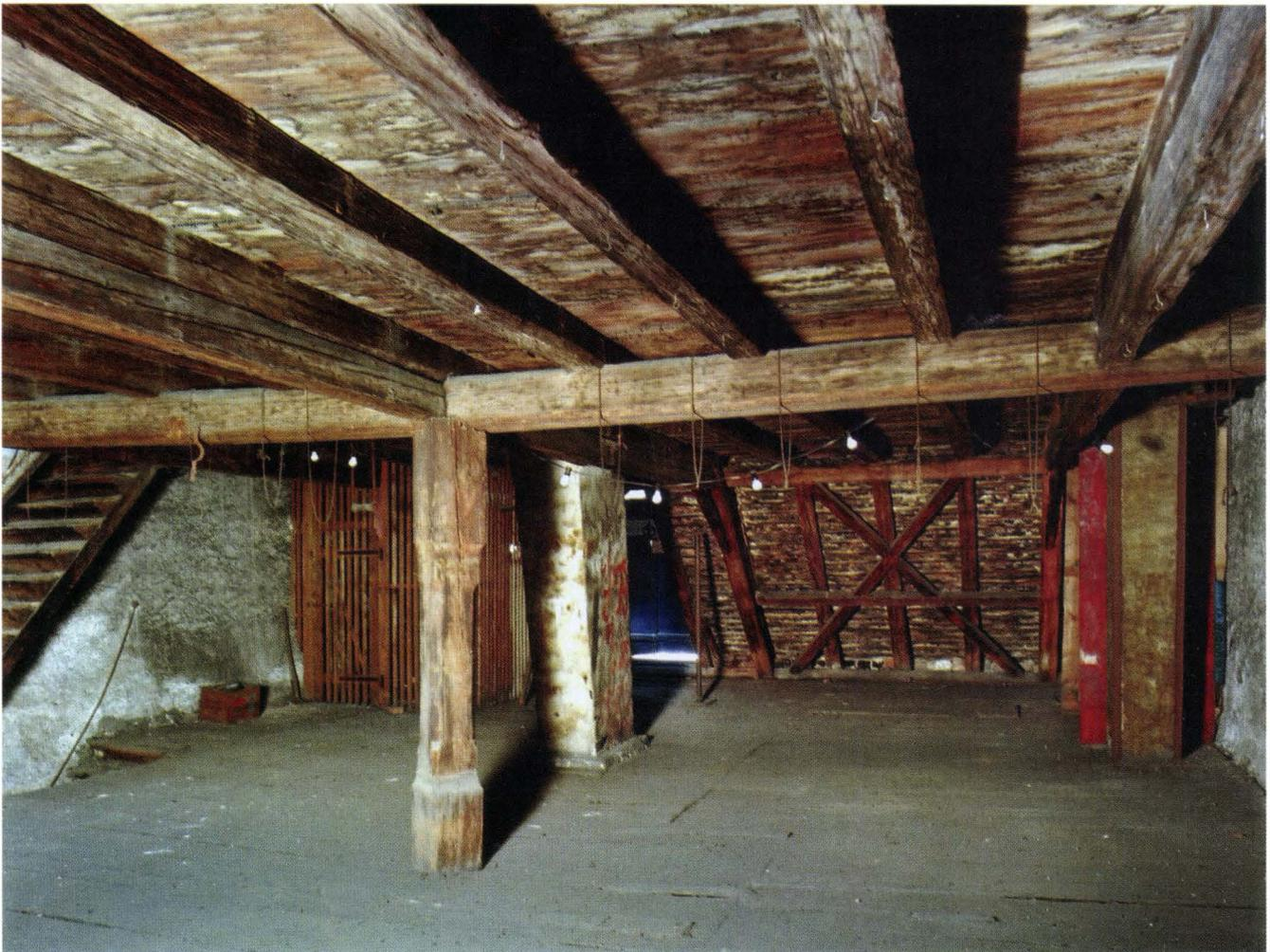
**Abb. 5** St. Alban-Vorstadt 35 (2005/663). Liegender Dachstuhl von 1579. Im unteren Geschoss werden die Kehlbalken durch einen Mittelunterzug unterstützt. Der Kopf der über Eck gestellten Säule umgreift den Unterzug nicht (wie üblich), da die eingestemmen Spannriegel des mittleren Binders dies verhindern. Im Hintergrund ist die rheinseitige Dachfläche mit dem Anderskreuz, das zwischen Fuss- und Mittelfette eingespannt ist, zu erkennen. – Foto: Basler Denkmalpflege.
