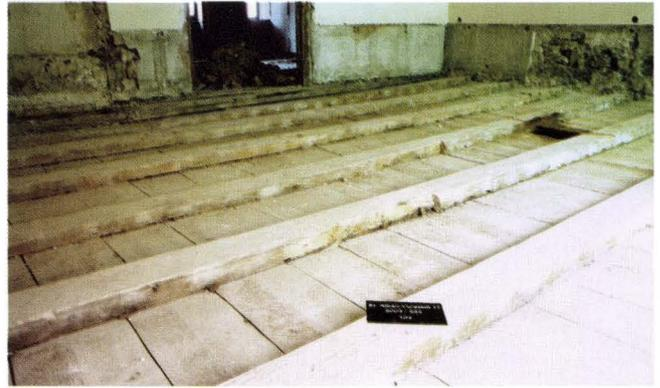
**Abb. 14** St. Alban-Vorstadt 17 – Zum Geist (2003/252). Erstes Obergeschoss. Schiebeboden im strassenseitigen Raum an der Ostbrandmauer. – Foto: Basler Denkmalpflege, Andreas Stulz.
