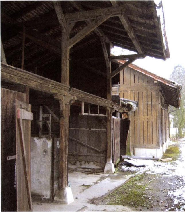
**Abb. 5** Äussere Baselstrasse 387, Riehen – Bäumlhof (2005/87). Ökonomiebauten: vorne die offene Remise, in der Mitte ein offener Unterstand, hinten das Gebäude, dessen Scheunenteil so verbrettert ist, dass regelmässig angeordnete Luftschlitze entstehen. – Foto: Basler Denkmalpflege.
