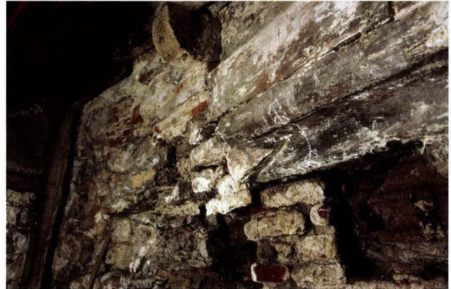
**Abb. 22** Rheinsprung 8 und 10, Stützmauer der Martinskirche (2003/346 und 2003/443). Blick auf den Abschlussstein des Gurtgesimses mit der in die Hohlkehle greifende Keilform. Deutlich wird, wie das durch Ausflickung untermauerte Gurtgesims in der Stützmauer keine Fortsetzung findet. – Foto: Basler Denkmalpflege (1995).
