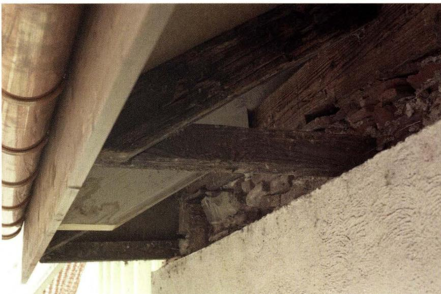
**Abb. 9** Gerbergasse 63 (2005/725). Dachfussausbildung an der Gerbergasse. Die später angebrachten Aufschieblinge liegen auf einem zum Dachwerk sekundären Schwellbalken auf, welcher in einer Aufmauerung der Aussenwand eingebettet ist. In der Verlängerung der Dachbalken wurden ausserdem kurze Bälkchen angesetzt, welche mit den Enden der Aufschieblinge abschliessen und die Tragkonstruktion für den Dachhimmel bilden. – Foto: Basler Denkmalpflege.
