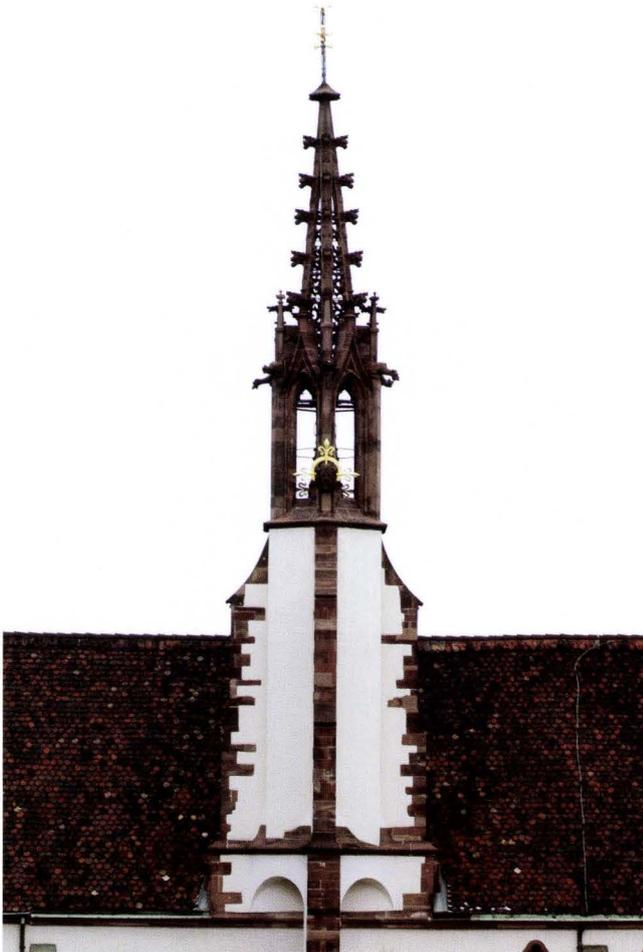
Im Jahre 2004 wurde der schlechte Zustand dieses Masswerkhelms offenbar. Die Befürchtung, dass defekte Teile herunterstürzen könnten, machte eine Instandstellung des Hausteingefüges nötig.
