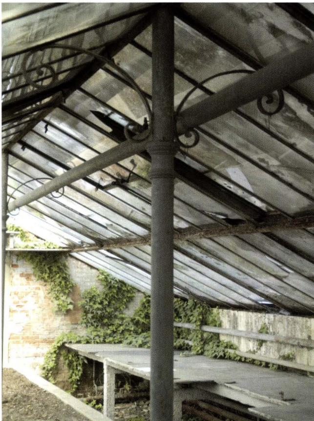
Das Gewächshaus belegte mit seinen beiden von einem erhöhten Eckpavillon ausgehenden Flügelbauten die Mittelachse der Gartenparzelle (Abb. 10). Die über einem Backsteinsockel aufgeführte verglaste Eisenkonstruktion hatte eine architektonisch und räumlich reizvolle Wirkung und war im Detail sehr schön ausgestaltet (Abb. 11). Am Kopf des kürzeren Querflügels befand sich die Eingangstüre, deren Sturz dem Giebelndreieck der Backsteinfassade angepasst war (Abb. 12).
