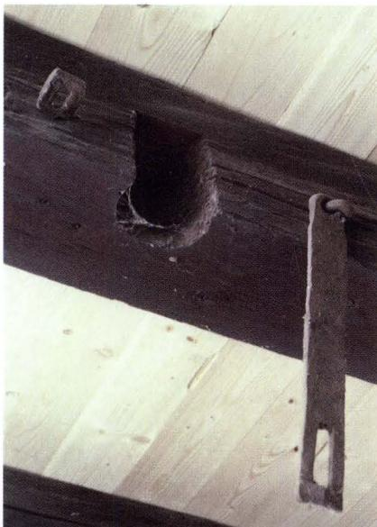
Der mittlere untere Kehlbalken zeigt zur Gerbergasse hin eine zylindrische, einst als Drehlagerbuchse für eine Aufzugswelle dienende Aussparung mit einer die Welle sichernden Eisenschelle (Abb. 11). Das Gegenlager der vertikal angeordneten Drehachse im Dachbalken darunter ist als Flickstelle im Bretterboden ablesbar. Ein Bundbalken weist schräg übers Eck angeordnete Bohrlöcher auf, die während des Flössens des verwendeten Bauholzes der Aufnahme der Flossstricke dienten (Abb. 12)<sup>16</sup>.
