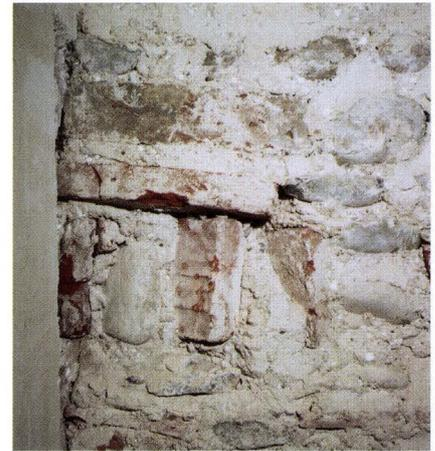
**Abb. 14** Lindenbergs 12 (2004/339). 1. OG, lindenbergsseitiger Gebäudeabschnitt. Das Bälkchen des Baugerüsts in der nördlichen Gebäudeecke von Haus C wurde in diagonaler Ausrichtung eingemauert und mit Ziegelsteinen verkeilt. – Foto: Basler Denkmalpflege.
