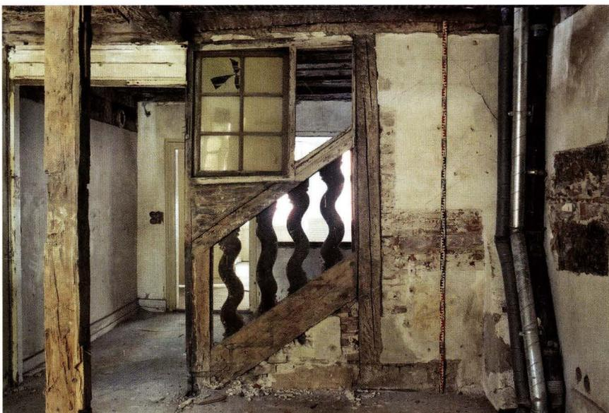
**Abb. 13** Rebgrasse 13 (2005/23). Blick auf die östliche Zwischenwand im 1. Obergeschoss mit dem Rest einer Treppenanlage zum 2. OG. Rechts die nordseitige Brandmauer zu Haus Nr. 11. Das Fragment der Treppe wurde während der Untersuchung freigelegt. Es stammt aus dem Umbau von 1721. Die vier Brettbaluster sind bloss ausgesägt. Der Abbruch der Treppenanlage und die teilweise Schliessung der Wand erfolgte in der Mitte des 19. Jahrhunderts. – Foto: Basler Denkmalpflege.
