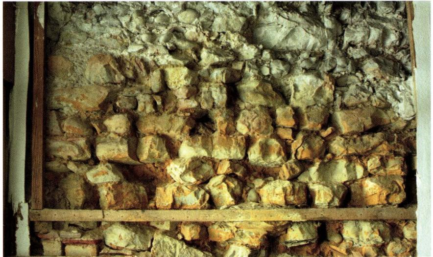
**Abb. 5** Spalenvorstadt 25 (2004/248). Die Ostbrandmauer im 2. Obergeschoss im strassenseitigen Raum. Im untern Bereich erkennt man den originalen Teil («Kernmauer»), dessen Abbruchkante nach rechts bis auf die Höhe der zugemauerten Balkenlöcher der 2. Bauphase ansteigt. Links die Nordostecke mit der Fassade von 1815, deren Material ein kleines Stück weit in die Brandmauer hineingreift. – Foto: Basler Denkmalpflege, Matthias Aebersold.
