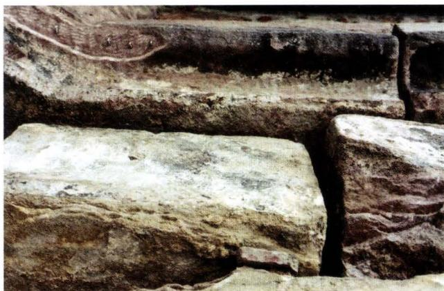
**Abb. 11** Rheinsprung 8 und 10, Stützmauer der Martinskirche (2003/346 und 2003/443). Blick von unten an das Gurtgesims (Ostseite des Erkers). Zustand vor der Sanierung 2005. Deutlich war die Verschiebung der Sandsteine und die Weitung der einst engen Mörtelfugen zu sehen. Die Erosion hat den Sandsteinen dort, wo der Erker oberhalb des Dachs von Rheinsprung 10 Wind und Wetter ausgesetzt ist, stark zugesetzt. – Foto: Basler Denkmalpflege (2005).
