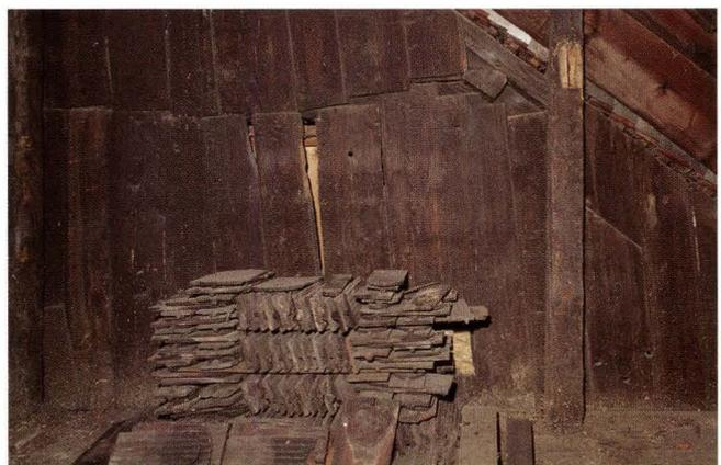
Die Fläche des oberen Giebeldreiecks wurde mit einer vom Kehlbalken bis an die Sparren reichenden Bretterreihe belegt, der Bereich unterhalb des Kehlbalkens mit weiteren, nur bis an die ältere Dachlinie des Vorgängerdachs hinunterziehenden Brettern verschlossen. Da die ältere Dachkonstruktion gegenüber dem neueren Dachwerk-Gebinde leicht vorspringt, wurde in die Sparren der älteren Konstruktion für den Anschluss der jüngeren Verbretterung ein Falz eingeschnitten (Abb. 15).
