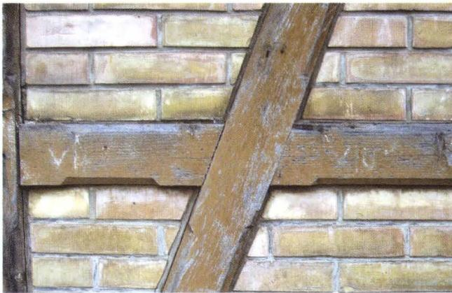
**Abb. 9** Äussere Baselstrasse 387, Riehen – Bäumlhof (2005/87). Der Nordgiebel des Ökonomiebaus. Die verbretterte Fassade der Remise ist mit gleichmässig ausgesägten Vertikalschlitzeln verziert. An den konstruktiven Hölzern zeigen sich die typischen Ausformungen mit flachen Karniesunterseiten und Wulstprofilen. Die Rahmen und Ständerhölzer der Fassadenkonstruktion sind jeweils mit feinen Zierfasen gebrochen. – Foto: Basler Denkmalpflege.
