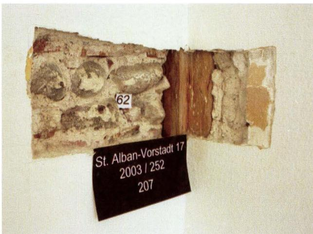
**Abb. 13** St. Alban-Vorstadt 17 – Zum Geist (2003/252). Zweites Obergeschoss, Nordostecke des mittleren strassenseitigen Raumes. Gefälzter Eckständer im Winkel der Fachwerkwand von 1719. – Foto: Basler Denkmalpflege, Andreas Stulz.
