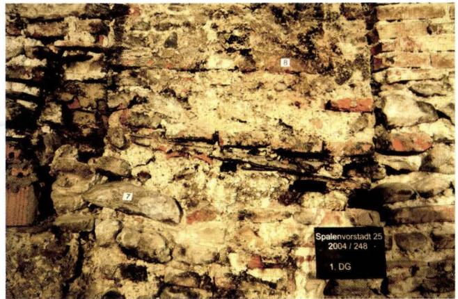
**Abb. 9** Spalenvorstadt 25 (2004/248). 1. Dachgeschoss, Westbrandmauer. Der Ausschnitt zeigt Reste von Holzschindeln des schwach geneigten ersten Daches. Darüber erhebt sich ein zahnartiger Aufsatz, der ebenfalls zum ältesten Teil der Brandmauer gehört. Diese wurde vermutlich im späten 14. Jahrhundert errichtet (nach dem Erdbeben von 1356). – Foto: Basler Denkmalpflege, Hans Ritzmann.
