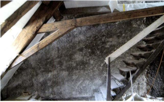
**Abb. 21** Spalenvorstadt 25 (2004/248). 1. Dachgeschoss, Blick gegen die Ostbrandmauer. Oben im Vordergrund ein Balken des zweiteiligen Spannriegels. Dahinter an der Brandmauer die alte Blocktreppe, welche 2005 in situ belassen und restauriert worden ist. – Foto: Basler Denkmalpflege, Matthias Aebersold.
