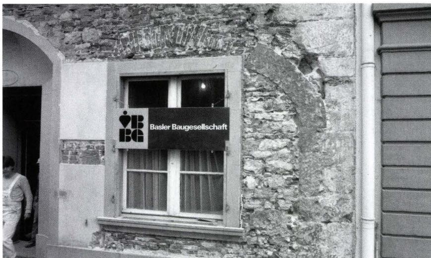
dieser Bauetappe. Unterhalb dieses Mauerstücks belegt der Rest eines abgeschlagenen Gurtgesimses, dass die Gebäudeerweiterung das vorhandene Gurtgesims aufnahm und wohl über die gesamte Breite der angefügten Fassadenhälfte verlängerte. Spuren originaler Befensterungen konnten allerdings mit Ausnahme einer auf einen Fenstereinbau hindeutenden vertikalen Begrenzung im oberen Mauerfragment keine festgestellt werden.
