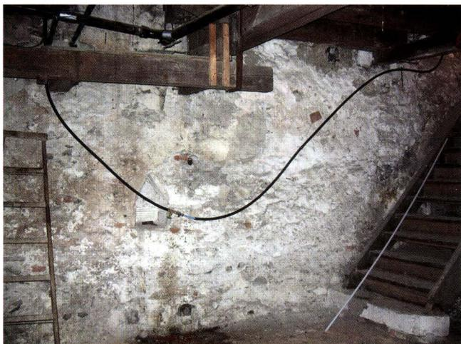
**Abb. 17** Rebgasse 13 (2005/23). Die nordseitige Kellermauer mit spitzgiebliger Nische vor den Freilegungsarbeiten. Der Keller ist durch eine Unterfangung der Fundamentmauern geschaffen worden. Die Treppe führt vom erst 1872 erstellten Treppenhaus in den Kellerraum. Die Unterkante der unterfangenen Nordbrandmauer liegt in der Mitte zwischen dem oberen Nischenabschluss und der Unterkante der Deckenbalken. – Foto: Basler Denkmalpflege.
