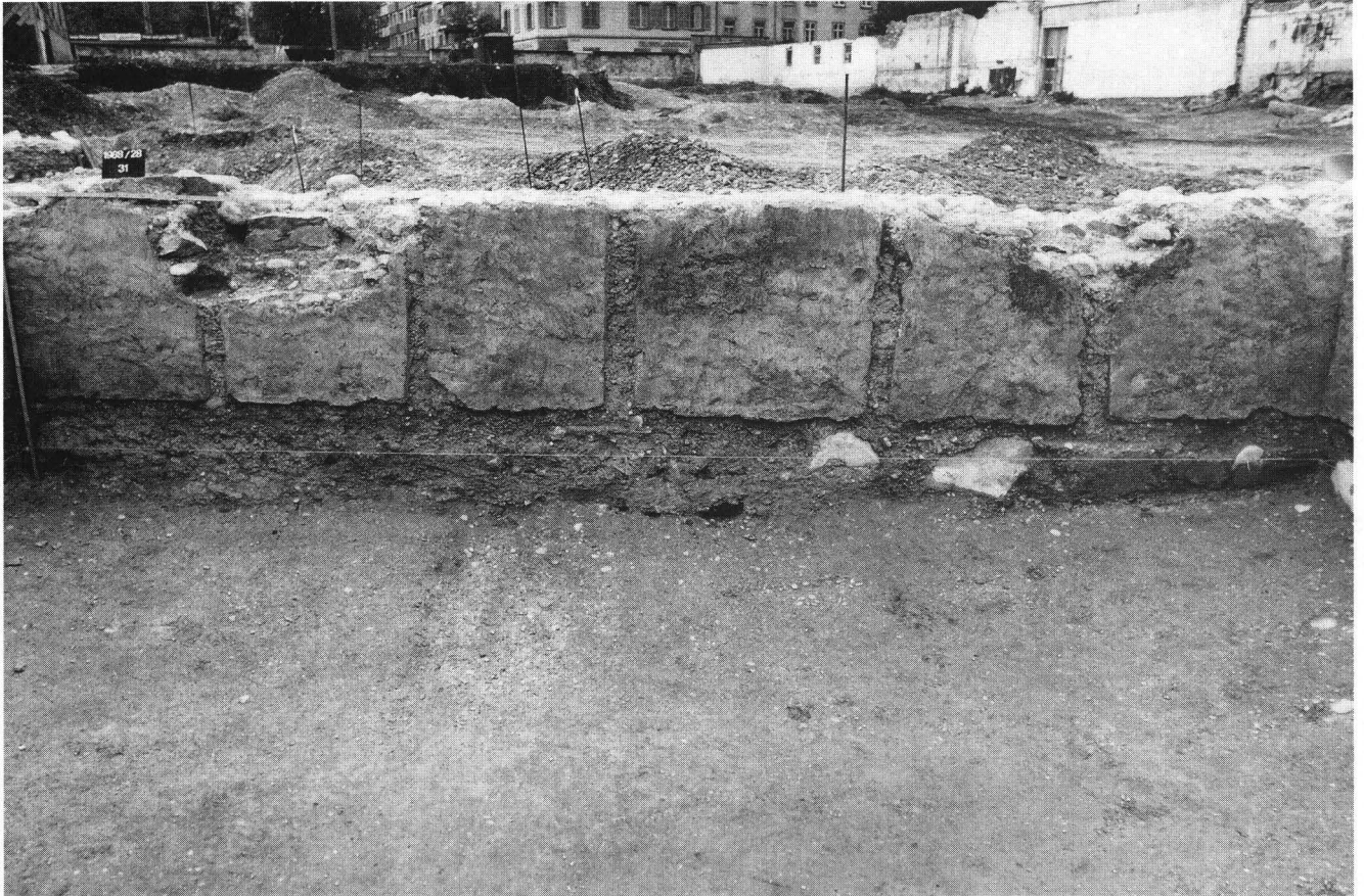
Abb. 12. Wirtschaftsgebäude B: Westwand mit Putz und Aussparungen (Balkenabdrücke). Der Mörtelboden hängt gegen die Mitte durch.
