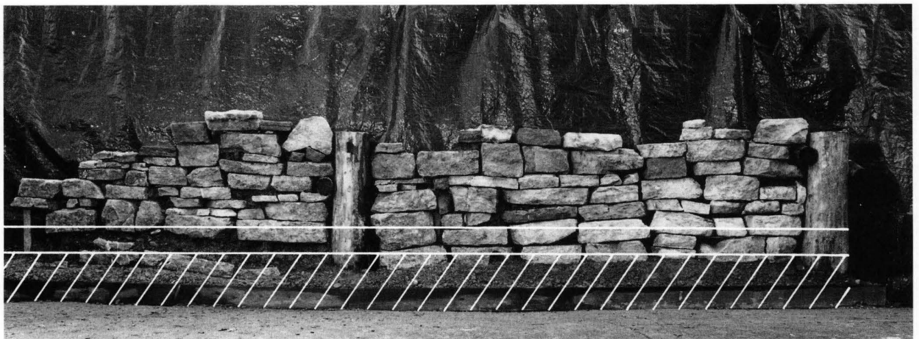
Abb. 2. Wiederaufgerichtete Front des Murus Gallicus (1991/19, Fläche 3, und 1992/16, Fläche 3): rechte (östliche) Hälfte einphasig (wiederaufgerichtet in Keller B), linke (westliche) Hälfte der Trockenmauer repariert. Neben den Frontpfosten sind die Balkenköpfe der kurzen Pfostenanker zu sehen.
