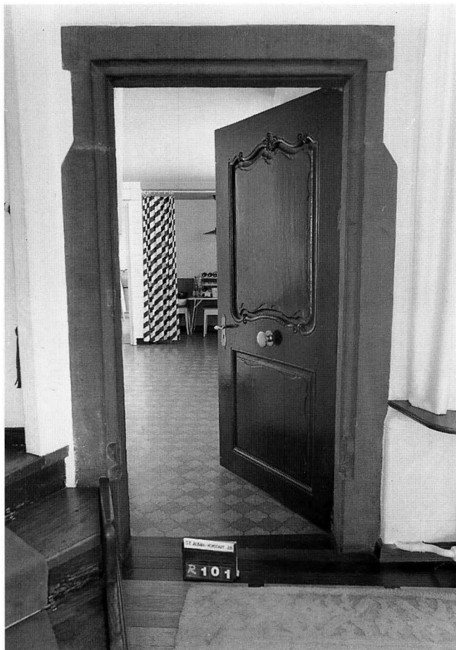
Abb. 8. St. Alban-Vorstadt Nr. 28. Türe im 1. Stock zum Hofflügelbau (Abb. 7: R 103). Profiliertes Sandsteingewände, nachträglich auf Türhöhe aufgehöhht. – Foto: BaDpfl. (M 416–17).
