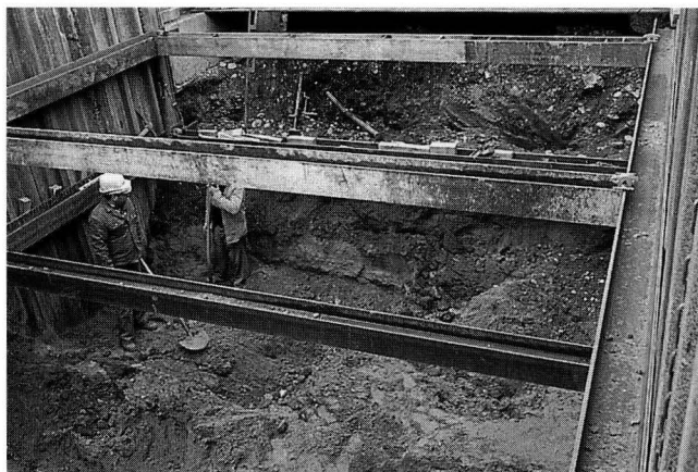
Abb. 3. Fabrikstrasse (A), Leitungen, 1995/16. Grabungsfläche in der Voltastrasse. – Foto: I. Wörner.
