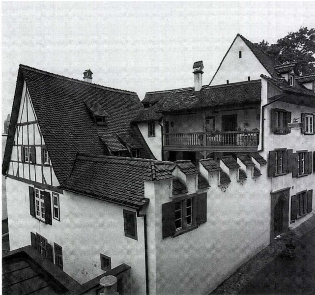
Abb. 4 Der Ringelhof (Petersgasse 23) auf dem Petersberg in Basel. Der Grundriss der mittelalterlichen Vorgängerbauten ist deutlich erkennbar: Haus des Heinrich von Bütenheim (linker Teil), Haus des Sigbert (rechter Teil), Haus zum Museck (hintere Hälfte des rechten Teils). – Foto: Peter Portner, Historisches Museum Basel.
