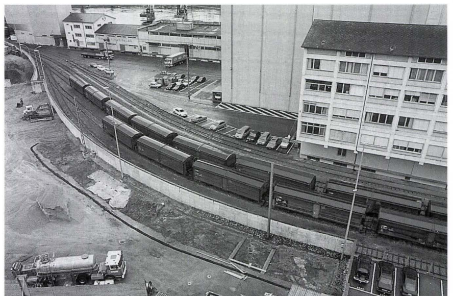
Abb. 2 Fabrikstrasse 40, Geleiseneubau Etappe 1, 1999/12. Grabungsfläche nach Voraushub.
