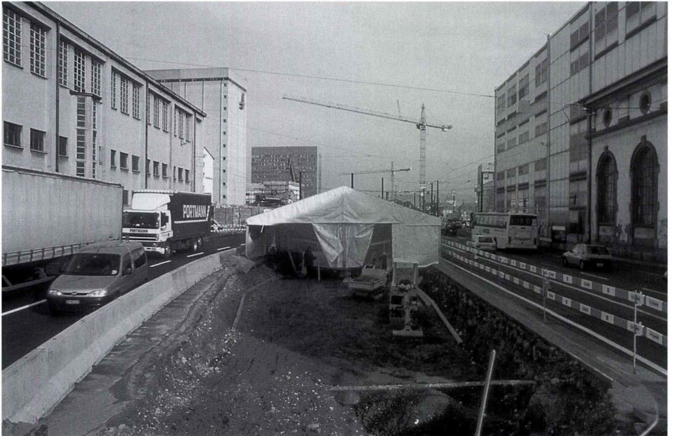
Abb. 12 Voltastrasse (A), Deckel Nord 2, 1999/39. Grabungssituation im rollenden Verkehr.
