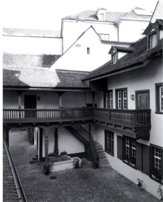
Abb. 8 Nordostflügel und nordwestliche Hofbegrenzung des Rollerhofs. – Foto: Kunstdenkmälerinventarisierung BS, E. Schmidt.
