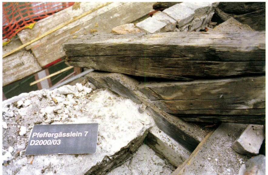
Abb. 60 Schneidergasse 28 / Pfeffergässlein 7 (D 2000/03). Pfeffergässlein 7, Dachfuss auf der Gassenseite. Auf der Gassenseite wurde eine im Vergleich zur Hofseite „moderne“ Lösung gewählt: Die Sparren sind in die Balken gezapft, während der Dachvorsprung von Aufschieblingen gebildet wird. – Foto: Basler Denkmalpflege.
