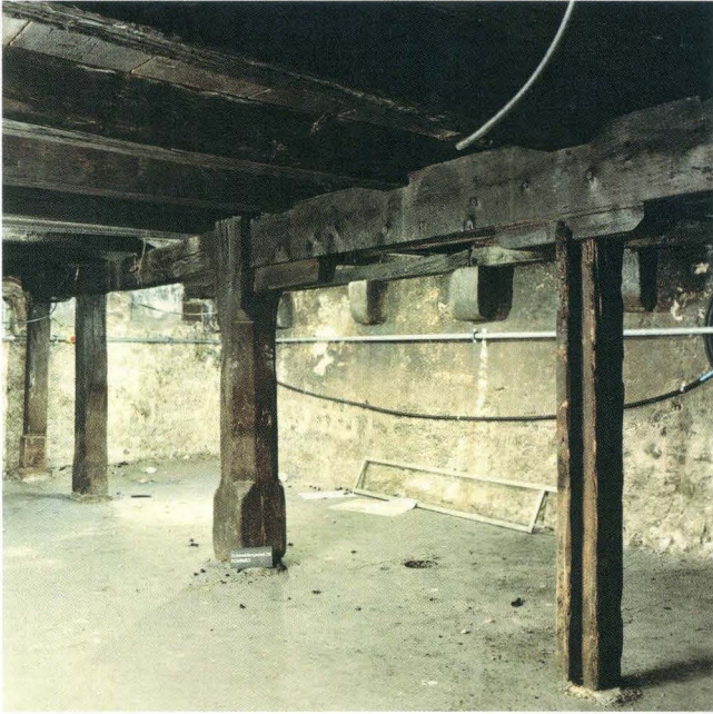
Abb. 33 Schneidergasse 28 / Pfeffergässlein 7 (D 2000/03). Schneidergasse 28, Keller. Blick Richtung Strassenseite und Brandmauer zu Haus Nr. 30. Die Balkendecke mit Mittelunterzug und zentraler Stütze entstand um 1535 als nachträgliche Einrichtung im bereits bestehenden, zuvor in der Tiefe verkürzten Kellerraum. Die seitlichen Ständer kamen erst später dazu. Das Holzwerk war infolge eines Brandschadens (von 1999) oberflächlich beeinträchtigt, konnte jedoch im Rahmen des Umbaus erhalten werden. – Foto: Basler Denkmalpflege.
