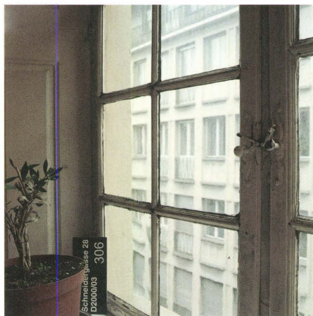
Abb. 3 Schneidergasse 28 / Pfeffergässlein 7 (D 2000/03). Schneidergasse 28, 3. OG, strassenseitiges barockes Fenster mit originalen Sprossen und Beschlägen. – Foto: Ruedi Walti.
