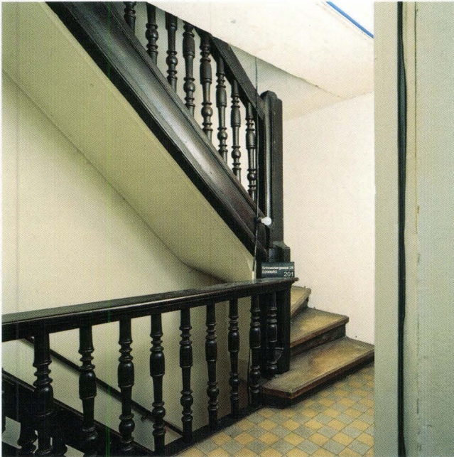
Abb. 7 Schneidergasse 28 / Pfeffergässlein 7 (D 2000/03). Schneidergasse 28, 2. OG. Barocke Treppe (um 1700) mit gedrechselten Doggen. – Foto: Ruedi Walti.
