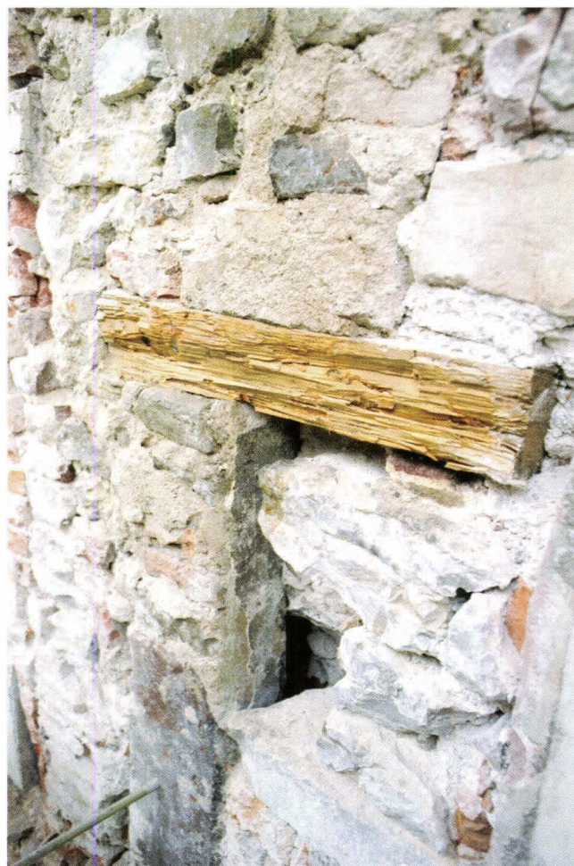
Abb. 50 Schneidergasse 28 / Pfeffergässlein 7 (D 2000/03). Pfeffergässlein 7, Hoffassade, 1. OG, mittlere Partie. Fragment eines in die erste Aufstockung (im späten 14. Jahrhundert) original eingebundenen Fensters mit gemörtelter Leibung und Holzsturz. – Foto: Basler Denkmalpflege.
