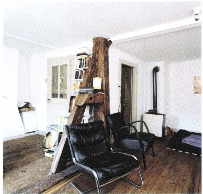
Abb. 14 Schneidergasse 28 / Pfeffergässlein 7 (D 2000/03). Schneidergasse 28, 4. OG/DG. Ausgebauter Dachraum zur Hofseite. In der Mitte der Stuhlbinder des Dachwerks; der abgesägte Stichbalken diente ursprünglich der Anbindung des Dachfusses, der vor der Einrichtung der Dachgaupe der Mauerkrone auflag. – Foto: Ruedi Walti.
