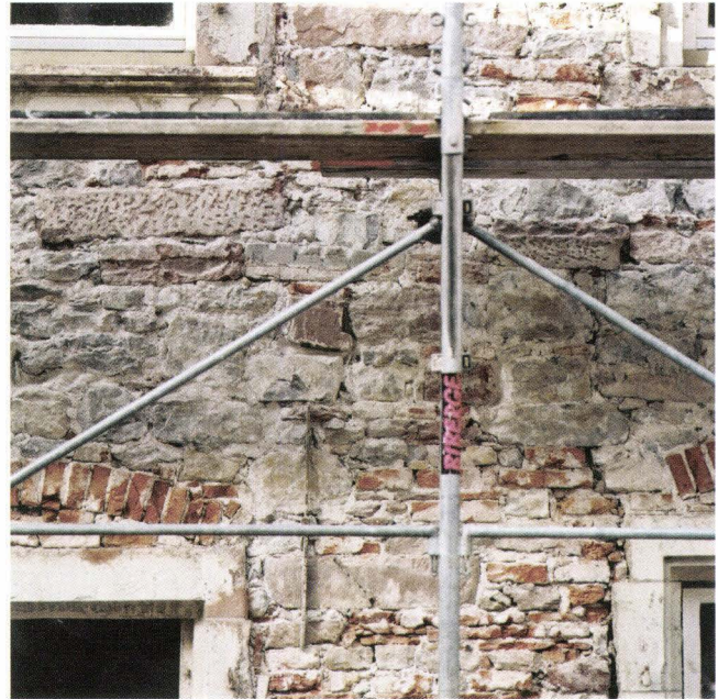
Abb. 53 Schneidergasse 28 / Pfeffergässlein 7 (D 2000/03). Pfeffergässlein 7, Hoffassade: Grossflächiges Einbau-Mauerwerk der umfassenden Neu-Befensterung im 1. und 2. OG. Das barocke Mauerwerk ist mit zahlreichen Spolien durchsetzt. – Foto: Basler Denkmalpflege.
