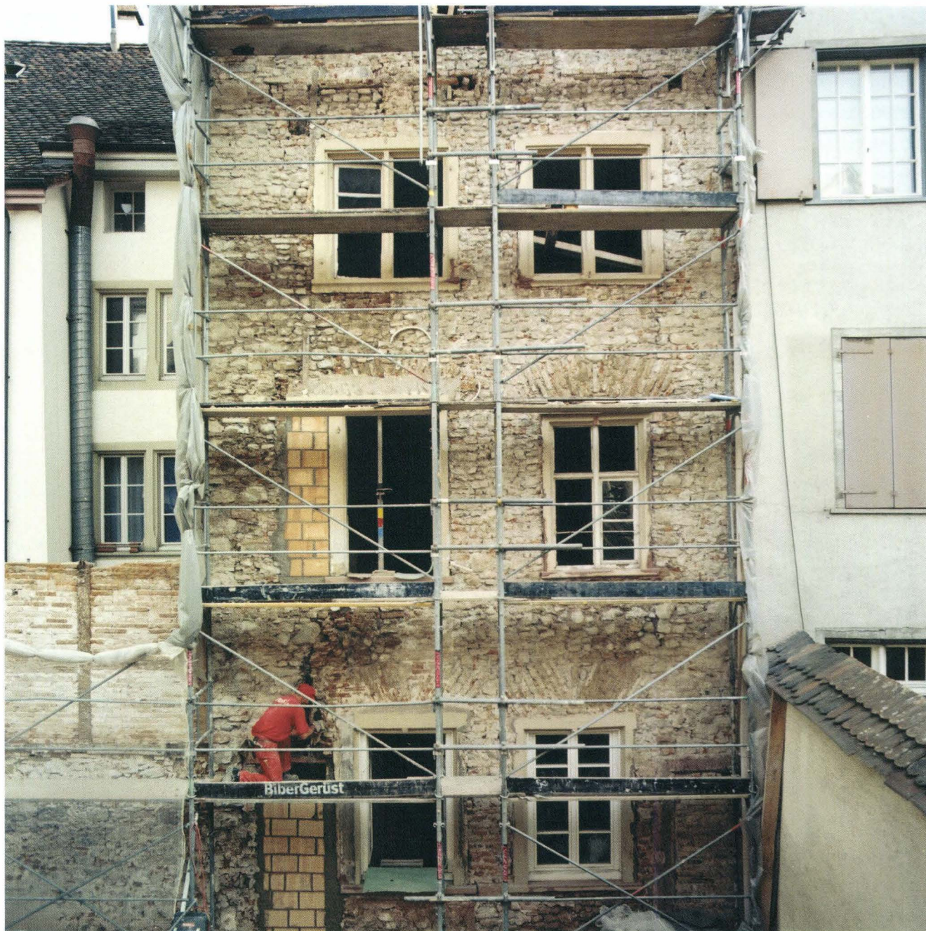
Abb. 30 Schneidergasse 28 / Pfeffergässlein 7 (D 2000/03). Schneidergasse 28, freigelegte Hoffassade, 1. bis 3. OG. Die Fassadenmauer aus der Bauzeit von 1363 ist über die ganze Höhe erhalten. Die beiden rechten Sandstein-Fenster des unteren und mittleren Geschosses sind in situ, die anderen sind nachträglich eingebrochen. Über den originalen Fenstern haben sich auch die zugehörigen Backstein-Entlastungsbögen im Mauerwerk vollständig erhalten. Rechts setzt die Mauer an die Nachbarfassade an, links steht sie frei. Auf der Mauerkrone (über dem obersten Gerüstbrett) sitzt das sekundär errichtete Dachwerk von 1493. Das originale Dach war auf gleicher Höhe, hatte jedoch eine flachere Neigung. – Foto: Basler Denkmalpflege.
