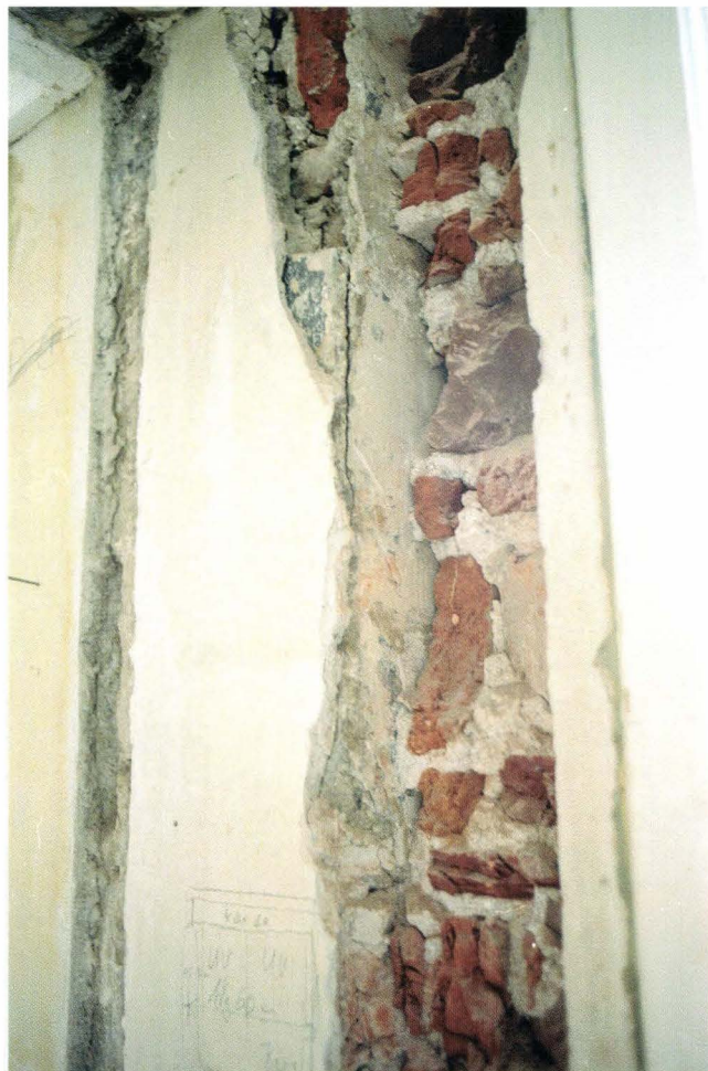
Abb. 41 Schneidergasse 28 / Pfeffergässlein 7 (D 2000/03). Schneidergasse 28, 2. OG. Vermauerte Fenster-Innenleibung in der Strassenfassade mit Farbspuren. Die wohl noch zu einem gotischen Fenster gehörende linke Innenleibung lag ca. 30 cm rechts der Mittelachse. Zur Zeit dieses Fensters war der strassenseitige Raum zweigeteilt. Die Vermauerung entstand im Zuge der spätbarocken Neubefensterung. – Foto: Basler Denkmalpflege.
