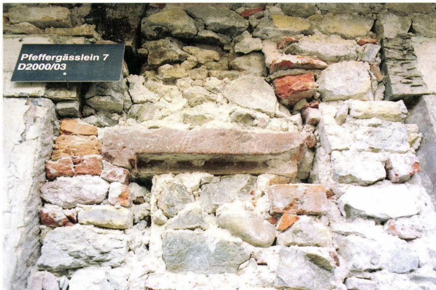
Abb. 52 Schneidergasse 28 / Pfeffergässlein 7 (D 2000/03). Pfeffergässlein 7, Hoffassade, 2. OG: mittleres grösseres Fenster mit Sturz und Bank aus Sandstein in der Aufstockung von 1480. – Foto: Basler Denkmalpflege.
