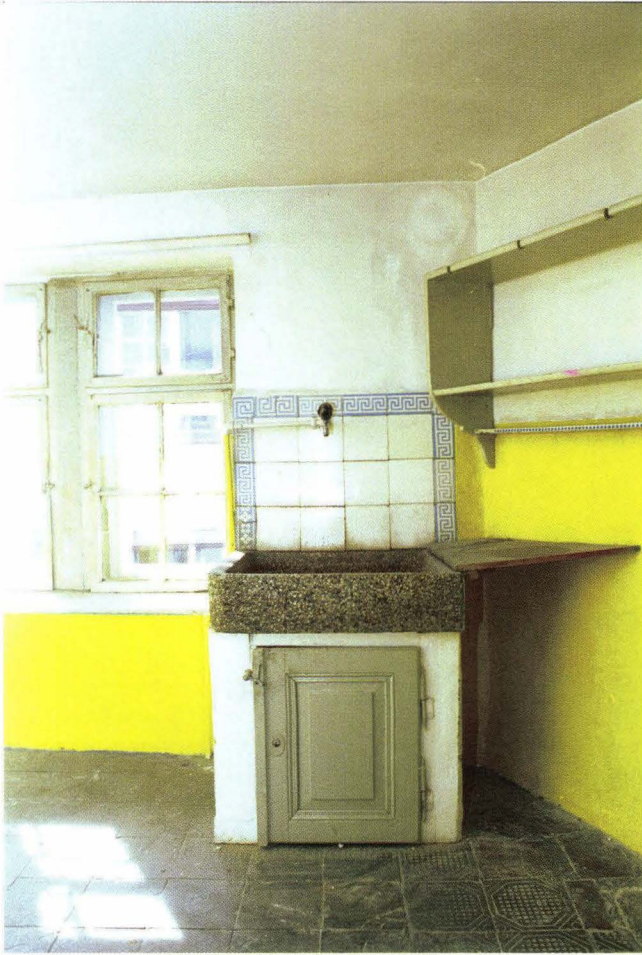
Abb. 23 Schneidergasse 28 / Pfeffergässlein 7 (D 2000/03). Pfeffergässlein 7, 2. OG. Die Ausstattung der Küche ist vom letzten Umbau im späten 19. Jahrhundert geprägt. Das Fenster ist bedeutend älter. – Foto: Basler Denkmalpflege.
