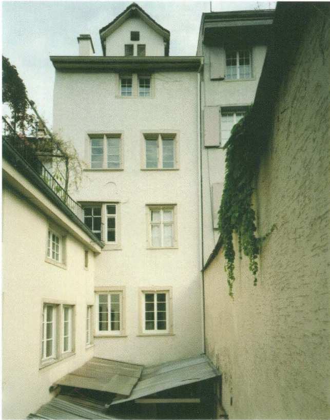
Abb. 4 Schneidergasse 28 / Pfeffergässlein 7 (D 2000/03). Schneidergasse 28, Hoffassade. Links der Flügelbau, rechts die hohe Parzellenmauer, der entlang früher eine Laubenverbindung zwischen Vorder- und Hinterhaus verlief. – Foto: Ruedi Walti.
