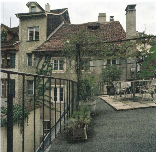
Abb. 27 Schneidergasse 28 / Pfeffergässlein 7 (D 2000/03). Hofflügelbau, Flachdach mit Blick zum Hinterhaus Pfeffergässlein 7. Die Dachterrasse entstand bei der Aufstockung nach 1856. – Foto: Ruedi Walti.
