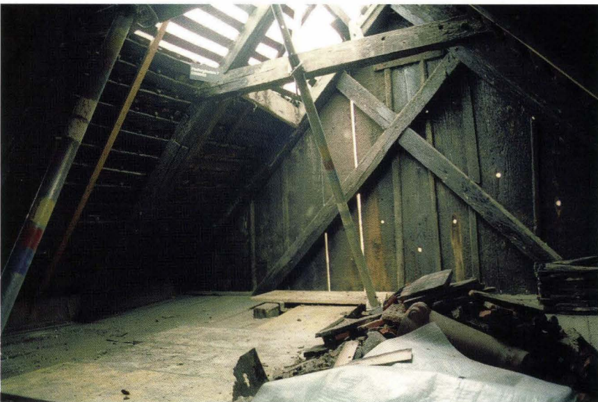
Abb. 58 Schneidergasse 28 / Pfeffergässlein 7 (D 2000/03). Pfeffergässlein 7, 2. Dachgeschoss. Die freistehende nördliche Giebelwand ist verbrettert. Der Binder mit den überkreuzten Streben ist ohne Firstständer konstruiert. Im Vordergrund ein Leergespärre mit Hahnenbalken. – Foto: Basler Denkmalpflege.
