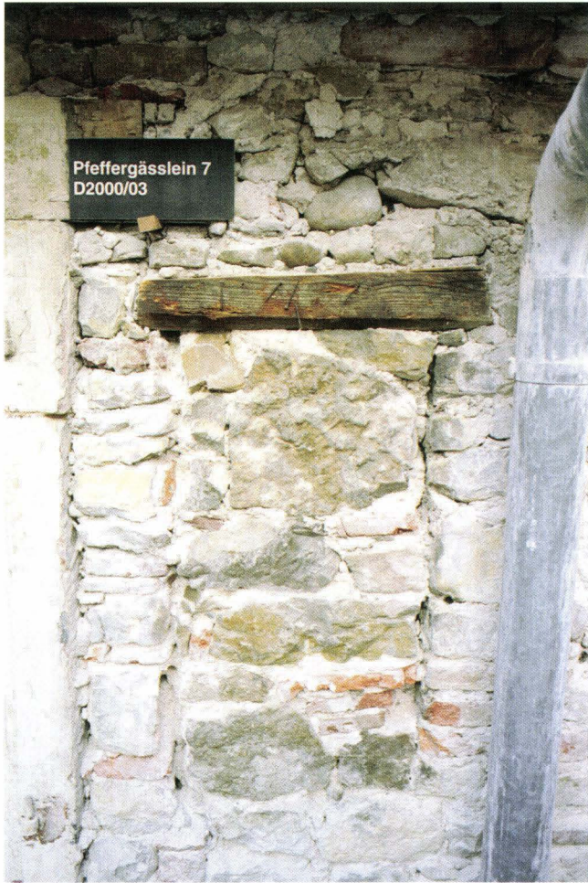
Abb. 51 Schneidergasse 28 / Pfeffergässlein 7 (D 2000/03). Pfeffergässlein 7, Hoffassade, 2. OG: Fenster rechts (Innenmasse 40 mal 80 cm), original in die Aufstockungsmauer (um 1480) eingebunden. Seine Zumauerung erfolgte bereits einige Zeit vor der barocken Neu-Befensterung dieses Geschosses. – Foto: Basler Denkmalpflege.
