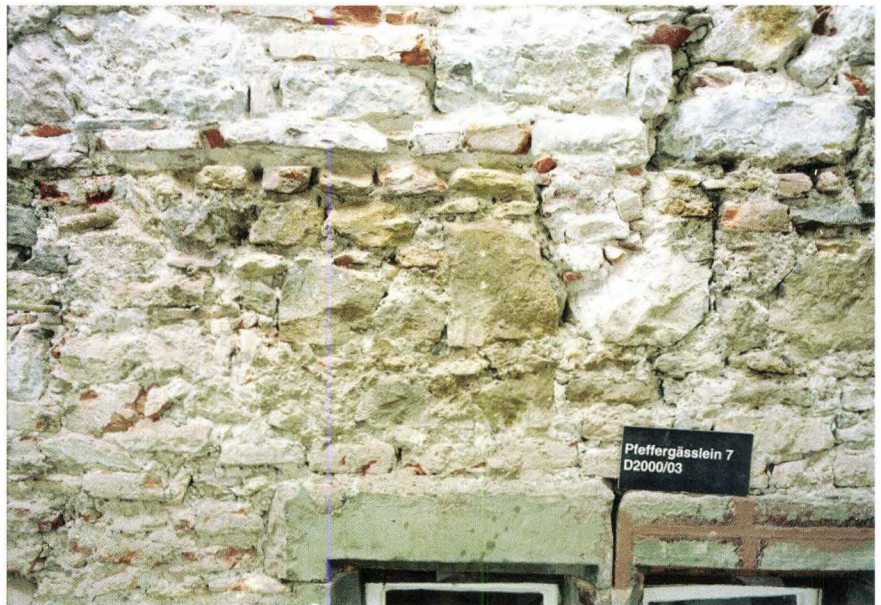
Abb. 45 Schneidergasse 28 / Pfeffergässlein 7 (D 2000/03). Pfeffergässlein 7, Gassenfassade. Oben die horizontale Bauhöhe des 1. OG (frühes 15. Jahrhundert) und darüber die Einbaustruktur einer Neu-Befensterung in dem um 1480 aufgestockten 2. OG. – Foto: Basler Denkmalpflege.
