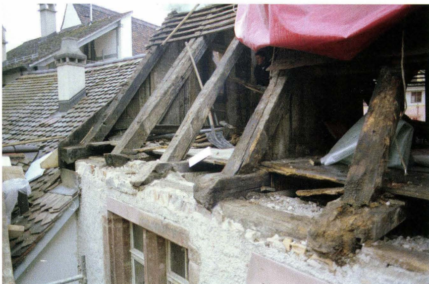
Abb. 61 Schneidergasse 28 / Pfeffergässlein 7 (D 2000/03). Pfeffergässlein 7, Dachfuss auf der Gassenseite nach Abbruch der Traufe. Die Dachbalken sind auf Mauerlaten aufgekämmt. Die Balkenköpfe ragten über die Fassadenflucht hinaus. – Foto: Basler Denkmalpflege.
