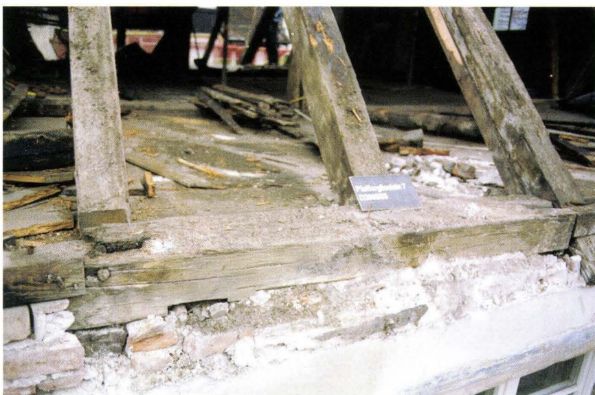
Abb. 63 Schneidergasse 28 / Pfeffergässlein 7 (D 2000/03). Pfeffergässlein 7, Dachfuss auf der Hofseite. Zwischen zwei Gespärren über den Dachbalken aufgelegte Schwelle als Unterbau einer ehemaligen Aufzugsgaube. Rechts der Sparren des mittleren Binders, links zwei nach Abbruch des Dachaufbaus eingefügte Hölzer. – Foto: Basler Denkmalpflege.
