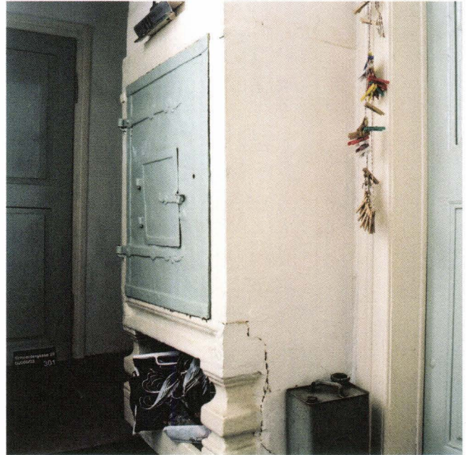
Abb. 12 Schneidergasse 28 / Pfeffergässlein 7 (D 2000/03). Schneidergasse 28, 3. OG. Einfeuerungskasten mit Balusterfüssen im Gang. – Foto: Ruedi Walti.
