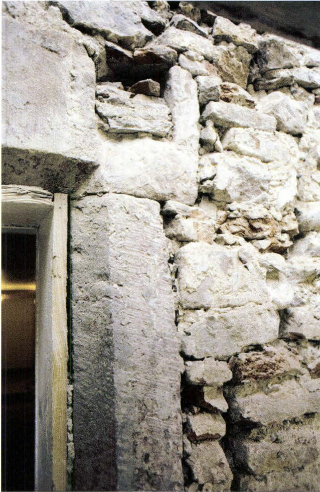
Abb. 54 Schneidergasse 28 / Pfeffergässlein 7 (D 2000/03). Pfeffergässlein 7, Hoffassade am linken Rand im Erdgeschoss. In die Mauer aus dem 14. Jahrhundert eingebrochene Laubentüre. Die Aussparung im Sturz diente dem Rähm der Laube als Auflager. – Foto: Basler Denkmalpflege.
