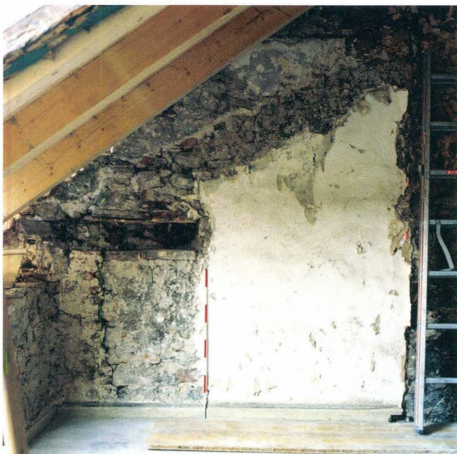
Abb. 31 Schneidergasse 28 / Pfeffergässlein 7 (D 2000/03). Schneidergasse 28, Blick an die Nordbrandmauer im hofseitigen Dachgeschoss. Der Eckverband mit der Kniestockmauer belegt den Zusammenhang zwischen urspr. Fassadenmauer und Brandmauer. Unmittelbar neben der Abwinklung ist ein durchgehender Riss in der Brandmauer zu erkennen, der sich auch nach unten fortsetzt. Die flachere Dachlinie in der Ansicht folgt der ursprünglichen Bedachung von 1363, welche durch das 1493 eingesetzte Dachwerk abgelöst wurde. Über der Kniestockmauer ist ein horizontaler Abdruck eines ehemaligen schräg eingemauerten Balkens erkennbar, der zur Fassade hinaus ragte und zu einem Anbau gehörte. – Foto: Basler Denkmalpflege.
