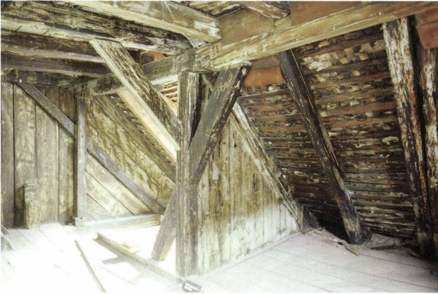
Abb. 56 Schneidergasse 28 / Pfeffergässlein 7 (D 2000/03). Pfeffergässlein 7, 1. Dachgeschoss. Zu sehen: der mittlere Ständer gassenseits mit Querstrebe zu Mittelpfette und Schwelle, und die in der Dachneigung verlaufenden Steigbänder, die sich mit den Kehlbalken (oben) überkreuzen. – Foto: Basler Denkmalpflege.
