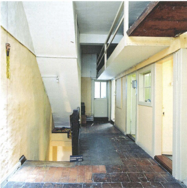
Abb. 9 Schneidergasse 28 / Pfeffergässlein 7 (D 2000/03). Schneidergasse 28, 4. OG/DG. Treppenhaus mit Tonplattenboden aus der Zeit der barocken Treppe (um 1700). Rechts moderne Einbauten zu Wohnzwecken. – Foto: Ruedi Walti.
