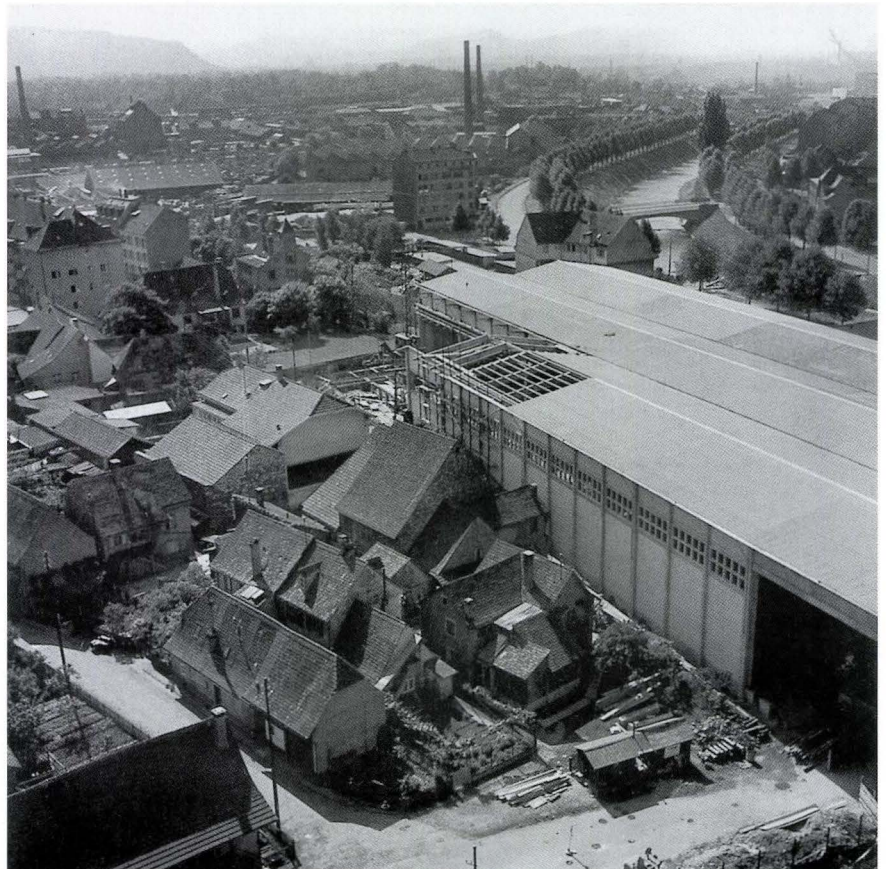
Abb. 3 Bauschneise um 1953. Blick vom Siloturm auf die Giebel an Schul- und Pfarrgasse während des Baus der neuen Lagerhalle der Reederei. – Photo: Gerd Pinsker.
