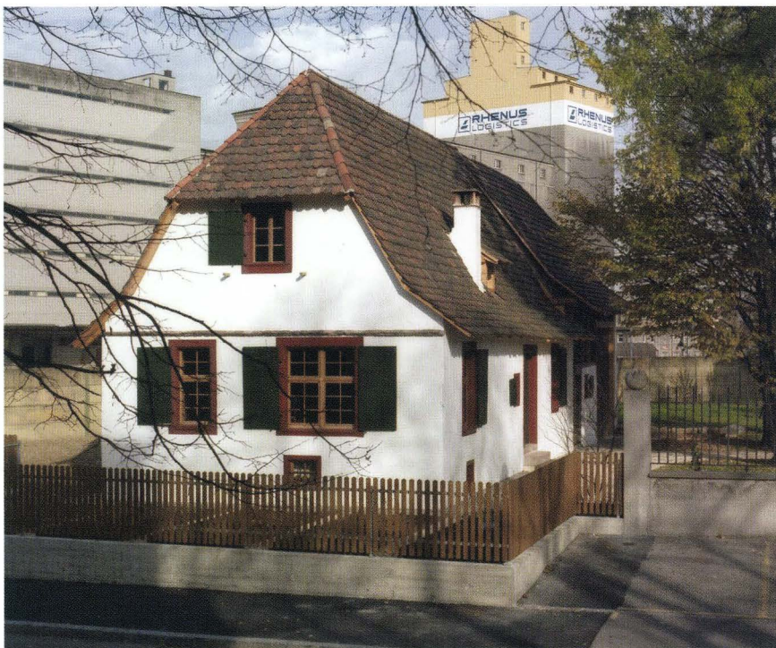
Abb. 22 Das wieder aufgebaute Fischerhaus an der Bonergasse 71 in Kleinhünigen, im Herbst 2002. – Photo: Basler Denkmalpflege. Aus: Uta Feldges 2003, S. 11.
