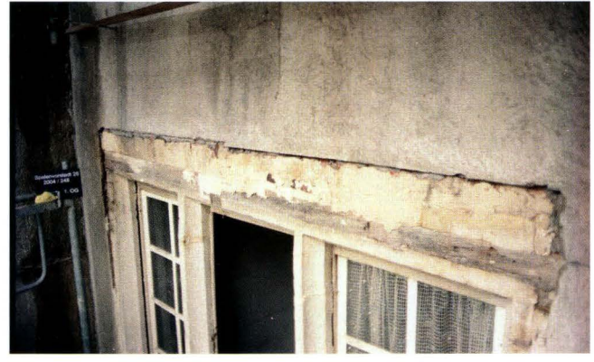
Abb. 22 Spalenvorstadt 25 (2004/248). Hoffassade, Gotisches Drillingsfenster des 1. Obergeschosses aus wiederverwendeten Werkstücken verschiedener Provenienz. Der Eichensturz, der das Kehlprofil der Pfosten übernimmt, wurde offensichtlich für den Einbau des Fensters gefertigt. – Foto: Basler Denkmalpflege, Matthias Merki.
