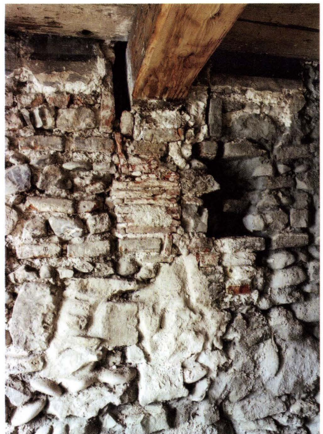
Abb. 12 Spalenberg 29 (2004/478). Westbrandmauer im 3. OG. Für den dritten Deckenbalken von Süden her ist eine Spitzgiebel-Nische als Auflager verwendet worden. Die Nische gehört zur Brandmauer (vergl. Abb. 4). Die linksseitige Nischenkante ist deutlich erkennbar. Die beiden den Giebel bildenden, schräg gegeneinander gestellten Backsteine reichen oberhalb der Deckenbretter bis in das Dachgeschoss hinauf. Das Mauerloch rechts der Bildmitte gehört zu einer jüngeren Ausflickung. Der Anwurf mit Zementmörtel ist unten als graue Schicht erkennbar. – Foto: Basler Denkmalpflege.
