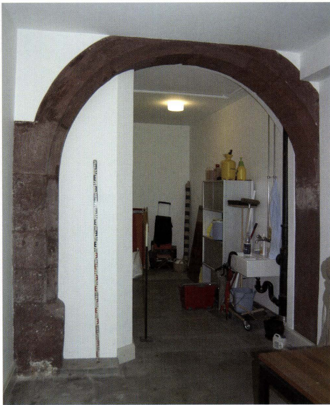
Abb. 7 Rheinsprung 20 (2005/13). Nordhaus EG, Blick zur Hinterfassade. An der Nordbrandmauer angelegtes Rundbogenportal aus Sandsteinteilen, das als Pendant zum ehem. Rundbogen in der Strassenfassade an die einstige Durchfahrt erinnert. – Foto: Basler Denkmalpflege.
