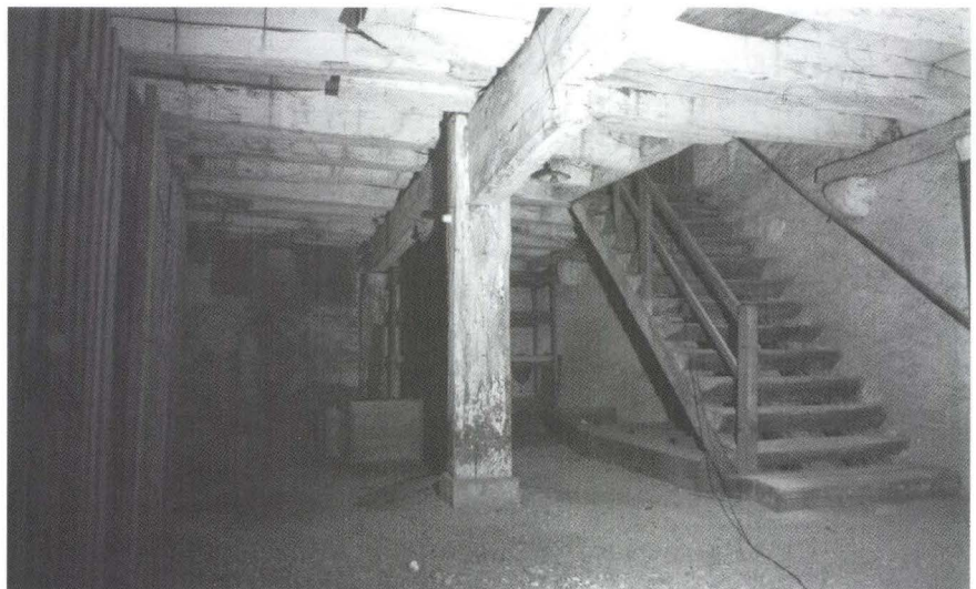
Abb. 11 Rheinsprung 20 (2005/13). Zweigeschossiger Keller unter dem Nordhaus. Die Blockstufentreppe entlang der Nordbrandmauer führt in den unteren Keller. Sie liegt in der Verlängerung des oberen Treppenlaufs auch an der Nordbrandmauer; ist von der Substanz und von der Lage her allerdings älter. In der Mitte verläuft ein Längsunterzug (Nadelholz) mit Mittelstütze und Sattelholz. Die Deckenbalken (alle Eiche) datieren dendrochronologisch ins Jahr 1358. – Foto: Basler Denkmalpflege.
