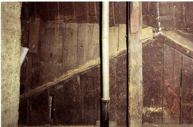
Abb. 13 Gerbergasse 63 (2005/725). Blick an die südliche Scheidewand im 1. Dachgeschoss. Verbrettertes Giebeldreieck eines Vorgängerdachs des Hauses Gerbergasse 65. – Foto: Basler Denkmalpflege.
