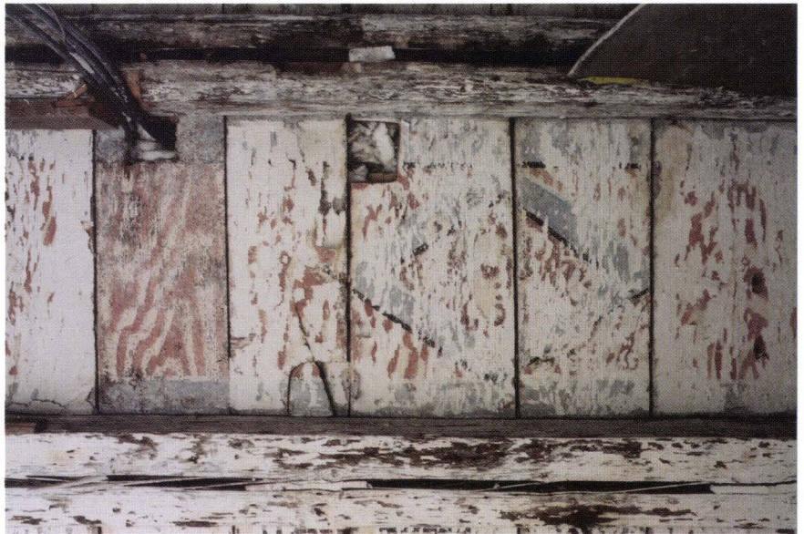
Abb. 24 Rittergasse 12 (2003/27). Bemalte Balkendecke in Haus Nr. 16 im Bereich ausserhalb des rückwärtigen Raums, dessen Deckenbemalung in den 1970er-Jahren restauriert wurde. Die grau gefassten Deckenfelder sind mit braunroten Maserierungen dekoriert. In den Raummittelachsen sind Rautenmotive eingebunden. Die grauen Rahmen werden von nach Licht und Schatten ausgerichteten schwarzen und weissen Streifen begleitet. – Foto: Basler Denkmalpflege.
