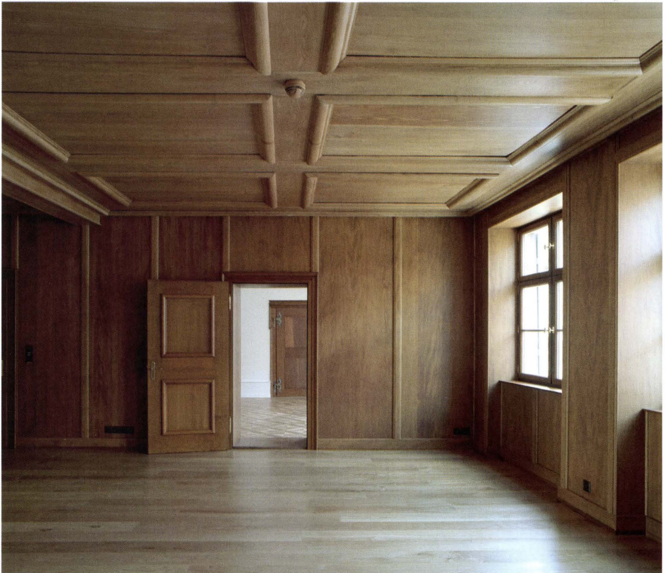
Abb. 15 St. Alban-Vorstadt 17 – Zum Geist (2003/252). Zweites Obergeschoss, schlicht vertäferter Saal von 1719 an der Strassenseite im westlichen Hausteil. Blick gegen Osten durch das Mittelzimmer an die Türe des strassenseitigen Ostraumes. Etliche Teile wurden nach den schadhafte Originalen neu hergestellt. – Foto: Basler Denkmalpflege, Bruno Thüning.
