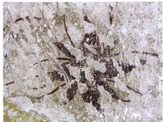
Abb. 25 Lindenberg 12 (2004/339). 2. OG, mittlerer Gebäudeabschnitt. Ein rotes Blütenmotiv begleitet an der rheinseitigen Binnenvand die rückseitige Treppenturmtür (wohl aus der Bauzeit von 1501). – Foto: Basler Denkmalpflege.
