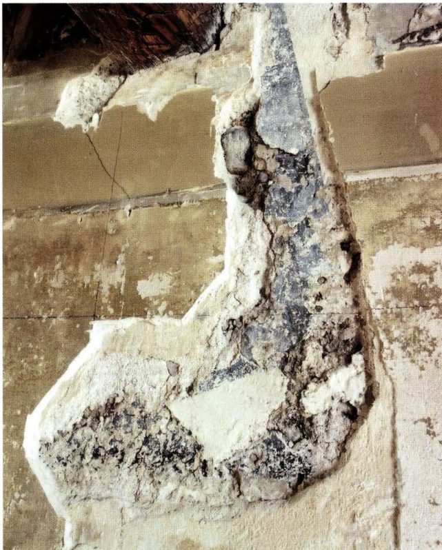
Abb. 14 Spalenberg 29 (2004/478). Ostbrandmauer im 3. OG, rückwärtiger Bereich. Reste des originalen Wandverputzes mit zerbröselnden Fragmenten des schwarz konturierten Graubands unter modernem Gipsputz. Das Grauband zieht nicht um den Balken herum, sondern ist schräg nach unten weitergeführt. Eine zweite, jüngere Fassung korrigiert dies, indem das Band von etwas weiter oben weg schräg nach unten weist. Der Grund für diese Umrandungsform ist nicht bekannt. – Foto: Basler Denkmalpflege.
