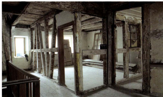
Abb. 20 Spalenvorstadt 25 (2004/248). 2. Obergeschoss, Blick gegen den Hof. Die vor dem Abbruch 2005 «entkleideten» Fachwerkwände und Decken der vierten Bauphase. Rechts die leicht diagonal verlaufende ältere Wand, die noch aus der dritten Bauphase stammt (s. Abb. 17) und durch die neue Raumteilung in der vierten Bauphase auf der Hofseite beschnitten worden ist. Das Retourgeländer der Treppe links gehört zur Ausstattung des 19. Jahrhunderts. – Foto: Basler Denkmalpflege, Matthias Merki.
