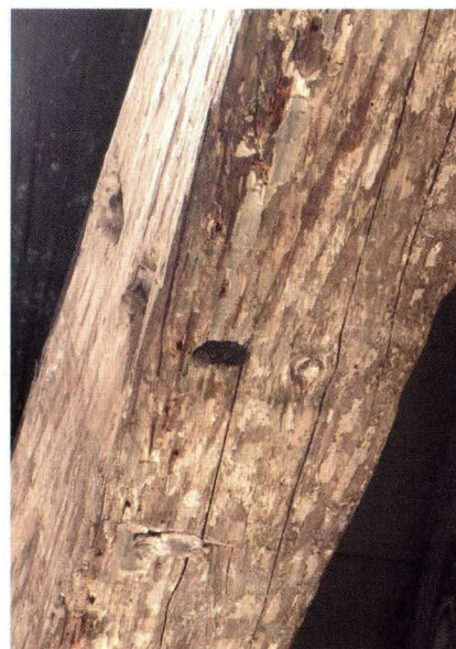
Abb. 12 Gerbergasse 63 (2005/725). Wiedlöcher zur Aufnahme der Wieden (aus Holzfasern gedrehte Stricke für das Zusammenbinden des Bauholz-Flosses) am mittleren Kehlbalken des Dachwerks. – Foto: Basler Denkmalpflege.
