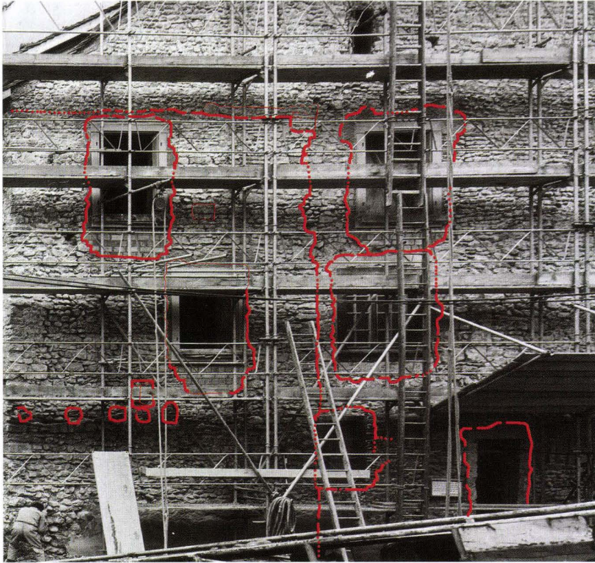
Abb. 4 Rittergasse 12 (2003/27). Entzerrte Fassadenaufnahme von 1971 mit eingeblendeten Bauphasengrenzen. Eine vertikale Eckmauerung in der Bildmitte zwischen den Fenstern ist als 10 m von der Strasse zurückgesetzte Hausecke eines mehrgeschossigen Steinbaus erkennbar. Zu sehen ist links davon die südliche, 6,2 m breite Seitenfassade eines mittelalterlichen, mind. 8 m hohen Gebäudes. Die Eckverbände vorne und hinten zeigen grossformatige Quadersteine, die übrige Mauerfläche besteht aus kleinteiligem Material mit teilweise in Reihen verlegten Wackensteinen. Oberhalb des 2. OG endet die alte Seitenfassade mit einer Abbruchlinie ohne Spuren einer Dachform. Weitere Bauphasen sind innerhalb der beschriebenen mittelalterlichen Seitenmauer nicht erkennbar. Vom Mauerbild her lässt sie sich ins 13. Jahrhundert datieren. Die bestehenden Fenster wurden alle viel später eingebrochen. Eine Reihe von Balkenlöchern über dem EG in der linken Hälfte kann nicht zugeordnet werden. – Foto: Archäologische Bodenforschung Basel-Stadt. Bearbeitung: Stephan Tramèr.
