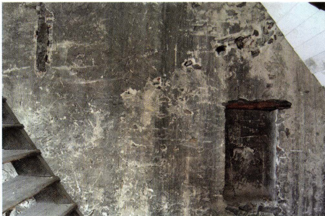
Abb. 14 Spalenvorstadt 25 (2004/248). Ostbrandmauer, 2. Dachgeschoss. Vom sich abzeichnenden 2. Dach liegen noch einige abgeschnittene Dachlattenstücke im Mauerwerk. Unterhalb der Dachschräge befindet sich eine Fensteröffnung, welche mit der Erhöhung der Nachbarliegenschaft Nr. 23 zu einer Nische zugemauert wurde. – Foto: Basler Denkmalpflege, Matthias Aebersold.
