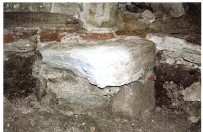
Abb. 20 Lindenberg 12 (2004/339). EG, Treppenturm. Die Spindeltreppe steht auf einer Ausflickung des Tonfliesenbodens über einem als Fundament dienenden Bruchstein (Mitte). Dieser wurde in eine den Tonfliesenboden durchschlagende Grube gelegt. – Foto: Basler Denkmalpflege.
