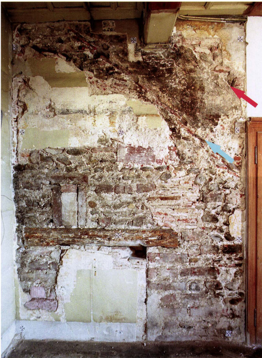
Abb. 8 Lindenberg 12 (2004/339). 2. OG, rheinseitiger Gebäudeabschnitt. Blick an die im zweiten Obergeschoss freigelegte Giebelmauer des Hauses A. Unten die Türöffnung zum damaligen Dachgeschoss, darüber die kleine Fensteröffnung. Die Dachlinie (roter Pfeil) verläuft über der gut sichtbaren Dachlinie eines hier einst anschliessenden Gebäudes (blauer Pfeil). – Foto: Basler Denkmalpflege.
