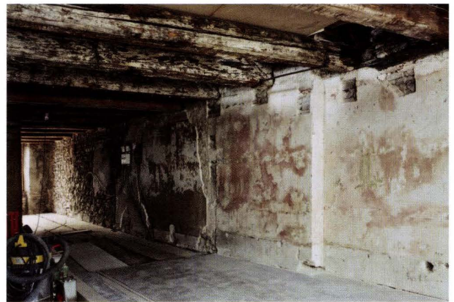
Abb. 7 Spalenberg 29 (2004/478). Die Westbrandmauer im 3. Obergeschoss von der Seite Spalenberg her. Bestehender Verputz wurde belassen. Nur punktuell sind einige Sondierfenster geöffnet. Der schmale Mauerrücksprung im Vordergrund zieht sich durch alle Geschosse hindurch. – Foto: Basler Denkmalpflege.
