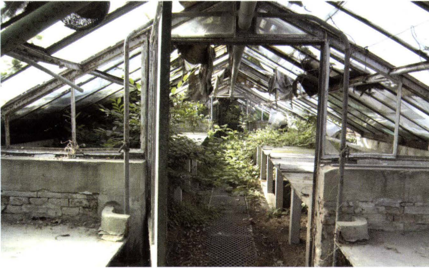
Abb. 2 Äussere Baselstrasse 387, Riehen – Bäumlihof (2005/87). Blick in den langen Gewächshausflügel Richtung hinteres Arealende. Zustand 2005. – Foto: Basler Denkmalpflege.
