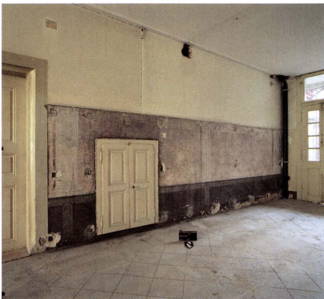
Abb. 17 St. Johannis-Vorstadt 15/17, Sant Christoffel / Erlacherhof (2003/280). Die Durchfahrt in Haus Nr. 17. Zu sehen ist die freigelegte klassizistische Architekturalmalerei des frühen 19. Jahrhunderts, deren oberer Teil später irreversibel übermalt wurde. – Foto: Basler Denkmalpflege.
