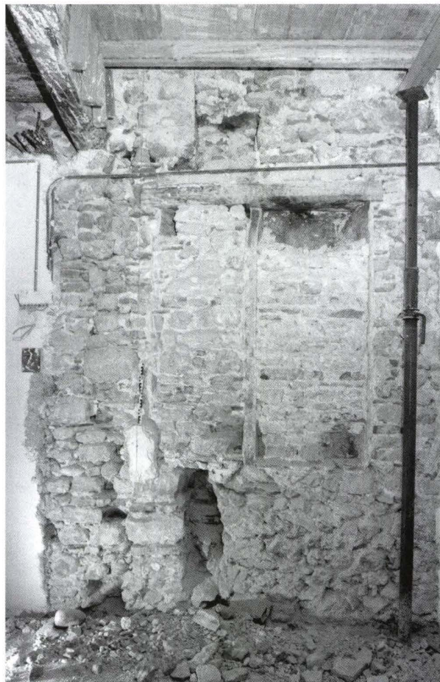
Abb. 18 Rheinsprung 20 (2005/13). Fenster in der Südbrandmauer im 1. OG. Das Fenster wurde von der Nachbarseite vom Hinterhaus her eingebaut, unter Berücksichtigung der wegen beidseits schon bestehender Bauten begrenzten Möglichkeiten (s. Abb. 17). Das zweiteilige Fenster ist links etwas schmaler als rechts. Der Sturz ist aus Eichenholz, die Seitengewände aus Sandstein. Das Fenster diente der Belichtung einer hinteren Kammer im Nachbarhaus. Es eröffnete den Blick in den Vorgarten der «Augenweide» in der Zeit vor dem Totalausbau um 1435. – Foto: Basler Denkmalpflege.
