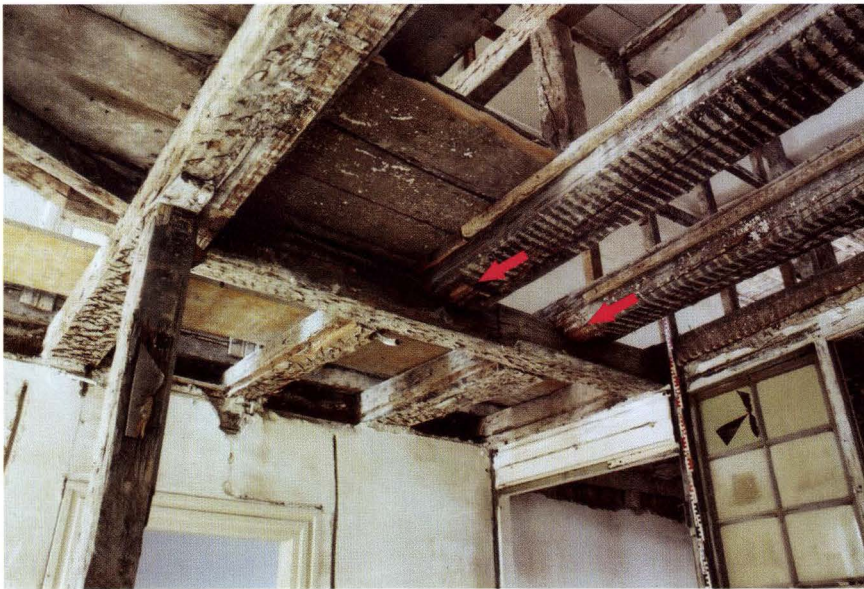
Abb. 12 Rebgasse 13 (2005/23). Die markierten Balken schliessen die ehemalige Treppenöffnung in der Decke des 1. Obergeschosses. Die Verzapfungsstelle des Wechselbalkens führte zu einer Schwachstelle am durchgehenden Balken. An dieser Stelle steht (links im Vordergrund) ein wieder verwendeter Ständerbalken mit Zierfasen und Zapflöchern für schräg abgehende Hölzer. Der Balken stammt wohl aus der Laubenanlage, die zugunsten des neuen Treppenhauses 1872 abgebrochen wurde. – Foto: Basler Denkmalpflege.
