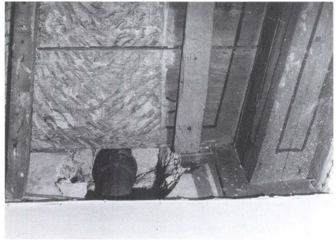
Abb. 22 Rheinsprung 20 (2005/13). Raum gegen die Strasse im 2. OG des Südhauses. In der Mittelmauer (Trennmauer zwischen Nord- und Südhaus) sind die Deckenbalken dieses Geschosses eingelassen. Sie weisen mehrere Malereifassungen auf. Gut erkennbar bei der Freilegung war eine Grauband-Umrahmung mit schwarzen Begleitstrichen und perspektivisch gefassten Balkenfeldern. Diese sind in Gehrung gezeichnet, mit schwarzen und hellen, plastisch wirkenden Flächen. Die Balken- und Deckenfelder blieben holzsichtig. Nach dem Einbau eines Kaminzugs blieb diese Fassung verdeckt. Die weiterhin sichtbar gebliebene Balkendecke wurde mit einer Grisailledekoration mit barocken Rankenmotiven bemalt. Nach einer Balken- und Brettervergipsung (mit Aufteilung der Holzflächen) verschwand im 18. Jahrhundert die Balkendecke hinter einer untergehängten Gipsdecke. – Foto: Basler Denkmalpflege.
