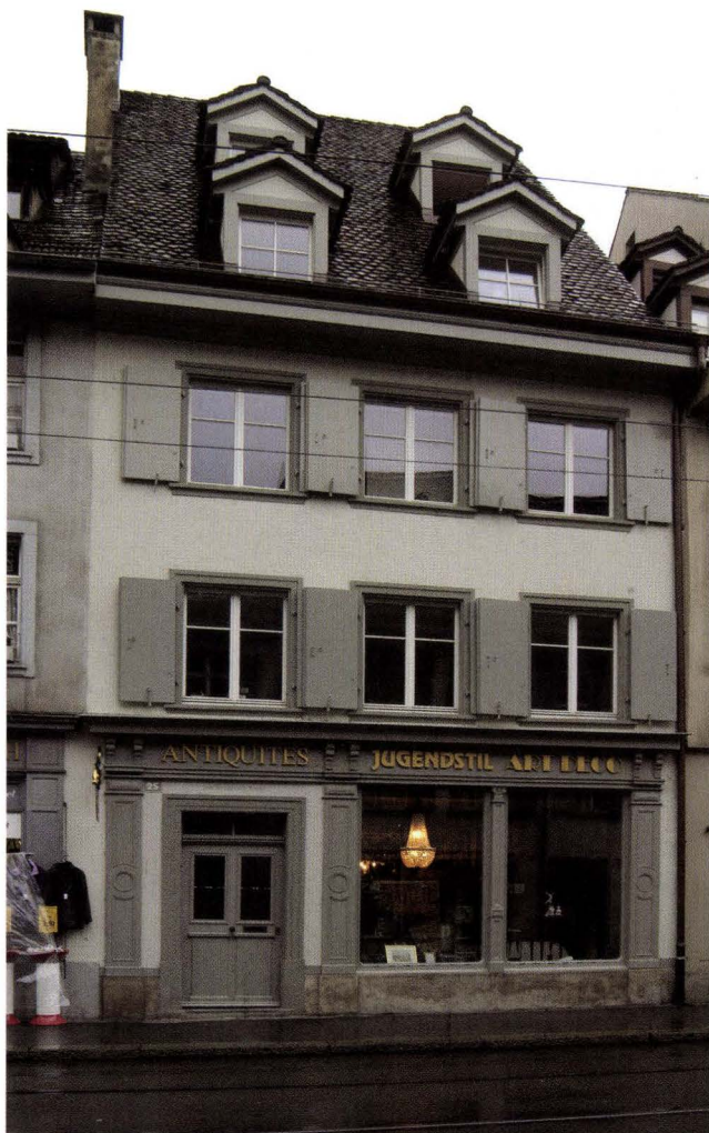
Abb. 1 Spalenvorstadt 25 (2004/248). Das renovierte Haus. Aufnahme im Oktober 2006. – Foto: Basler Denkmalpflege, Matthias Merki.
