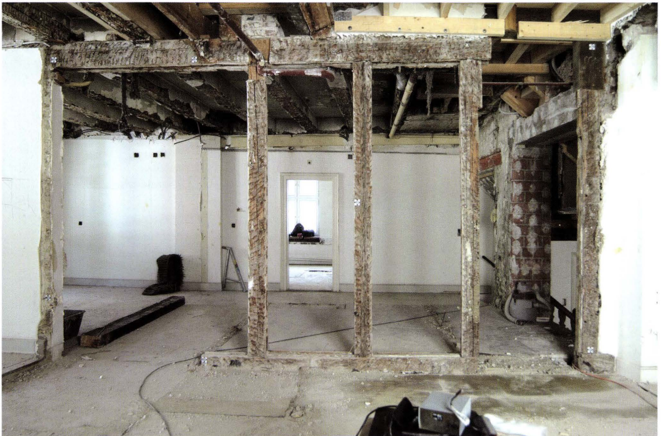
Abb. 30 Rittergasse 12 (2003/27). Haus Nr. 12, 2. OG, Blick Richtung Rittergasse. In der südlichen Raumhälfte haben sich vom ursprünglichen Wandgefüge aus der Zeit um 1530 nur unvollständige Teile erhalten. Beim Umbau wurden die Ausfachungen zwischen den Ständern entfernt. Die parallel dazu verlaufende Trennwand gegen die strassenseitigen Räume ist gleich konstruiert. – Foto: Basler Denkmalpflege.
