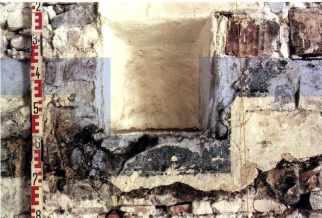
Abb. 7 Rebgassee 13 (2005/23). Das zur Wandnische umfunktionierte Balkenloch in der nordseitigen Brandmauer mit Resten einer um den Balken geführten Graubandfassung, deren Verlauf zur Verdeutlichung graphisch hervorgehoben ist. – Foto: Basler Denkmalpflege. Bearbeitung: Stephan Tramèr.
