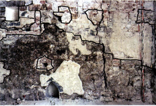
Abb. 6 Rebgassee 13 (2005/23). Sondierfläche der nördlichen Brandmauer im 1. Obergeschoss, Detailansicht. Markiert sind Bauphasengrenzen und Ausflickungen. Am unteren Bildrand: spitzbogige Wandnische mit Verputzresten, die eine Bemalung mit Grauband zeigen. – Foto: Basler Denkmalpflege.
