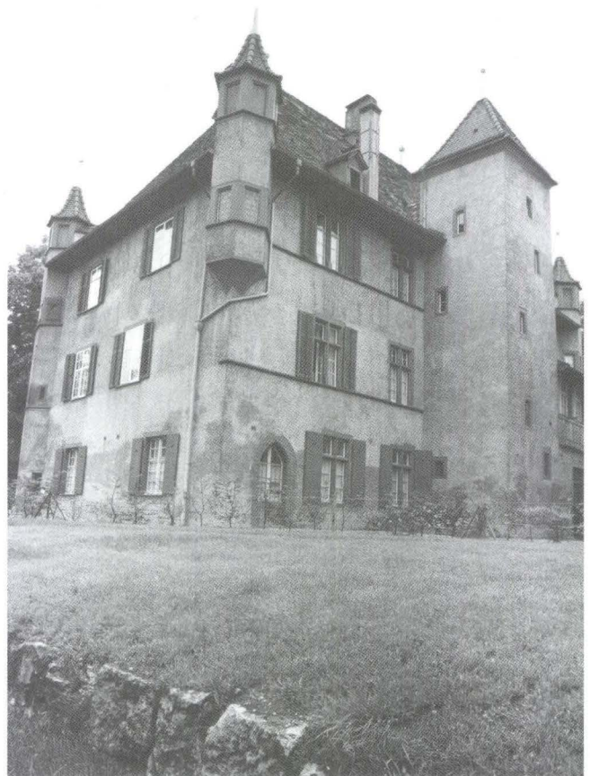
Abb. 4 Lindenberg 12 (2004/339). Hintere Längsseite (rechts) und rheinseitige Schmalseite (links) des Baukörpers. Die Gebäudeecken schliessen mit Türmchen ab, welche an der hinteren Seite als Erker ausgebildet sind. In der Mitte der hinteren Längsseite schliesst der Treppenturm an. – Foto: Christoph Teuwen, 1974.
