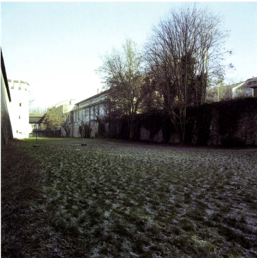
Abb. 1 Mühlegraben (2005/20). Blick in den seit 1979 wieder hergestellten Letziggraben, der Teil der Äusseren Stadtbefestigung ist. Im Hintergrund das rheinseitige Ende der Kontermauer, auf dem die Fabrikbauten des 19. Jahrhunderts stehen. Im Vordergrund die 1979 teilweise ergänzte Kontermauer, die sich Richtung St. Albanteich erstreckt. Am linken Rand ein Schalenturm der Äusseren Stadtmauer. – Foto: Basler Denkmalpflege.
