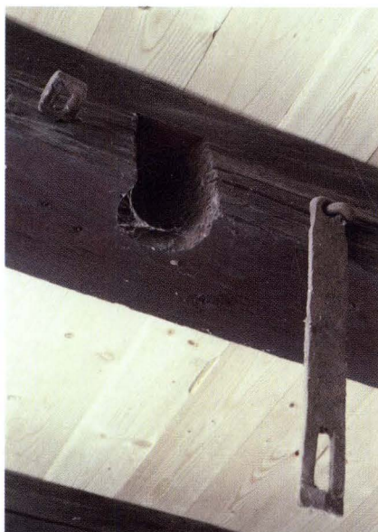
Abb. 11 Gerbergasse 63 (2005/725). Drehlagerbuchse einer ehemaligen Aufzugswelle am mittleren Kehlbalken des Dachwerks. Die Eisenschelle diente der Sicherung der vertikal angeordneten Welle. – Foto: Basler Denkmalpflege.
