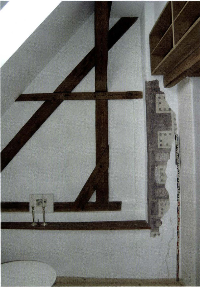
Abb. 14 Rheinsprung 20 (2005/13). Ansicht der mittleren Trennmauer im renovierten Dachstock. Der strassenseitige Dachständer ist Teil des dreigeschossigen Dachwerks von 1435, das an dieser Stelle auf einer älteren Giebelmauer steht. Diese Mauer bildet innerhalb der Fassadenfluchten beidseits eine vertikale Kante. An dieser Stelle wurde sie im Innern dekorativ mit einer Eckquadratur bemalt. Die regelmässig in Läufer und Binder wechselnden Quader sind durch den Schattenrahmen perspektivisch überhöht. Der begleitende Bollenfries zeigt an einer Stelle ein Pfauenaug. Am unteren Ende unterbricht der Bollenfries die Eckquadratur, indem er sie horizontal unterfährt. Die Malerei ist frühestens nach Errichtung des Dachwerks, vermutlich einige Jahrzehnte später entstanden. – Foto: Basler Denkmalpflege.
