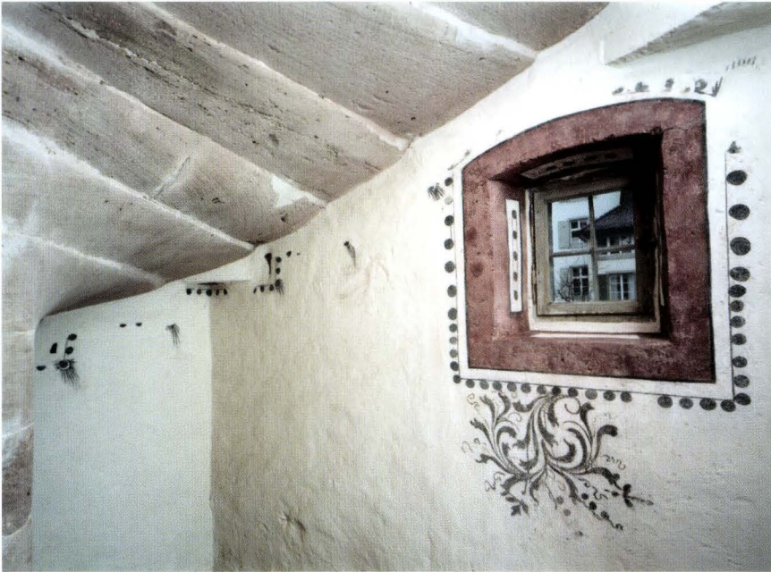
Abb. 21 Lindenberg 12 (2004/339). EG, Treppenturm, rheinseitige Turmmauer. In der Zumauerung der früheren Türöffnung ist ein kleines Fenster angelegt. Die Leibung ist mit einem Rotband, Bollenbändern, Pfauenaugen und einer asymmetrischen Arabeske gefasst. Das Rotband umrahmt in der Leibung Innenfelder, in die wiederum Bollen gesetzt sind. Zustand nach der Restaurierung. – Archiv Basler Denkmalpflege. Foto: Erik Schmidt.
