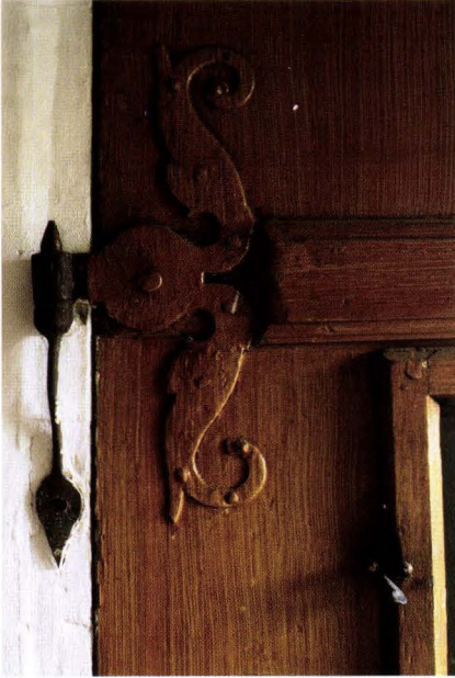
Abb. 26 Spalenvorstadt 25 (2004/248). 2. Obergeschoss. Detail der Zugangstüre zur Treppe ins 1. Dachgeschoss. Kaltdächer erfordern entweder Falltüren im Dachboden oder geschlossene Treppen, damit sich im Winter die Kälte (oder im Sommer die Hitze) nicht in die bewohnten Geschosse ausbreiten kann. – Türe aus dem 17. Jahrhundert. Bereich des oberen Scharniers und der oberen Einschubleiste. Der in den Türpfosten geschlagene Kloben wird durch eine schlanke, stielförmige Strebe unterstützt. Deren mit einem Nagel fixiertes unteres Ende ist blattartig ausgeformt. Die schlangenförmigen Delphinbänder sind ziseliert. Das Fenster und die Maserierung sind Zutaten des 19. Jahrhunderts. – Foto: Basler Denkmalpflege.
