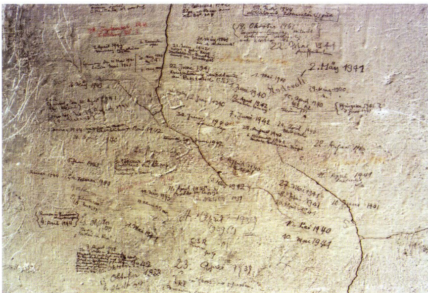
Abb. 19 Spalenberg 29 (2004/478). Ein Kuriosum sind die auf den Zementputz der Ostbrandmauer im Dachgeschoss geschriebenen Bleistiftnotizen. Es sind Kriegsdaten aus den Jahren 1938 bis 1942 vermerkt. Der Urheber ist nicht bekannt. – Foto: Basler Denkmalpflege.
