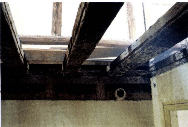
Abb. 15 Rebgasse 13 (2005/23). Decke des 1. Obergeschosses nach Entfernen der Deckenbretter. Die Balkenlage von 1721 mit Blindborden aus Lehmwickeln liegt höher als eine ältere Geschosseinteilung. Deutlich erkennbar sind die keilförmig in die Balkenseiten gehauenen Nuten, in welche Latten eingeschoben wurden. Die gleiche Art der Füllung ist im freigelegten Wandstreifen zu sehen: Latten und Stäbe sind in senkrechter Anordnung zwischen den Riegeln eingeschoben und von Lehmwickeln ummantelt. – Foto: Basler Denkmalpflege.
