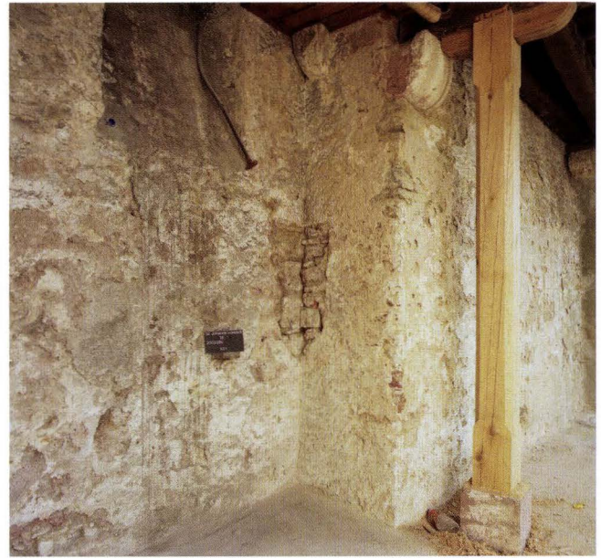
Abb. 9 St. Johannis-Vorstadt 15/17, Sant Christoffel / Erlacherhof (2003/280). Keller im Haus Nr. 15. In der linken Bildhälfte sieht man die originale Ostwand, die mit der Nordwand einen Eckverband bildet. Rechts schliesst überlagernd die sekundäre Mauer der Kellererweiterung an, was mit der Sondierung in der Bildmitte klar nachgewiesen werden konnte. Zu dieser Mauer gehören auch die Steinkonsolen. Zur Entlastung der Mauer unter der mächtigen Konsole für den Unterzug wurde in moderner Zeit eine Stahlstütze eingebaut, welche 2004 durch die Eichensäule im Bild (zusammen mit dem Einbau eines Pendants vor der Westwand und des Imitats der gotischen Mittelsäule) ersetzt wurde. – Foto: Basler Denkmalpflege.
