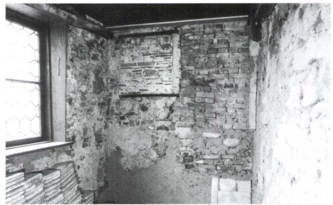
Abb. 6 Rheinsprung 8 und 10, Stützmauer der Martinskirche (2003/346 und 2003/443). 1. Obergeschoss von Rheinsprung 10. Die Täuferstube nach dem Ausbau der Vertäferung. Hangseitig (rechts) die mittelalterliche, aus Kalksteinen in grobkiesigem Mörtel erstellte Stützmauer. – Foto: Basler Denkmalpflege (1995).
