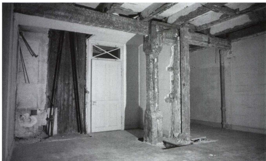
Abb. 19 Rheinsprung 20 (2005/13). Holzstütze im EG der südlichen, nach 1435 entstandenen Haushälfte. Der Unterzug unterstützt die Deckenbalken, die von der Strassenfassade bis zur Massivmauer vor der rückwärtigen Raumanlage (ehem. Hinterhaus) verlaufen. Vor der hinteren Massivquermauer verläuft eine Trennwand (im Bildhintergrund), die den Abgang zum hinteren Südkeller abteilt. – Foto: Basler Denkmalpflege.
