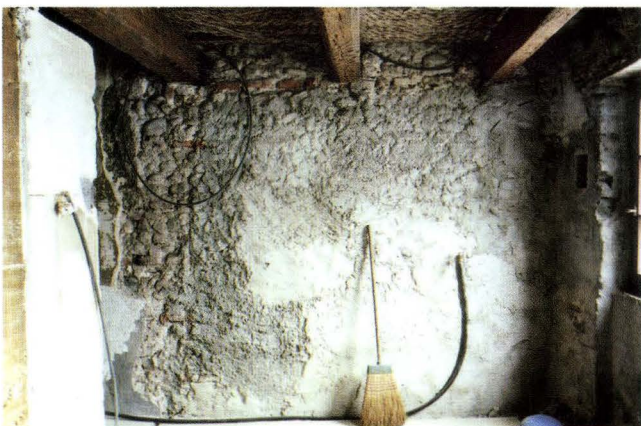
Abb. 9 Spalenberg 29 (2004/478). Die Ostbrandmauer bei der Ecke zur Rückfassade. Das Mauerwerk ist durch eine dicke Zementschicht unkenntlich. Ein senkrechter Sondierstreifen (links) und freigelegte Balkenfelder zeigen, dass sie der Westbrandmauer sehr ähnlich ist. Im kleinteiligen Mauerwerk sind auch hier in regelmäßigen Abständen Reihen von liegenden Backsteinen vermauert. – Foto: Basler Denkmalpflege.
