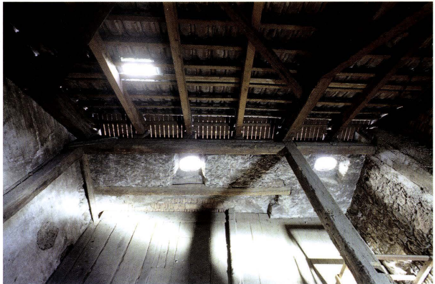
Abb. 11 Rössligasse 12 (2005/821). Blick in das Dachwerk und auf den strassenseitigen Dachfuss. Die Konstruktion mit nur zwei (ursprünglich drei) durchgehenden Dachbalken ermöglicht den gegen unten offenen Dachraum. Die restlichen Sparren sind in kleine Stichbalken eingezapft, welche die Zugkräfte über Wechsel auf die Dachbalken übertragen. – Foto: Basler Denkmalpflege.
