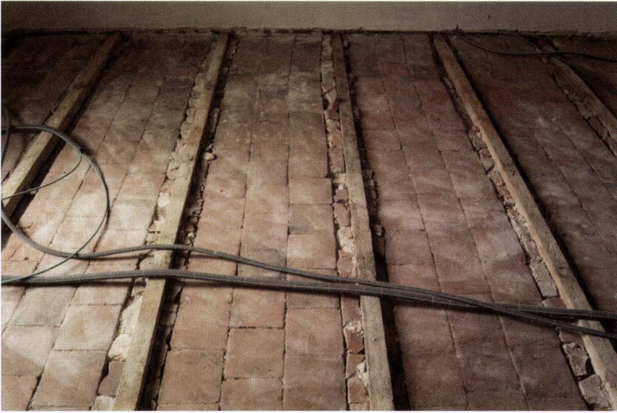
Abb. 26 Lindenberg 12 (2004/339). 1. OG, lindenbergseitiger Gebäudeabschnitt. Der im vorderen Raum unter dem Holzbe- lag grossflächig erhaltene Tonfliesenboden dürfte aus der Bauzeit von 1501 stammen. – Foto: Basler Denkmalpflege.
