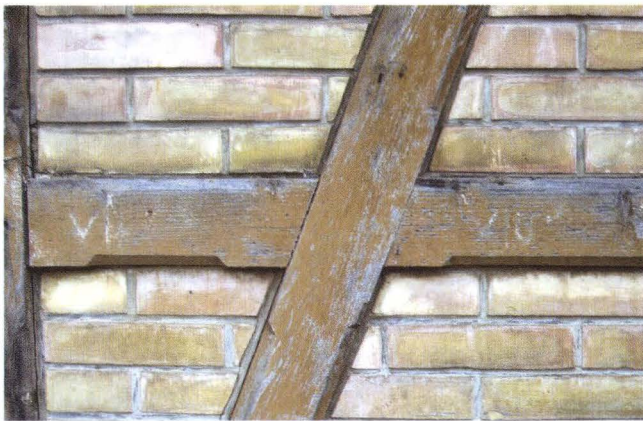
Abb. 8 Äussere Baselstrasse 387, Riehen – Bäumlhof (2005/87). Sämtliche Fachwerkhölzer sind exakt mit Zierfasen bearbeitet. Bei den gelben Backsteinen – sie weisen eine leichte Oberflächenrillung auf und sind mit ca. bleistiftdicken Löchern durchzogen – handelt es sich um industriell gefertigte Importware aus der 2. Hälfte des 19. Jahrhunderts. – Foto: Basler Denkmalpflege.
