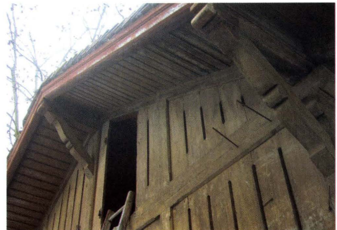
Abb. 9 Äussere Baselstrasse 387, Riehen – Bäumlhof (2005/87). Der Nordgiebel des Ökonomiebaus. Die verbretterte Fassade der Remise ist mit gleichmässig ausgesägten Vertikalschlitzern verziert. An den konstruktiven Hölzern zeigen sich die typischen Ausformungen mit flachen Karniesunterseiten und Wulstprofilen. Die Rahmen und Ständerhölzer der Fassadenkonstruktion sind jeweils mit feinen Zierfasen gebrochen. – Foto: Basler Denkmalpflege.
