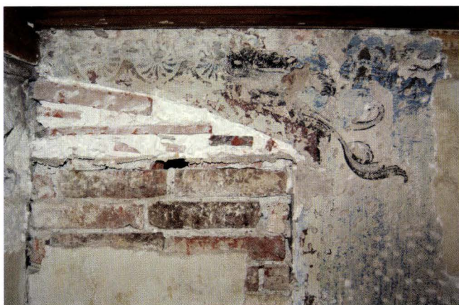
Abb. 30 Lindenberg 12 (2004/339). 1. OG, rheinseitiger Gebäudeabschnitt. Die bereits geteilte Nische in der rheinseitigen Aussenmauer wurde mit einer Rotbandfassung und einer den halben Stichbogen zierenden Blattwerkmalerei geschmückt (um 1560). – Foto: Basler Denkmalpflege.
