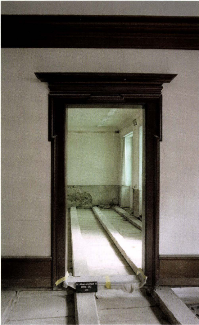
Abb. 16 St. Alban-Vorstadt 17 – Zum Geist (2003/252). Erstes Obergeschoss, Türe vom mittleren strassenseitigen Zimmer zum Südost-Raum (s. Abb. 14). Frühbarocker geogrter Türrahmen aus Eiche mit ausladendem Kranzgesims. – Foto: Basler Denkmalpflege, Matthias Merki.
