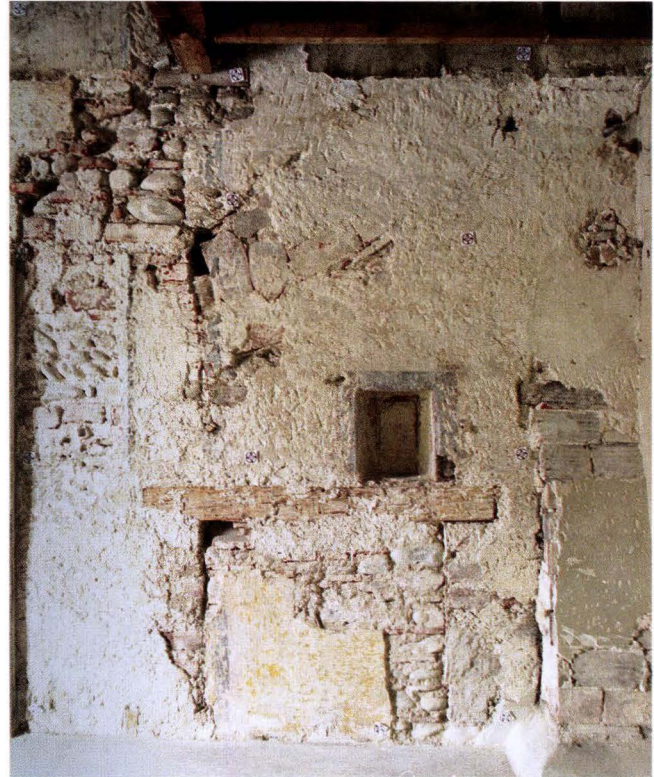
Abb. 11 Lindenberg 12 (2004/339). 2. OG, mittlerer Gebäudeabschnitt. Blick an die rheinseitige Giebelmuer des Hauses A (Innenseite). Unmittelbar über dem Sturzbalken der oberen Öffnung liegt ein kleines Fenster. Zum Innern des Hauses A hin ist die Fensterleibung verputzt. Die Gestaltung des später vermauerten Fensters als Nische und die Fassung mit einem Grauband stammen aus dem 16. Jahrhundert. – Foto: Basler Denkmalpflege.
