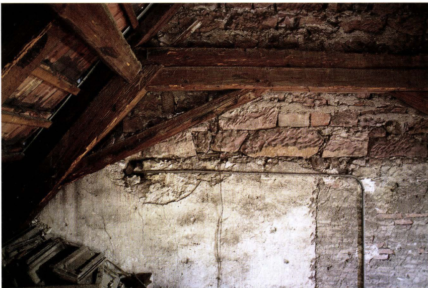
Abb. 10 Rössligasse 12 (2005/821). Blick auf das westliche Bindergespärre des Scheundachs an der Giebelwand des Wohnhauses. Der liegende Dachstuhl hat durchwegs gezapfte, mit Holznägeln gesicherte Verbindungen. – Foto: Basler Denkmalpflege.
