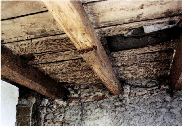
Abb. 13 Spalenberg 29 (2004/478). Deckenbalken des 3. OG mit der Ostbrandmauer nächst der Rückfassade. Die Balken sind abgebürstet. Spärliche Farbspuren der einstigen Bemalung sind nur noch in den Vertiefungen den Balken entlang vorhanden. – Foto: Basler Denkmalpflege.
