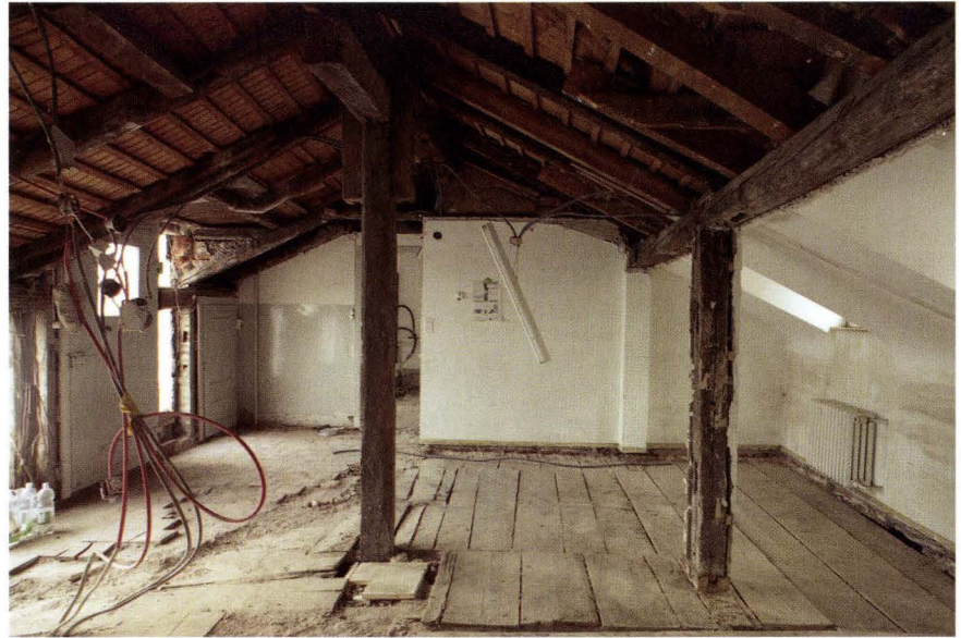
Abb. 12 Nadelberg 7 (2005/889). Teilweise freigelegte Konstruktion des Pfettendachs. Blick gegen Süden. – Foto: Basler Denkmalpflege.
