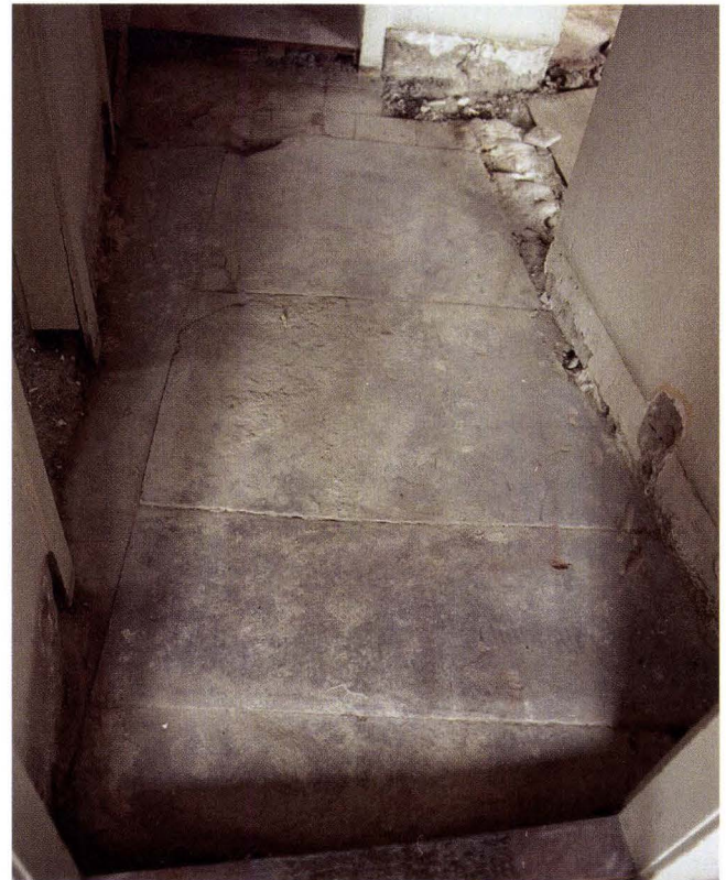
Abb. 11 Nadelberg 7 (2005/889). Freigelegter Sandsteinplattenboden im 1. OG. – Foto: Basler Denkmalpflege.
