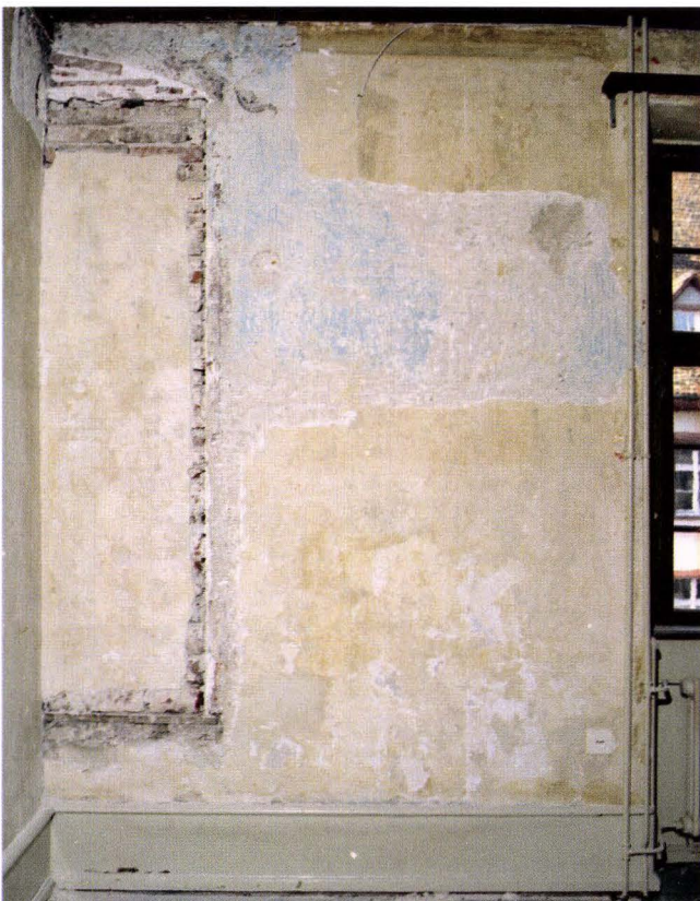
Abb. 19 Lindenberg 12 (2004/339). 1. OG, rheinseitiger Gebäudeabschnitt. Die frühere Mauernische in der rheinseitigen Aussenmauer gehört zum noch ungeteilten Raum. Die jüngere Binnenwand (links) stösst in die Nische und teilte somit die damals noch nicht bündig vermauerte Nische. – Foto: Basler Denkmalpflege.
