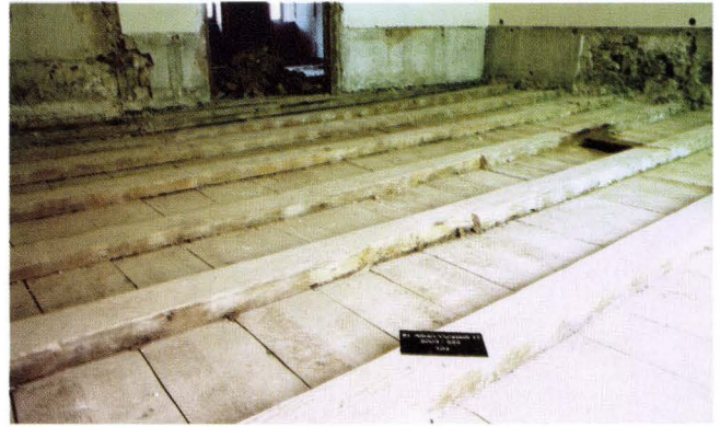
Abb. 14 St. Alban-Vorstadt 17 – Zum Geist (2003/252). Erstes Obergeschoss. Schiebeboden im strassenseitigen Raum an der Ostbrandmauer. – Foto: Basler Denkmalpflege, Andreas Stulz.
