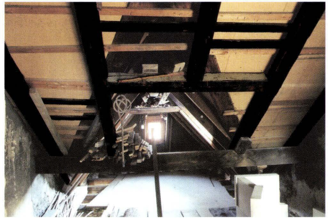
Abb. 17 Spalenberg 29 (2004/478). Der Rest der ältesten Dachkonstruktion an der Nordseite, Blick gegen Spalenberg (siehe Abb. 16). Hinter den Sparrenresten die Konstruktion des Quergiebelaufbaus von 1843 mit dem Walmdach samt kleiner Lukarne. – Foto: Basler Denkmalpflege.
