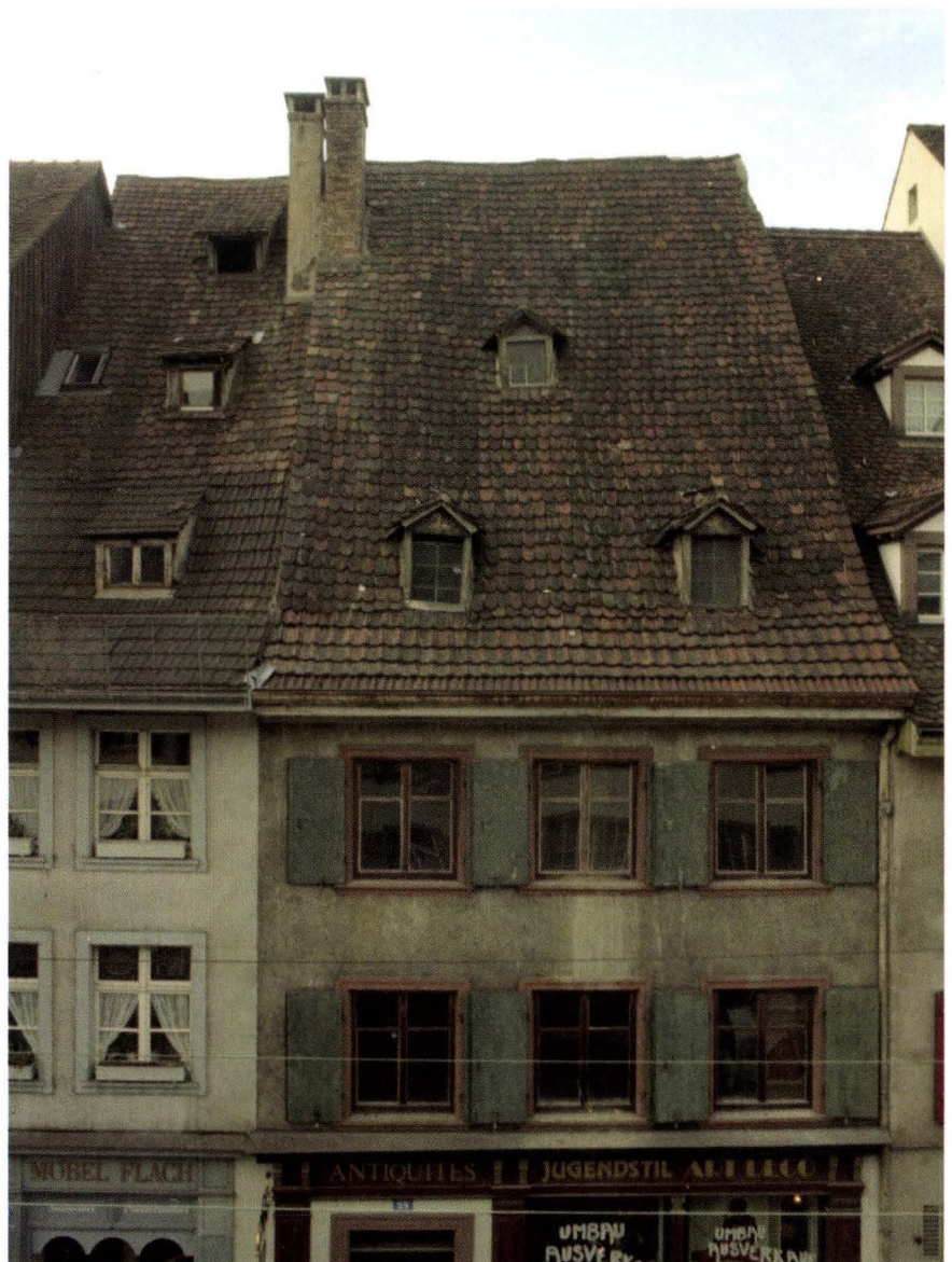
Abb. 18 Spalenvorstadt 25 (2004/248). Zustand vor dem Umbau, Februar 2005. Einfachdeckung, ausser im Traufbereich mit Biberschwanzziegeln. Mit dem Dachausbau und damit der Aufgabe des Kaldaches 2005 entschied man sich für eine Doppeldeckung. Das schmale Nach- barhaus links, Nr. 23, hat noch eine Einfachdeckung. – Foto: Basler Denkmal- pflege, Matthias Merki.
