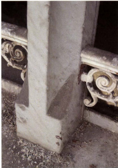
Abb. 5 Gerbergasse 63 (2005/725). Gekehlter Mittelpfosten im 3. OG an der Gerbergasse. Die ursprüngliche Aussenfucht des Gebäudes ist nur noch an diesem Pfosten ablesbar; die restliche Aussenmauer wurde in den oberen Stockwerken vorgemauert. – Foto: Basler Denkmalpflege.
