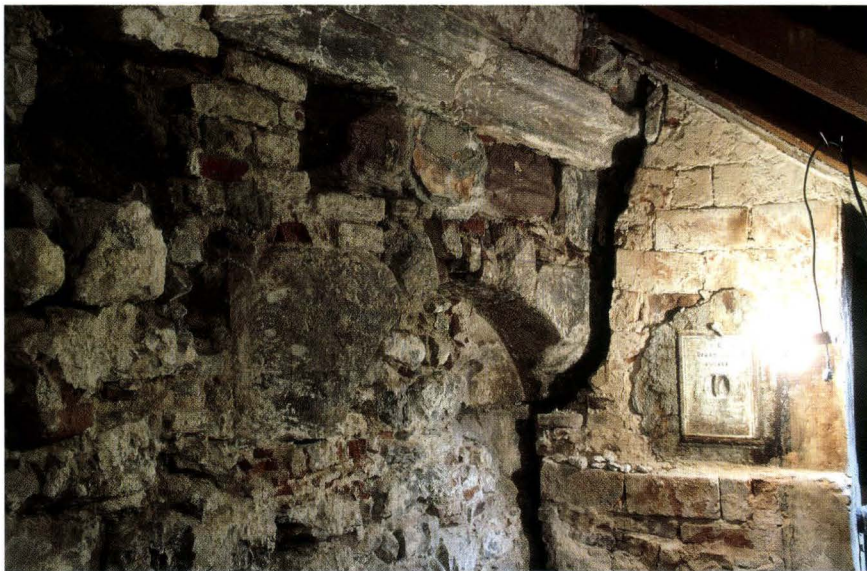
Abb. 16 Rheinsprung 8 und 10, Stützmauer der Martinskirche (2003/346 und 2003/443). Blick auf die Blendarkade und das Gurtgesims östlich des Erkers (im Dachraum von Rheinsprung 10). Der Kamin verdeckt den Blindbogen auf der rechten Seite. Der Kamin wurde 2005 abgebrochen. Die beiden Bogen weisen Spuren starker Verwitterung auf, ein Hinweis dafür, dass dieser Mauerbereich ursprünglich dem Wetter ausgesetzt war. Die den Scheitel bildenden Steine des linken Bogens bestehen aus später eingeflickten Backsteinen. Der Blindbogen rechts scheint intakt zu sein. Die von links kommende Stützmauer passt nicht zum Bogenansatz (Bildmitte). Eine Aufpolsterung verdeckt dessen 25 cm tiefer liegende Rückwand, die mit der Aussenseite des Anfangssteins aus einem einzigen Sandsteinblock gemeisselt ist. Es scheint, dass die Stützmauer nachträglich an die Bogenarkade gebaut wurde. Möglicherweise tradiert die Blendarkade die Ausrichtung einer älteren Stützmauer. – Foto: Basler Denkmalpflege (1995).
