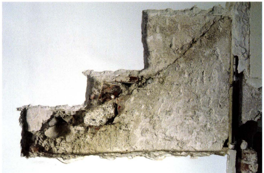
Abb. 6 Lindenberg 12 (2004/339). 2. OG, lindenbergseitiger Gebäudeabschnitt. Erkennbar ist die Dachlinie der lindenbergseitigen Giebelmauer von Haus A (Aussenseite). Die Mauer schliesst oben mit einer zur hinteren Gebäudeseite hin geneigten Fläche ab. – Foto: Basler Denkmalpflege.
