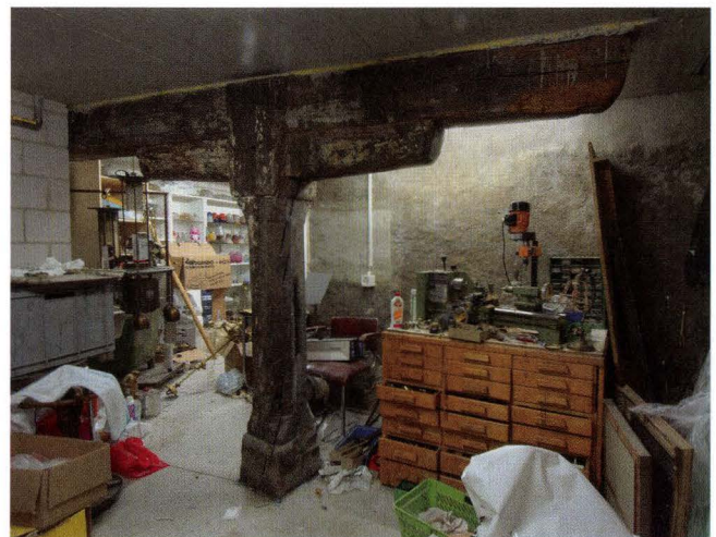
Abb. 25 Spalenvorstadt 25 (2004/248). Keller. Gotische Säule von 1506 mit ausladendem Sattelholz. Fälljahr des Holzes für den Unterzug: 1489. Allem Anschein nach wurden die Hölzer im nachträglich erstellten Keller wiederverwendet. – Foto: Basler Denkmalpflege, Matthias Merki.
