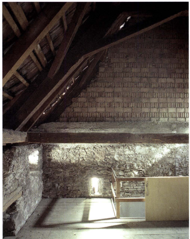
Abb. 7 Rössligasse 12 (2005/821). Innenansicht der östlichen Giebelwand. Unten links eine der schlitzförmigen Lüftungsöffnungen; oben die Vermauerung des früher verbretterten Giebeldreiecks. – Foto: Basler Denkmalpflege.
