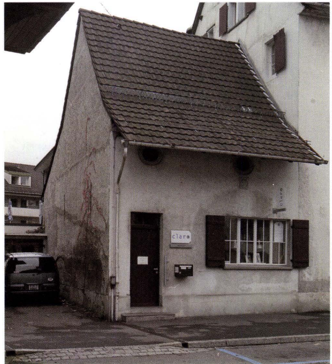
Abb. 5 Rössligasse 12 (2005/821). Heutige Ansicht des Baukörpers von der Strasse her. – Foto: Basler Denkmalpflege.
