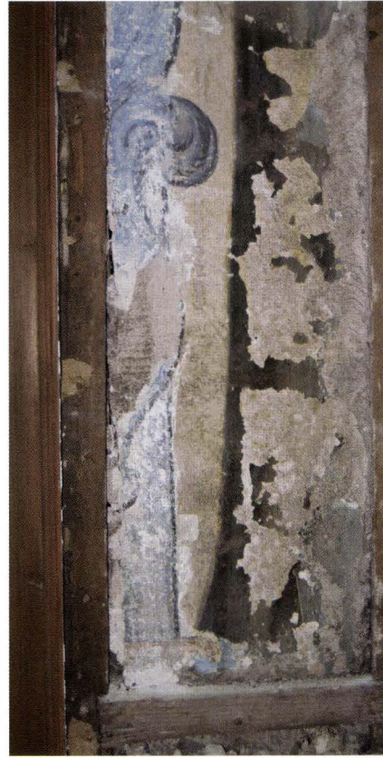
Abb. 33 Lindenberg 12 (2004/339). 1. OG, rheinseitiger Gebäudeabschnitt (Stube). Freigelegter Ausschnitt der ältesten, polychromen Malerei an der massiven Binnenwand. Neben der Türleibung ist eine Säule mit Basis erkennbar. – Foto: Basler Denkmalpflege.
