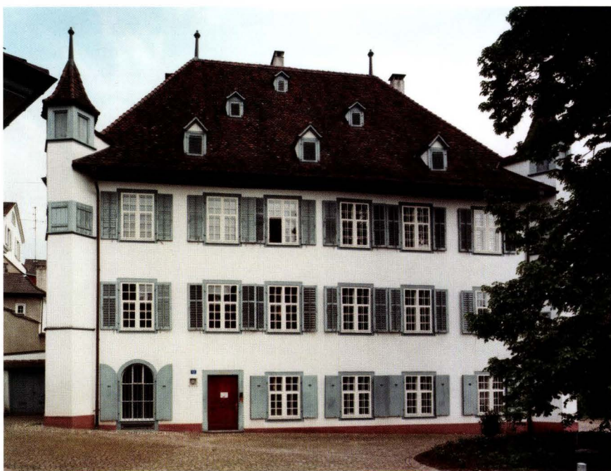
Abb. 3 Lindenberg 12 (2004/339). Nordwestliche Längs- bzw. Vorderseite des Gebäudes. Zustand nach dem aktuellen Umbau. – Archiv Basler Denkmalpflege. Foto: Erik Schmidt.
