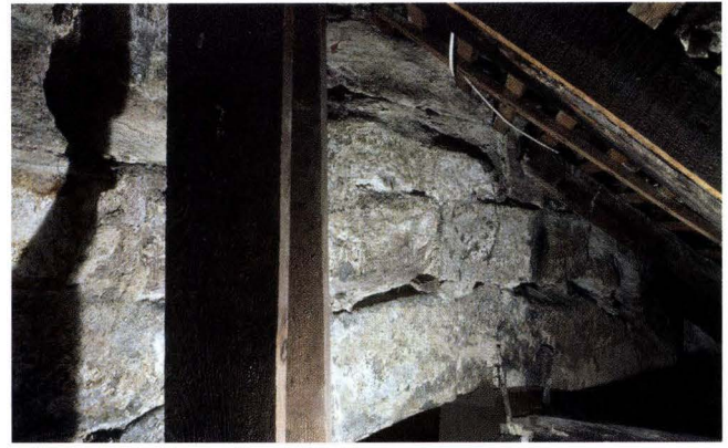
Abb. 5 Rheinsprung 8 und 10, Stützmauer der Martinskirche (2003/346 und 2003/443). Blick im Dachgeschoss von Rheinsprung 10 auf den Scheitel des östlichen Gewölbebogens unterhalb des Erkers. Die Sandsteinkuben sind sorgfältig gefügt. Fast alle weisen Zangenlöcher auf. – Foto: Basler Denkmalpflege (1995).
