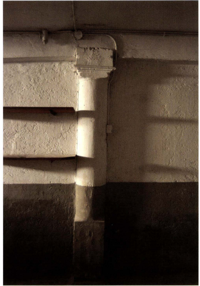
Abb. 9 Nadelberg 7 (2005/889). Unterzug mit hölzernem Mittelpfosten im südlichen EG. Die Konstruktion ist heute in die nördliche Wand der Garage eingebaut. Blick gegen Norden. – Foto: Basler Denkmalpflege.
