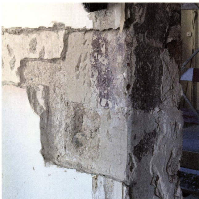
Abb. 15 Lindenberg 12 (2004/339). 2. OG, lindenbergseitiger Gebäudeabschnitt. Im Giebelndreieck von Haus A wurde eine bereits sekundär angelegte Maueröffnung mehrfach abgeändert. Die Leibung der ältesten Öffnung wurde mit gipshaltigem Mörtel geformt (unten). Später wurde diese Leibung stark überarbeitet, verputzt und rot gestrichen (oben). – Foto: Basler Denkmalpflege.
