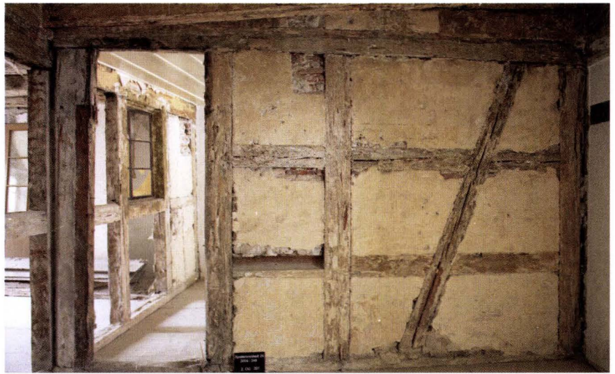
Abb. 17 Spalenvorstadt 25 (2004/248). 2. Obergeschoss. Leicht diagonal stehende Fachwerkwand in der Hausmitte. Ansicht der Ostseite. Ursprünglich setzte sich die Wand zum Hof hin (also nach links) fort: Der linke Türpfosten ist auch auf seiner linken Seite – wo die jüngere Fachwerk- wand anschliesst – abgefast. Dies zeigt, dass sich ursprünglich auch auf dieser Seite eine Türöffnung befand. Das Rähm der Wand senkt sich nach rechts (gegen die Strasse) gegenüber den Bundbalken resp. Boden- brettern des 1. Dachgeschosses leicht ab. Die Ausfachungen sind sekundär und identisch mit jenen der jüngeren Raumteilung des 17. Jahrhunderts. – Foto: Basler Denkmalpflege, Matthias Merki.
