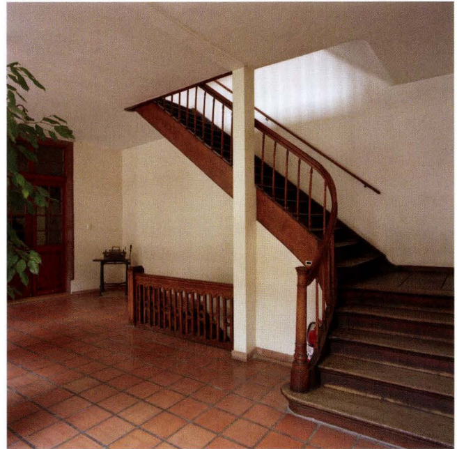
Abb. 21 St. Johannis-Vorstadt 15/17, Sant Christoffel / Erlacherhof (2003/280). Haus Nr. 17, südlicher Flügelanbau, Halle im 1. Obergeschoss. Das Brüstungsgeländer gehört zu der klassizistischen Treppe vom Erdgeschoss ins 1. OG, die Christian von Mechel einbauen liess. Die Treppe ins 2. OG ist biedermeierlich und entstand mit der Aufstockung des Flügelbaus. – Foto: Bruno Thüring.
