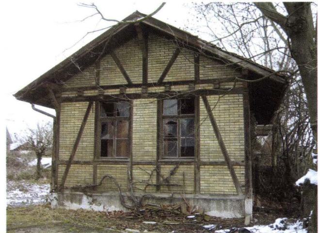
Abb. 7 Äussere Baselstrasse 387, Riehen – Bäumlhof (2005/87). Südliche Giebelfassade des Ökonomiebaus. Fachwerkteilung und Befensterung sind streng symmetrisch angeordnet. – Foto: Basler Denkmalpflege.
