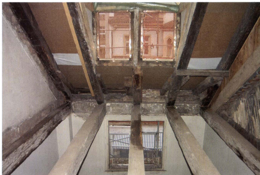
Abb. 10 Gerbergasse 63 (2005/725). Blick ins Dachwerk und an den Dachfuss an der Falknerstrasse. Die später angebrachten Aufschieblinge liegen auf einem zum Dachwerk sekundären Schwellbalken, welcher hier auf den Dachbalken aufliegt. – Foto: Basler Denkmalpflege.
