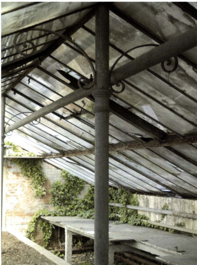
Abb. 11 Äussere Baselstrasse 387, Riehen – Bäumlihof (2005/87). Detailgestaltung der gusseisernen Firstständer. – Foto: Basler Denkmalpflege.
