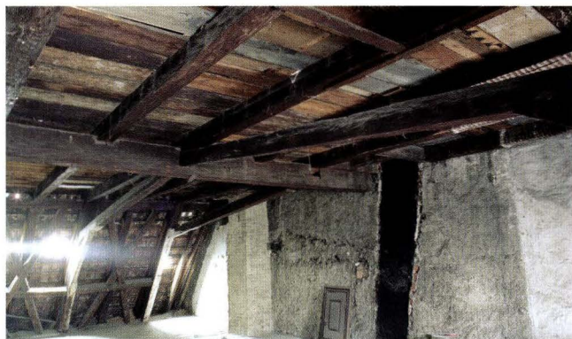
Abb. 19 Spalenvorstadt 25 (2004/248). 1. Dachgeschoss, Blick gegen die Westbrandmauer und die Hofseite. Liegender Stuhl aus der 1. Hälfte des 17. Jahrhunderts. In den Unterzug sind zwei ansteigende Spannriegel eingezapft. – Foto: Basler Denkmalpflege, Matthias Merki.
