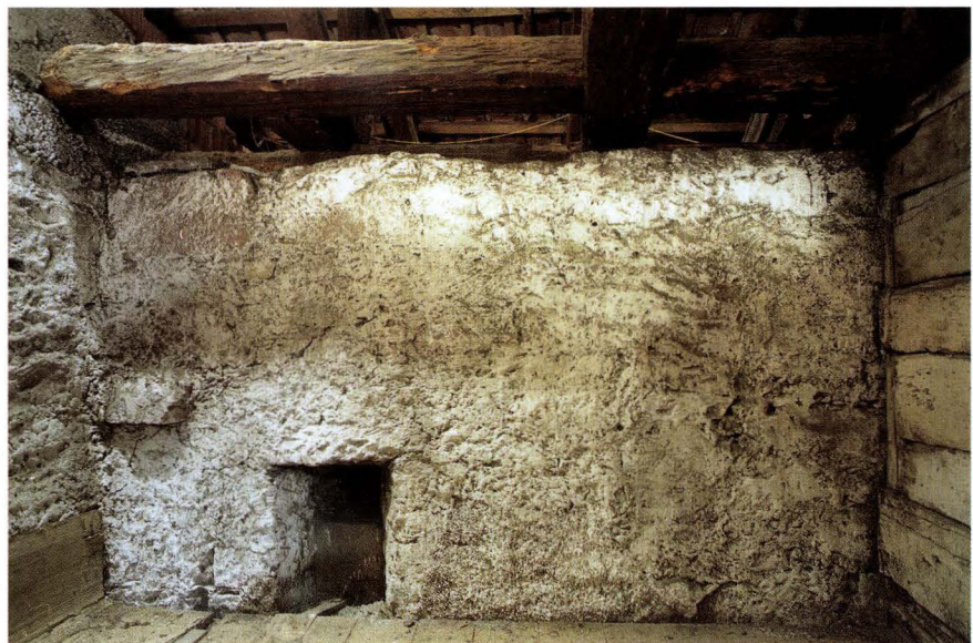
Abb. 8 Rössligasse 12 (2005/821). Innenansicht der hofseitigen ehemaligen Aussenmauer im Dachgeschoss. Links eine der schlitzförmigen Lüftungsöffnungen; oben der Wechsel zum hofseitigen Dachfuss des ursprünglichen Dachs. – Foto: Basler Denkmalpflege.
