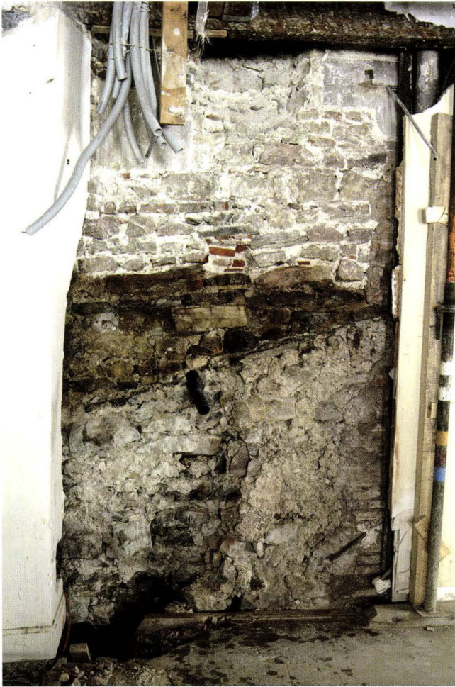
Abb. 10 Rittergasse 12 (2003/27). Südbrandmauer im 2. OG von Haus Nr. 12 während der Freilegung. Hier kam die nördliche Seitenmauer des mittleren Kernbaus mit nach hinten ansteigender Dachlinie (18 Grad Neigung) zum Vorschein. Mauerwerk aus unterschiedlich grossen Kalkbruchsteinen, teils Sandsteine. Der bräunliche, grobkiesige Mauermörtel überzieht die Mauerfugen und partienweise die Steinköpfe. Über der Dachlinie haben sich zwei weitere Bauphasen (Aufmauerungen) erhalten. – Foto: Basler Denkmalpflege.
