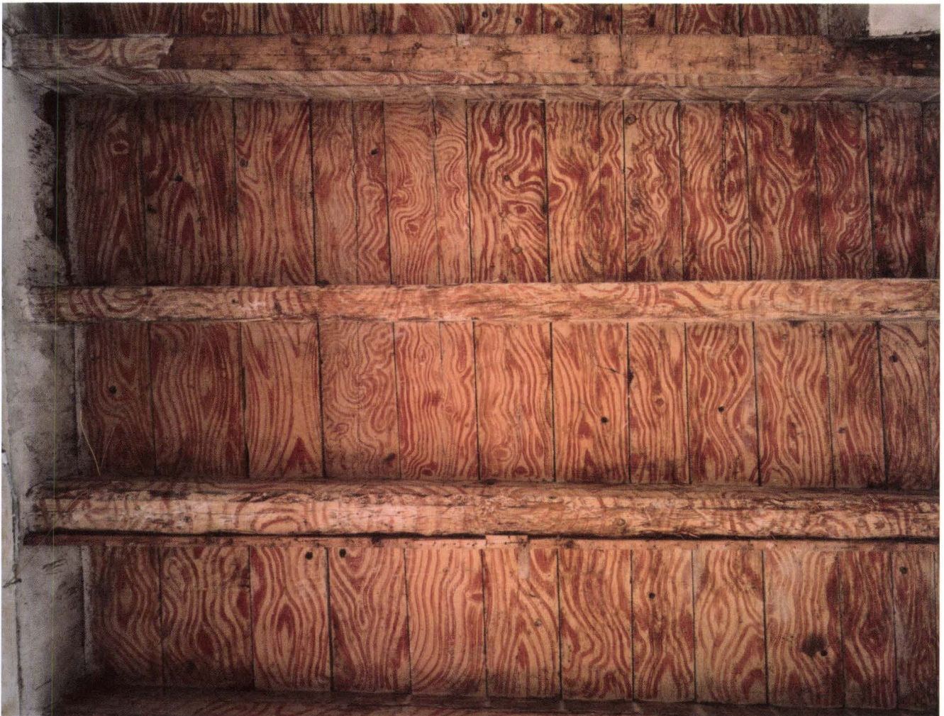
Abb. 29 Lindenberg 12 (2004/339). 1. OG, lindenbergseitiger Gebäudeabschnitt. Deckenbemalung mit roter, auf den gelben Grund gesetzter Maserierung. Ungewöhnlich ist das Fehlen von geometrischen Rahmen oder Bändern (wohl um 1560). – Archiv Basler Denkmalpflege. Foto: Erik Schmidt.
