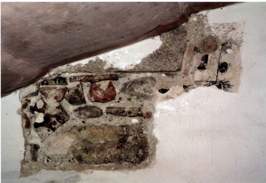
Abb. 22 Lindenberg 12 (2004/339). EG, Treppenturm, hintere Turmmauer. Die Blockstufen der Spindelstiege sind ins Mauerwerk des Vorgängerbaus eingeflickt. Die Fassung mit Rotband, Bollenband und Pfauenaugen, welche in die Turmmauern eingebundene Blockstufen begleitete, bezieht sich möglicherweise auf eine erste, hölzerne Stufenkonstruktion. Die bestehenden Stufen aus Stein wurden später an der Unterseite überarbeitet. – Foto: Basler Denkmalpflege.
