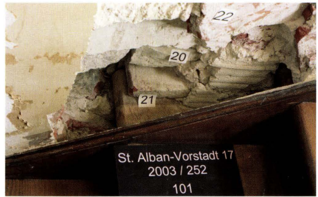
Abb. 10 St. Alban-Vorstadt 17 – Zum Geist (2003/252). Erstes Obergeschoss, erster Treppenlauf. 20: Ehemalige Brandmauer. 21: eingebrochener Eichentritt mit Einbaumaterial (hier eine Tonplatte). 22: Verpolsterung. – Foto: Basler Denkmalpflege, Matthias Merki.
