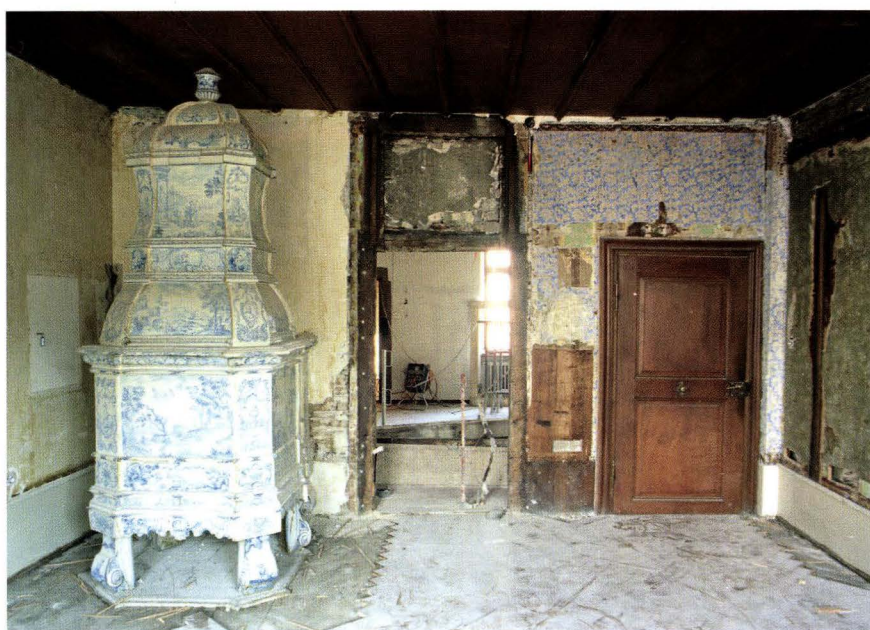
Abb. 31 Lindenberg 12 (2004/339). 1. OG, rheinseitiger Gebäudeabschnitt (Stube). Die hintere und die rheinseitige Trennwand (Mitte und rechts) wurden beim Einbau um 1560 bis auf einen massiv ausgeführten Teil hinter dem Ofen getäfelt. Die Tür in der hinteren Wand wurde 1963 von der Raummitte nach rechts versetzt. An der rheinseitigen Wand (rechts) sind die Bretter der Täfelung nicht mehr in ihrer ursprünglichen Lage. Der Kachelofen von 1760 ersetzte einen älteren Ofen. Die Täfelung trägt mehrere Schichten von Tapeten aus dem 19. Jahrhundert. – Foto: Basler Denkmalpflege.
