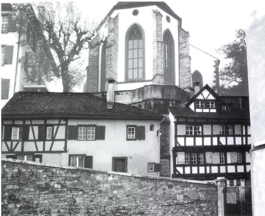
Abb. 3 Rheinsprung 8 und 10, Stützmauer der Martinskirche (2003/346 und 2003/443). Blick von Nordosten auf den Chor und die Stützmauer der Martinskirche. An die Stützmauer angebaut sind seit dem frühen 15. Jahrhundert die schmalen Häuser am Rheinsprung 10 (links) und 8 (rechts). Der die beiden Fachwerkhäuser trennende Wandpfeiler trägt den vorspringenden Erker. – Foto: Erik Schmidt (1995).
