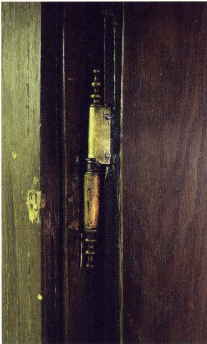
Abb. 27/28 Spalenvorstadt 25 (2004/248). 1. Obergeschoss. Details der Eichentüre von der Küche in die strassenseitige Stube aus dem 18. Jahrhundert. Beschläge aus Bronze oder Messing: Fischbänder als Scharniere, Knauf, Klinke und Schlüsselschild zum Kastenschloss auf der Stubenseite der Türe. – Foto: Basler Denkmalpflege.
