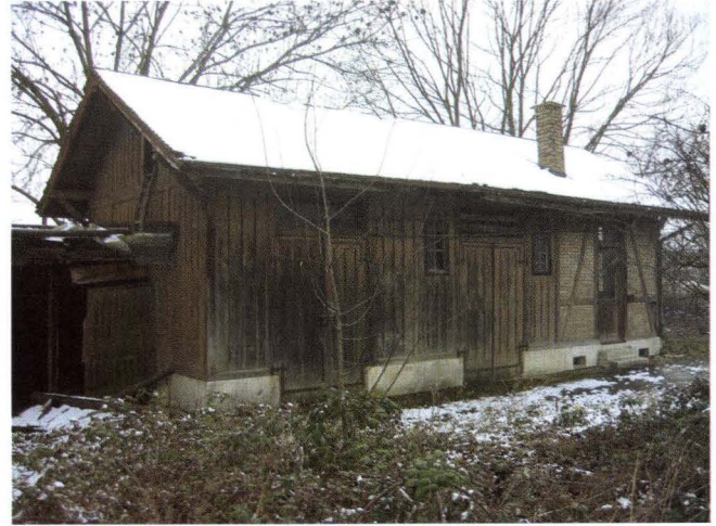
Abb. 6 Äussere Baselstrasse 387, Riehen – Bäumlhof (2005/87). Der Ökonomiebau mit verbrettertem Scheunenteil und davon abgetrenntem Eckraum. Dieser wird von mit Backstein gefülltem Fachwerk umschlossen. Dieses schön gestaltete Gärtnerreigebäude soll als einziges auf dem Areal erhalten werden. – Foto: Basler Denkmalpflege.
