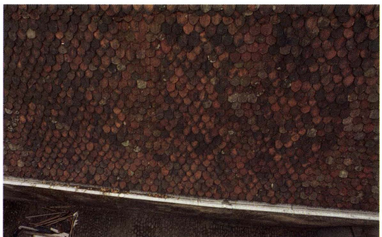
Abb. 5 Nadelberg 7 (2005/889). Blick vom Dachgeschoss auf das Dach des Gebäudes Nadelberg 11A und in das zwischen den Häusern Nadelberg 7 und 11A liegende Gässlein. – Foto: Basler Denkmalpflege.
