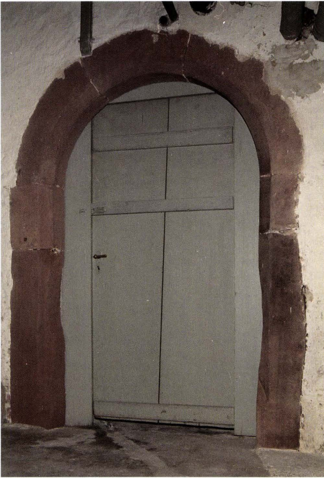
Abb. 8 Nadelberg 7 (2005/889). Zugang vom talseitigen in den strassenseitigen Keller. Steinerne Türrahmen mit Rundbogen und abgesetzter Fase. Blick gegen den strassenseitigen Keller. – Foto: Basler Denkmalpflege.
