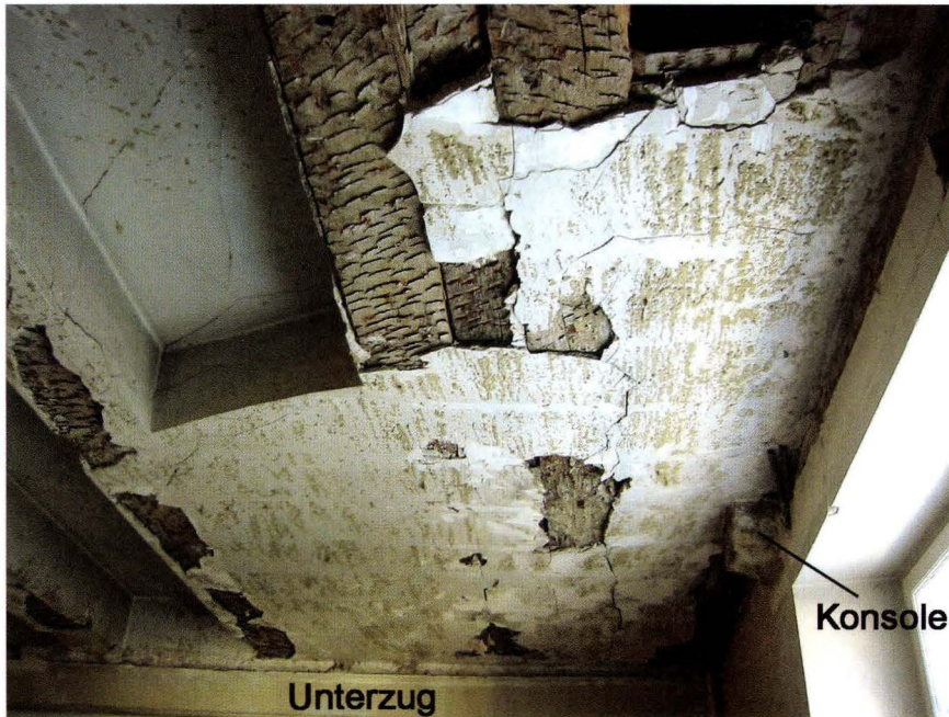
Abb. 31 Rittergasse 12 (2003/27). Ausschnitt aus der Balkendecke in Haus Nr. 12 im 2. OG mit barocker Balkenvergipsung. An dieser Stelle an der Wand zur Bäumleingasse läuft die Vergipsung flach über drei nahe beieinander liegende Balken, von denen einer leicht diagonal verlegt wurde. Ferner sitzt eine Konsole als Balkenaufgabe in der Wand zur Bäumleingasse. Es handelt sich wohl um eine abgeänderte Konstruktion, die nachträglich überputzt wurde. – Foto: Basler Denkmalpflege.
