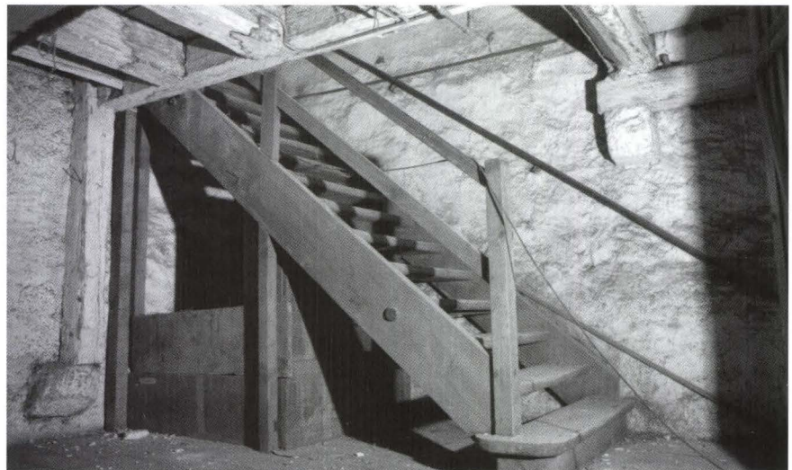
Abb. 10 Rheinsprung 20 (2005/13). Keller unter dem Nordhaus. Die Wangentreppe erschliesst den oberen Keller. Sie ersetzt einen älteren Kellerabgang, der südlich der Mittelachse von der Hofseite über einen Kellerhals hinab führte. Die dendrochronologisch nach 1357 datierten Deckenbalken liegen seitlich auf Streifbalken und in der Mitte auf einem Unterzug. Ca. auf der Flucht des unteren Treppentritts zeigt sich im Mauerwerk ein markanter Knick in der Flucht sowie eine auffallende Ausbuchtung, was auf eine ältere Bauzäsur zurück zu führen ist. – Foto: Basler Denkmalpflege.
