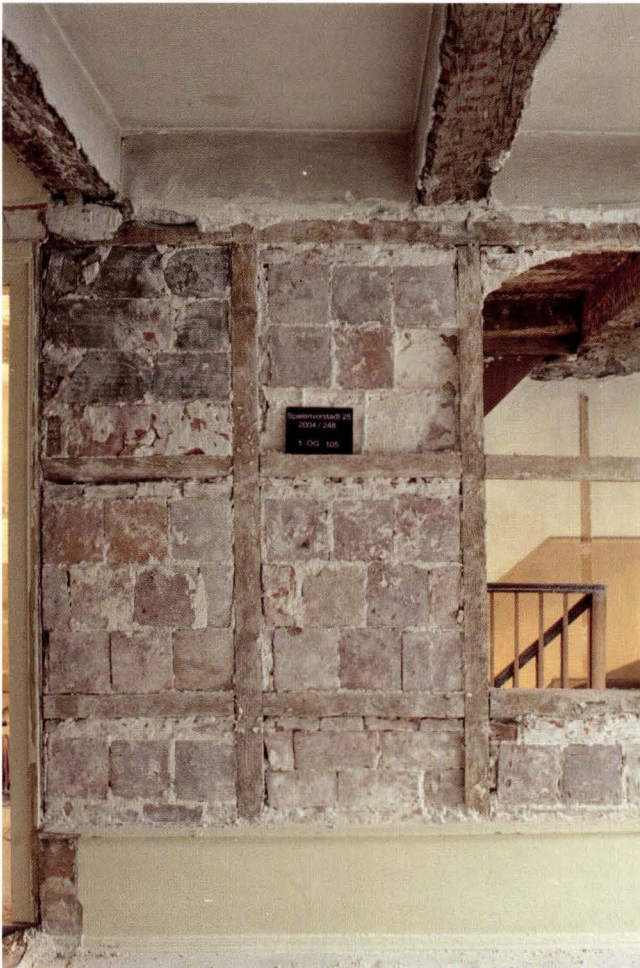
Abb. 30 Spalenvorstadt 25 (2004/248). 1. Obergeschoss, Hausmitte. Dünne Trennwand des 19. Jahrhunderts zwischen dem Treppenhaus und den Räumen gegen die Westbrandmauer. Zur Ausfachung dienten hochgestellte alte Tonplatten, die offensichtlich von den Zimmerböden stammen und wieder verwendet wurden. – Foto: Basler Denkmalpflege, Matthias Merki.
