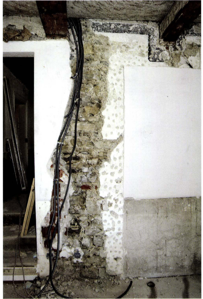
Abb. 21 Rittergasse 12 (2003/27). Mauerbefund an der Südbrandmauer in Haus Nr. 14 zu Haus Nr. 16, rund 7 m vor der ehem. Front des rückwärtigen Kernbaus. Das Mauerwerk passt zum Mauerbefund, der im direkten Anstoss an die Kernbauecke erfasst wurde (s. Abb. 20). Stellenweise hat sich Originalverputz erhalten. Der Mauercharakter verweist ins 14. Jahrhundert. Über der Maueroberfläche liegen die Verputzschichten der späteren Ausbauphasen. Die Graubandumrahmung der Deckenbalken mit perspektivischer Randfassung gehört zur Maserierungs-Bemalung der darüberliegenden Decke und stammt wohl aus dem späten 16. Jahrhundert (s. Abb. 27). – Foto: Basler Denkmalpflege.
