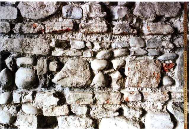
Abb. 6 Spalenberg 29 (2004/478). Nahaufnahme der Westbrandmauer im 3. Obergeschoss nächst der Südwestecke. Deutlich sind zwei Zeilen quer vermauerter Backsteine zu erkennen; dazwischen sind kleinformatige Wacken- und Bruchsteine aufgemauert. Die Sondierstelle musste vor der Aufnahme von einer Schicht Zementmörtel befreit werden. – Foto: Basler Denkmalpflege.
