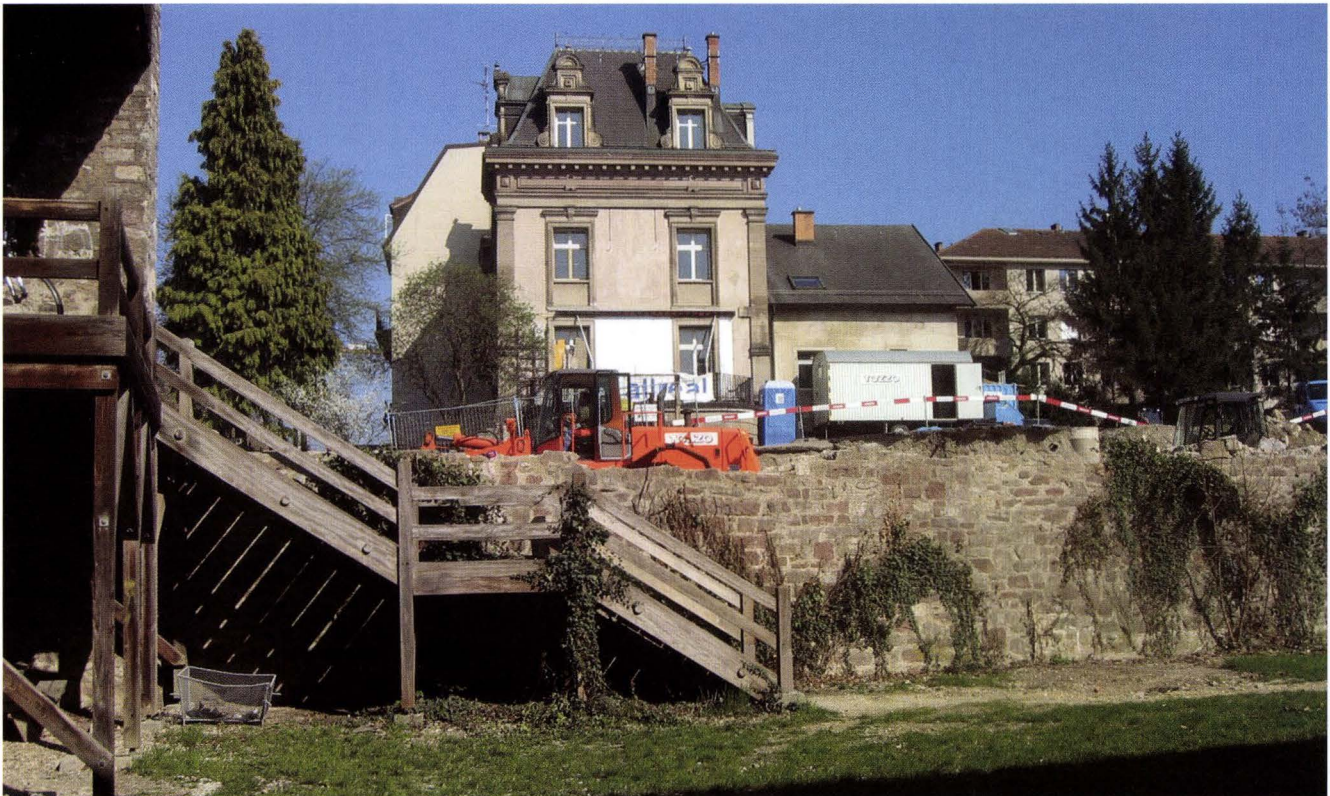
Abb. 3 Mühlegraben (2005/20). Ansicht der Fabrikantenvilla von 1898. Aufnahme nach dem Abbruch der Fabrikbauten aus dem 19. Jahrhundert. Deren grabenseitige Fassaden wurden bis auf die Höhe der Kontermauer abgetragen. Links angeschnitten der barocke Kopfbau der Wehranlage, der Letziturm. – Foto: Basler Denkmalpflege.
