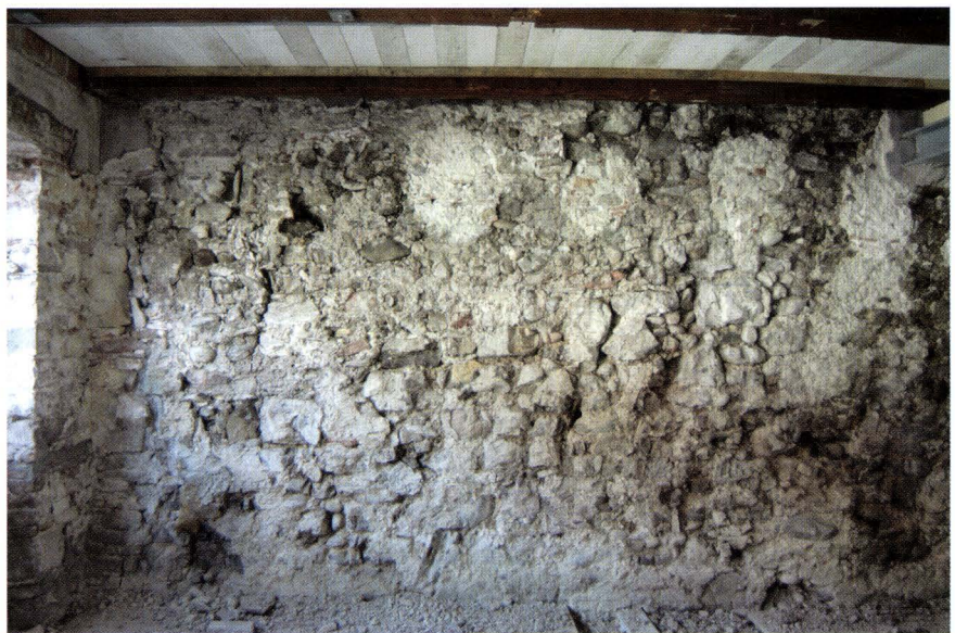
Abb. 5 Spalenvorstadt 25 (2004/248). Die Ostbrandmauer im 2. Obergeschoss im strassenseitigen Raum. Im untern Bereich erkennt man den originalen Teil («Kernmauer»), dessen Abbruchkante nach rechts bis auf die Höhe der zugemauerten Balkenlöcher der 2. Bauphase ansteigt. Links die Nordostecke mit der Fassade von 1815, deren Material ein kleines Stück weit in die Brandmauer hineingreift. – Foto: Basler Denkmalpflege, Matthias Aebersold.
