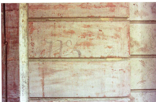
Abb. 15 St. Johanns-Vorstadt 15/17, Sant Christoffel / Erlacherhof (2003/280). Haus Nr. 17: alte Hausnummer N° 53. Beim Entfernen der Anstriche kam auf der untersten Malschicht diese Nummer zum Vorschein. Sie wird unten durch eine der Relief-Fugen angeschnitten, was beweist, dass diese sekundär sind. – Foto: Basler Denkmalpflege.
