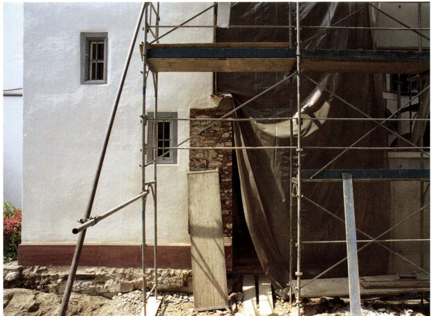
Abb. 16 Lindenberg 12 (2004/339). EG, Aussenansicht der hinteren Turmmauer. Die ältere Substanz in der hinteren Turmmauer zieht an der lindenbergseitig den Turm abschliessenden Mauer vorbei. Das sich ausserhalb des Turms fortsetzende Mauerwerk war bis 2004 in einen teilweise neuzeitlichen Baukörper eingebunden. – Foto: Basler Denkmalpflege.
