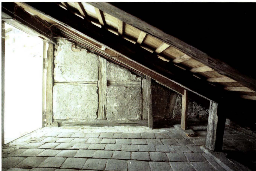
Abb. 14 Nadelberg 7 (2005/889). Ansicht der Fachwerk-Binnenwand in der talseitigen Dachschräge, welche ursprünglich in der Seitenwand einer Lukarne ihre Fortsetzung fand. Unten der Rest des einst das gesamte Dachgeschoss bedeckenden Tonplattenbodens in der Südost-Ecke des Gebäudes. Blick gegen Norden. – Foto: Basler Denkmalpflege.
