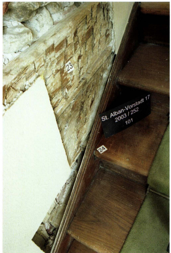
Abb. 11 St. Alban-Vorstadt 17 – Zum Geist (2003/252). Erstes Obergeschoss, dritter Treppenlauf, an der Ostwand des Treppenhauses. Diese ist eine Fachwerkkonstruktion, welche im Erdgeschoss die Westwand der Durchfahrt bildet. 23: Schwellbalken, der bereits zum zweiten Obergeschoss gehört. Zwischen dem Rähm des ersten Obergeschosses und dem Schwellbalken sieht man die Stirnseiten der Bohlen des angrenzenden Raumes. – Foto: Basler Denkmalpflege, Matthias Merki.
