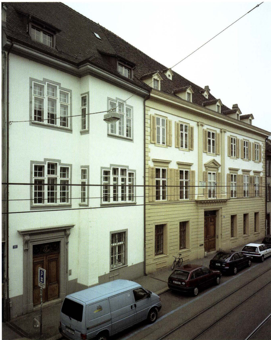
Abb. 1 St. Johannis-Vorstadt 15/17, Sant Christoffel / Erlacherhof (2003/280). Die Strassenfassaden von Nr. 15, Sant Christoffel (links) und des Erlacherhofs. Zustand nach der Renovation 2004. Am Mauerversatz mit bis ins 1. Obergeschoss reichendem Strebe Pfeiler beim Sant Christoffel kann man die ursprüngliche Parzellierung schön ablesen. Alte Hausnamen und ein als Spolie gefundener Grenzstein belegen, dass hier die Grenze zwischen den Pfarrsprengeln von St. Peter und der Johanniterkapelle verlief. – Auch beim Erlacherhof kann man an der asymmetrischen Axialität ablesen, dass sich das Gebäude über ursprünglich drei Parzellen erstreckt. – Foto: Erik Schmidt.
