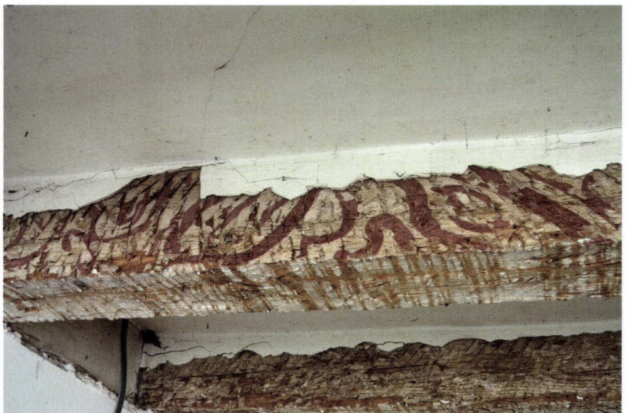
Abb. 27 Rittergasse 12 (2003/27). Maserierungsmalerei an den Deckenbalken des Hauses Nr. 14 im strassenseitigen Raum. Auf weisslicher Grundierung sind in braunroter Farbe grobe Schlaufen mit 2 bis 5 cm breiten Strichen gemalt. Die Balkenkanten sind nicht gefasst. Die Unterseiten der Deckenbalken wurden für die später untergehängte Gipsdecke abgebeilt. – Foto: Basler Denkmalpflege.
