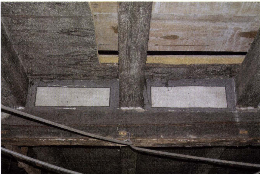
Abb. 28 Lindenberg 12 (2004/339). 2. OG, mittlerer Gebäudeabschnitt. Die zwischen den Dachbalken geschlossenen Balkenfelder über dem rückseitigen Unterzug sind mit Graubändern umrahmt. Die Balken und Dachbodenbretter sind mit einer weissen Spritzmarmorierung auf grauem Grund geschmückt (16. Jahrhun- dert). – Foto: Basler Denkmalpflege.
