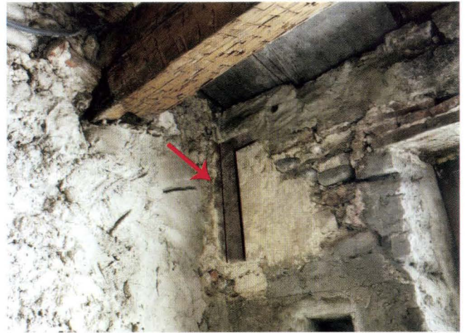
Abb. 10 Spalenberg 29 (2004/478). Südostecke im 3. OG. Die Mauern sind durch Zementauftrag unkenntlich. Die freigelegten Flächen zeigen, dass die Ostbrandmauer (links) mit der Rückfassade über Eck verbunden ist. Die Deckenbalken sind jüngere Einbauten. Das Verputzfragment mit Resten von Graubandmalerei (im Bild graphisch verstärkt) ist über Eck geführt. Die im Bild sichtbare Fensternische stammt aus späterer Zeit. Die kleine Wandnische (am unteren Bildrand) wurde nicht untersucht. – Foto: Basler Denkmalpflege.
