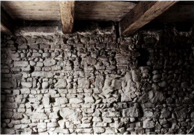
Abb. 5 Spalenberg 29 (2004/478). Westbrandmauer und Rückfassade bilden keinen Eckverband. Vom Restaurator sind zwischen den Balken Verputzreste mit Graubandmalerei gesichert worden. An den Deckenbrettern und -balken sind keine Farben mehr erhalten. Das kleinteilige Mauerbild mit Zwischenlagen von Backsteinen erstreckt sich über die ganze Haustiefe. – Foto: Basler Denkmalpflege.
