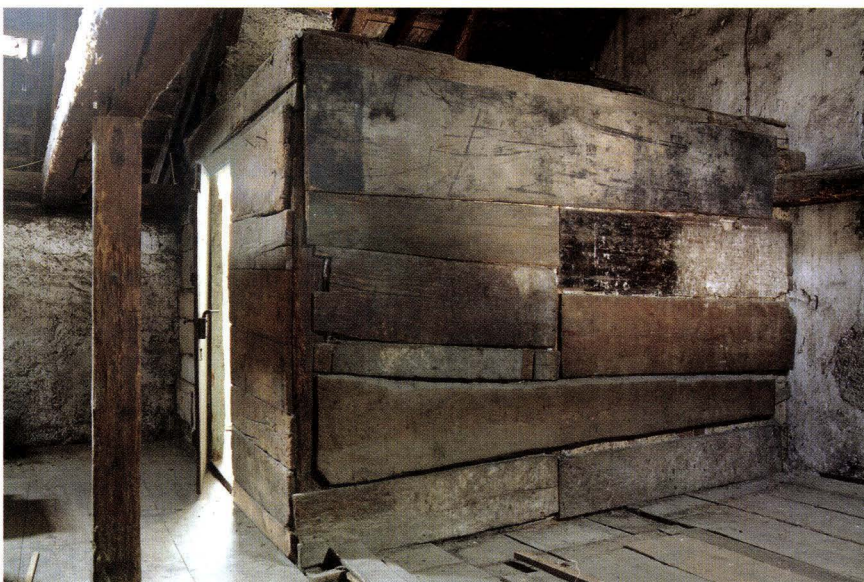
Abb. 13 Rössligasse 12 (2005/821). Blick in den südwestlichen Teil des Dachgeschosses. Die kastenartige Raumtrennung steht auf dem zum Scheunengebäude sekundären heutigen Geschossboden und dürfte bei der Einrichtung der Bäckerei um 1853 eingebaut worden sein. – Foto: Basler Denkmalpflege.
