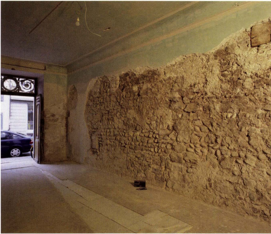
Abb. 6 St. Johannis-Vorstadt 15/17, Sant Christoffel / Erlacherhof (2003/280). Haus Nr. 15. Die Südbrandmauer im Erdgeschoss, ein Mischmauerwerk aus Kieselwacken und Bruchsteinen in Lagen. Das Fehlen von Keramikbruch erlaubt eine Datierung vor das Erdbeben von 1356. – Im Hintergrund sieht man rechts neben dem Gipsrest bei der Ecke in Bodennähe die beinahe quadratische, zugemauerte originale Nische, ganz rechts oben im Bild den Kopf eines eingebrochenen Unterzugbalkens der benachbarten Liegenschaft Nr. 13. Die Vergipsung und Stuckierung mit Kranzprofil, Kehle und Deckenleiste datiert aus dem ausgehenden 18. Jahrhundert. – Foto: Basler Denkmalpflege.
