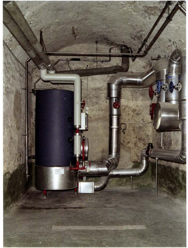
Abb. 7 Nadelberg 7 (2005/889). Der strassenseitige Keller mit Stichtonnengewölbe. Blick gegen Süden. – Foto: Basler Denkmalpflege.
