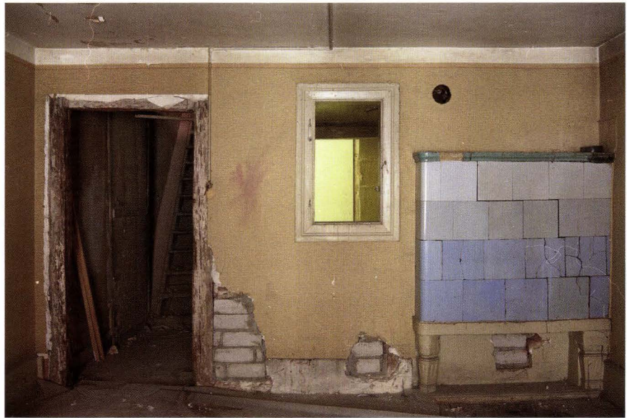
Abb. 7 Gerbergasse 63 (2005/725). Binnenwand zum Zimmer an der Gerbergasse im 3. OG. Kleiner Kachelofen mit blau glasierten Kacheln aus der 1. Hälfte des 19. Jahrhunderts. – Foto: Basler Denkmalpflege.
