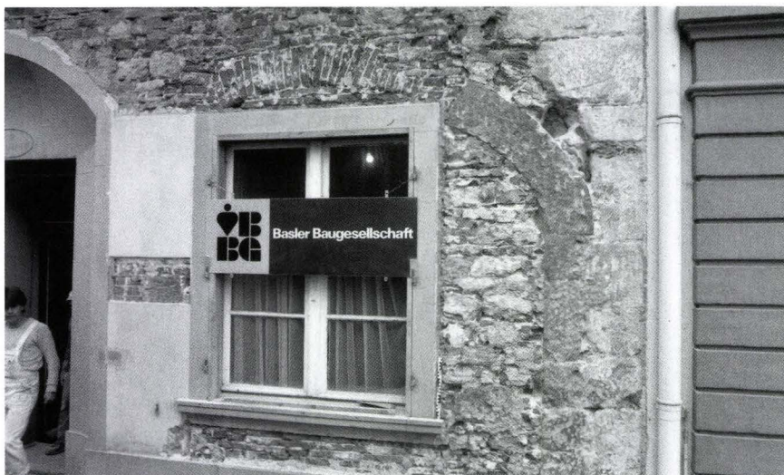
Abb. 5 Rheinsprung 20 (2005/13). Ausschnitt der 1986 freigelegten Strassenfassade in der nördlichen Hälfte. Aus dem Eckmauerverband formen die Sandsteinquader ein grosses Bogentor, dessen Rundbogen sekundär zu einem Korbbogen umgewandelt wurde. Der Verlauf des urspr. Rundbogens zeigt sich im Bogenansatz der obersten Ecksteine. Die linke Hälfte der ehem. Öffnung wird vom bestehenden Fenstereinbau eingenommen. – Foto: Basler Denkmalpflege.
