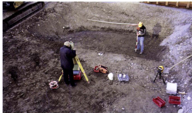
Abb. 7 Lichtstrasse 35, Novartis Bau WSJ-200, 2004/18. Tachymetrische Vermessung der vormodernen Geländetopographie. – Foto: Michael Wenk.
