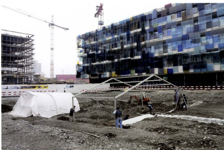
Abb. 9 Lichtstrasse 35, Novartis Bau WSJ-200, 2004/18. Abbau des Zeltes nach der Untersuchung der Fläche für den Pool, vor der eindrucksvollen Fassade des Campus-Neubaus WSJ-204. – Foto: Philippe Wernher.
