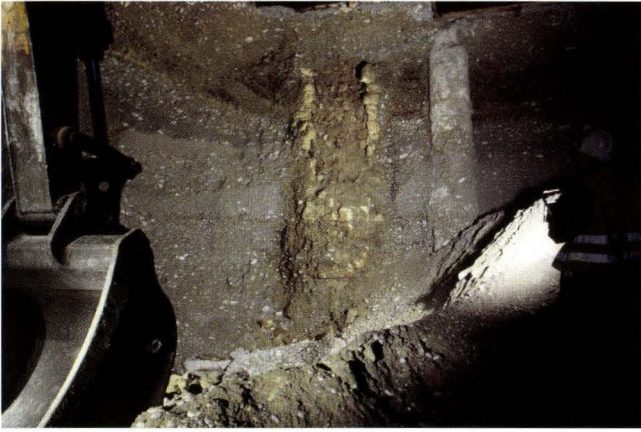
Abb. 45 Voltastrasse (A), TJO Süd, Tunnelbau, 2005/2. Einer der drei neuzeitlichen Brunnenschächte in der Abbaufont des Nordtangenten-Autobahntunnels. – Foto: Michael Wenk.
