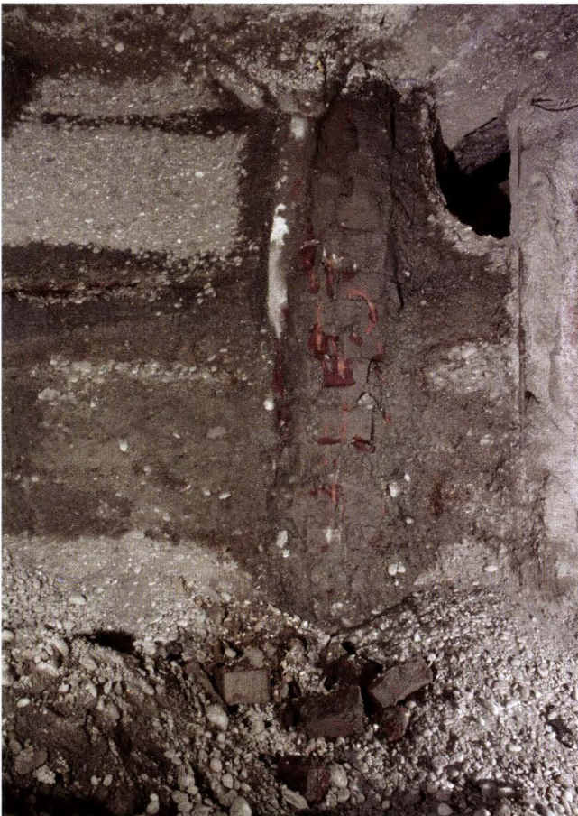
Abb. 46 Voltastrasse (A), TJO Süd, Tunnelbau, 2005/2. Ein neuzeitlicher Brunnenschacht aus rotem Sandstein in der Abbaufont des Nordtangenten-Autobahntunnels. – Foto: Michael Wenk.
