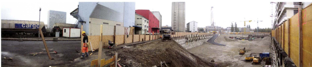
Abb. 25 Fabrikstrasse 40, Novartis Parking Ost, Etappe 6, 2005/6. Blick über den Ostteil der Baugrube für das unterirdische Parking. Im Vordergrund die ehemalige Untersuchungszone von 2005/6. – Foto: Norbert Spichtig.
