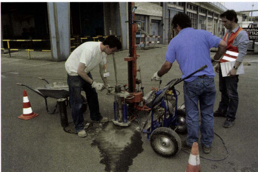
Abb. 29 Fabrikstrasse 40, Novartis Bau WSJ-74, Sondierungen, 2005/8. Einrammen des Bohrgestänges in Strasse D. – Foto: Michael Wenk.
