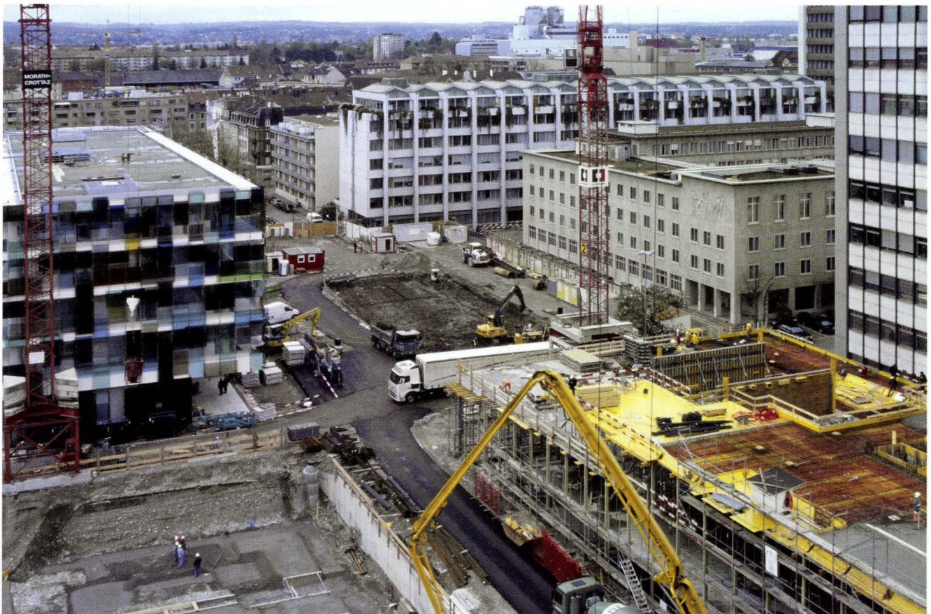
Abb. 4 Lichtstrasse 35, Novartis Bau WSJ-200, 2004/18. Blick auf die teilweise geöffnete Untersuchungszone zwischen den Bauten WSJ-204 (links) und WSJ-200 (rechts). Im Vordergrund Baustellen für zwei weitere Campus-Neubauten. – Foto: Philippe Wernher.
