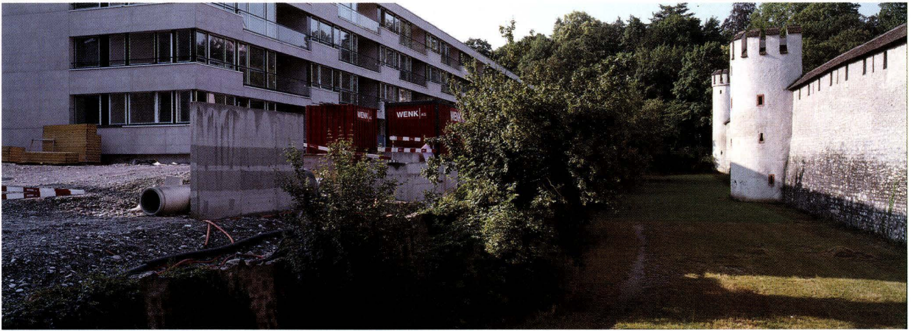
Abb. 10 Stadtmauer mit Kontermauer und Neubauten im Dalbeloch. – Foto: Philippe Saurbeck.
