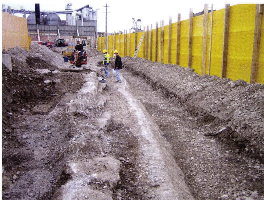
Abb. 10 Rheinhafen St. Johann 1A, Novartis Bau WSJ-187, 2006/53. Blick von Süden auf die Zone ausserhalb des Areals der Novartis AG nach dem maschinellen Voraushub. – Foto: Norbert Spichtig.
