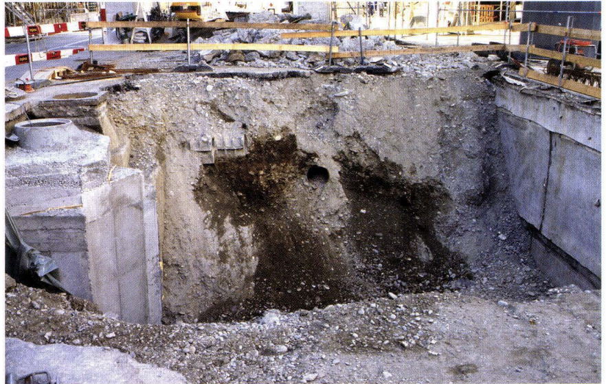
Abb. 12 Hünningerstrasse 35, Novartis, WAS Nordost, 2007/11. Das Bild zeigt die Baugrube Richtung Fabrikstrasse. Der Untergrund war weitgehend modern verfüllt. Vorne links steht schon der neue Abwasserschacht. In der Mitte des Fotos ist das teilweise verschüttete Südprofil mit den bräunlich-gelblichen verlehmteten Hochflut-sanden zu erkennen. – Foto: Adrian Jost.
