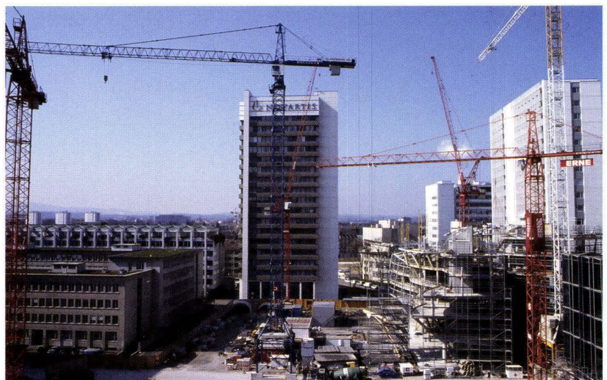
Abb. 13 Hünningerstrasse 84, Novartis, Anlieferung WSJ-242, 2007/13. Das Bild zeigt die Grabung in der Südwest-Ecke des Baufeldes 243. Erkennbar sind die beiden Bogenzelte an der westlichen Bauwand. Dahinter ragt der Bau WSJ-210 in die Höhe. Links des Baufeldes befindet sich das Hauptgebäude der Firma Novartis. Rechts im Bild ist das Bauwerk von Frank Gehry zu erkennen. – Foto: Adrian Jost.
