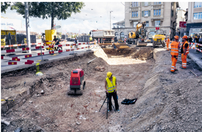
ABB. 28 Parallel zu den Bauarbeiten werden die Mauerreste vermessen. Am linken Bildrand die Kanalisationsmauer, in der Bildmitte die alte Mauerflucht der Häuser Schiffflände 2 und 3. Foto: Sven Billo.
