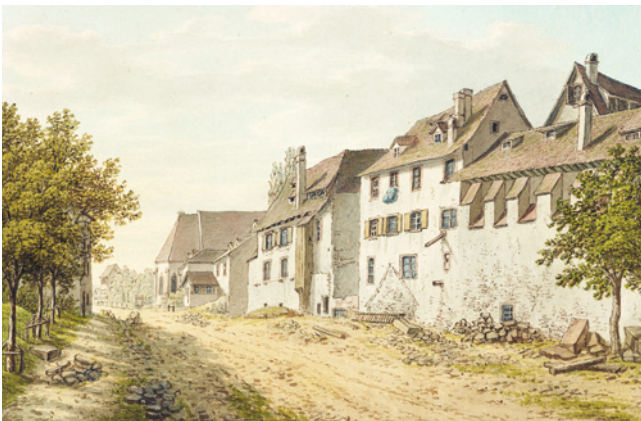
ABB. 11 Das Aquarell von Johann Jakob Schneider zeigt die Umfassungsmauer des Clarakirchhofes, deren Fundamente möglicherweise bei den Grabungen gefunden wurden. Foto: StABS BILD 222.1.
