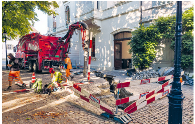
ABB. 5 Der Saugbaggeraushub vor dem Münsterplatz 2–4 konnte an archäologischen Schichten vorbei dirigiert werden. Foto: Fabian Bubendorf.
